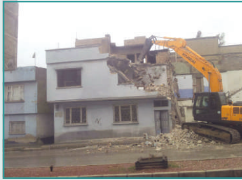
Kentsel Dönüşüm Kapsamında ve Çeşitli Mahallelerde Yapılan Yıkım İşlemleri.
