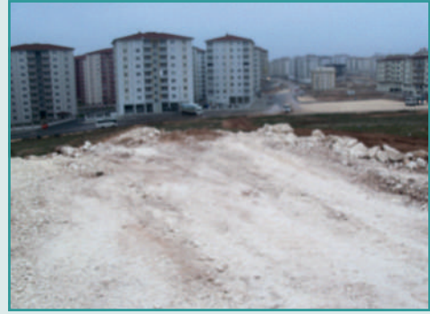
Yol Yapım ve Asfaltlama Çalışmaları
