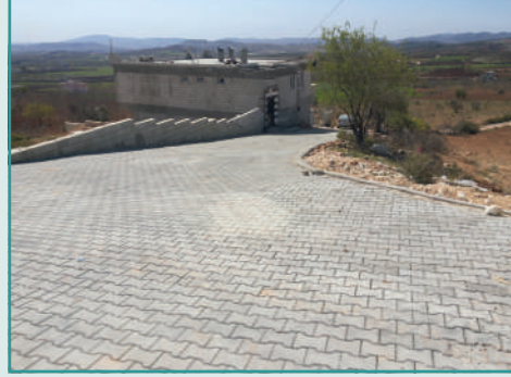
Yol Yapım ve Asfaltlama Çalışmaları
