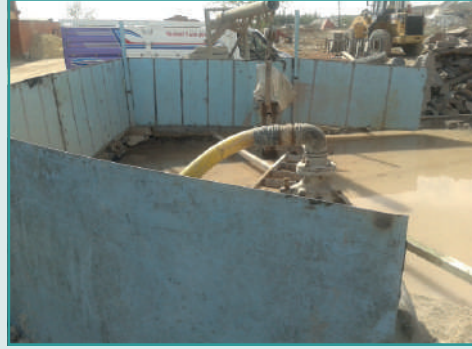
"Atıksu Deşarji" Konulu Şikayete İstinaden Taş-Kırma Eleme Tesisi'nin Sonraki Durumu
