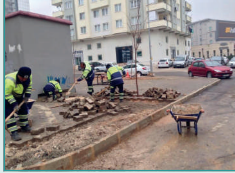
İnşaat Ekibi Çalışmaları
