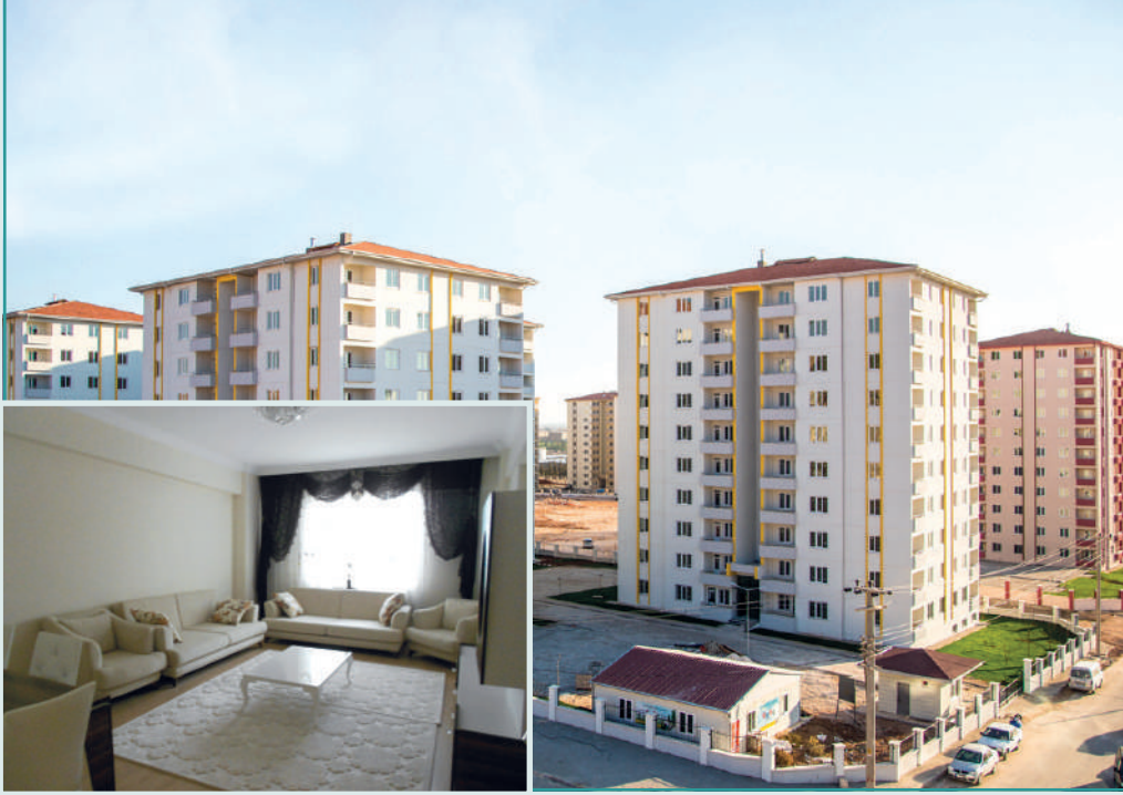
Gazikent Toplu Konut İnşaatları
