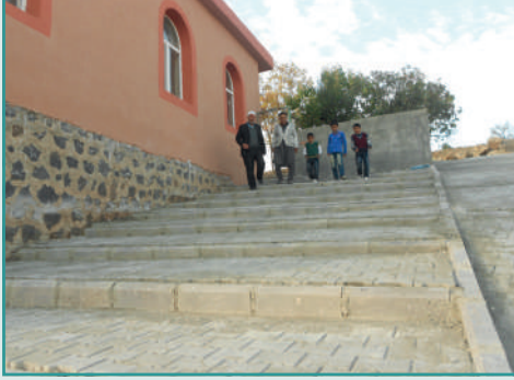
Yol Yapım ve Asfaltlama Çalışmaları
