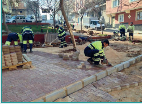
İnşaat Ekibi Çalışmaları
