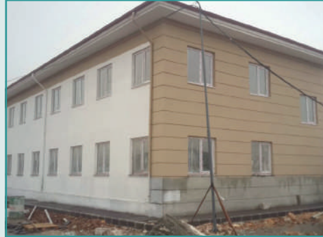
Temizlik İşleri Müdürlüğü İdari Binası İnşaatı
