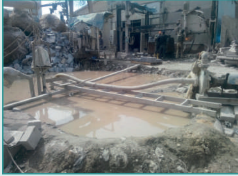
"Atıksu Deşarji" Konulu Şikayete İstinaden Taş-Kırma Eleme Tesisi'nin Önceki Durumu
