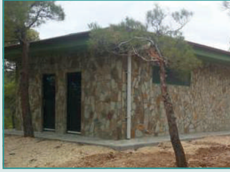
Dülük Baba Tabiat Parkı WC Yapımı
