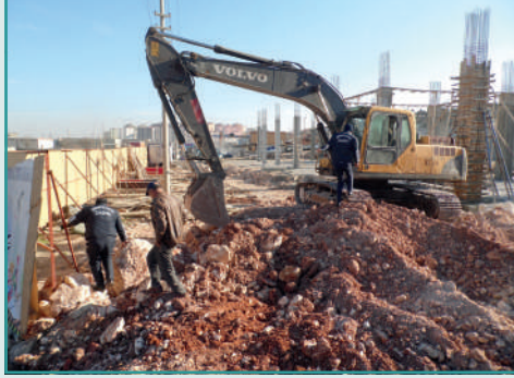
Zabita Ekiplerimizin Kazı, Yapım, Yıkım ve Hafriyatın Önlenmesi Konusunda Yapılan Çalışmalar
