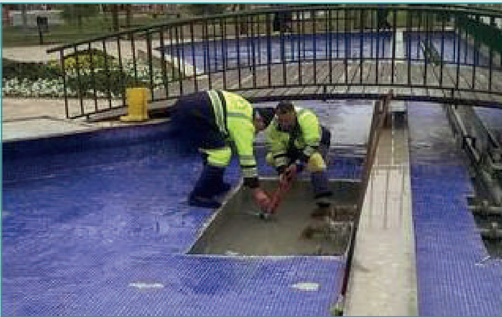
Havuz Tesisatı ve Sulama Sistemi Tamirâtı
