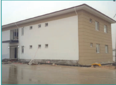
Temizlik İşleri Müdürlüğü İdari Binası İnşaatı
