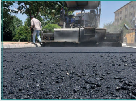
Yol Yapım ve Asfaltlama Çalışmaları
