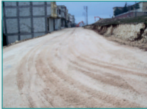
Yol Yapım ve Asfaltlama Çalışmaları
