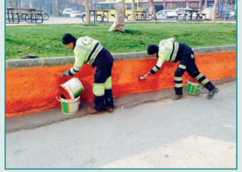
Park Duvarı Boyanması
