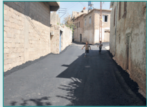
Yol Yapım ve Asfaltlama Çalışmaları
