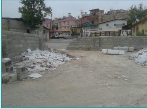
"İnşaat Artıklarının İşgali" Konulu Şikayetine İstinaden Alanın Önceki Durumu
