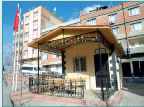
Kayaönü Mahallesi Muhtarlık Hizmet Binası
