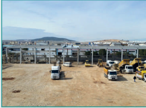
Fen İşleri Müdürlüğü İdari Binası İnşaatı
