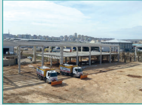
Fen İşleri Müdürlüğü İdari Binası İnşaatı
