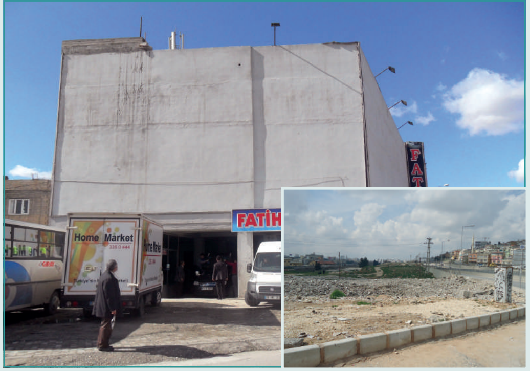
Çakmak Mahallesi'nde Yapılan Kentsel Dönüşüm Çalışmaları
