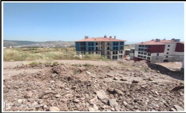
Yol Hattı için Gilen Alanın Durumu
