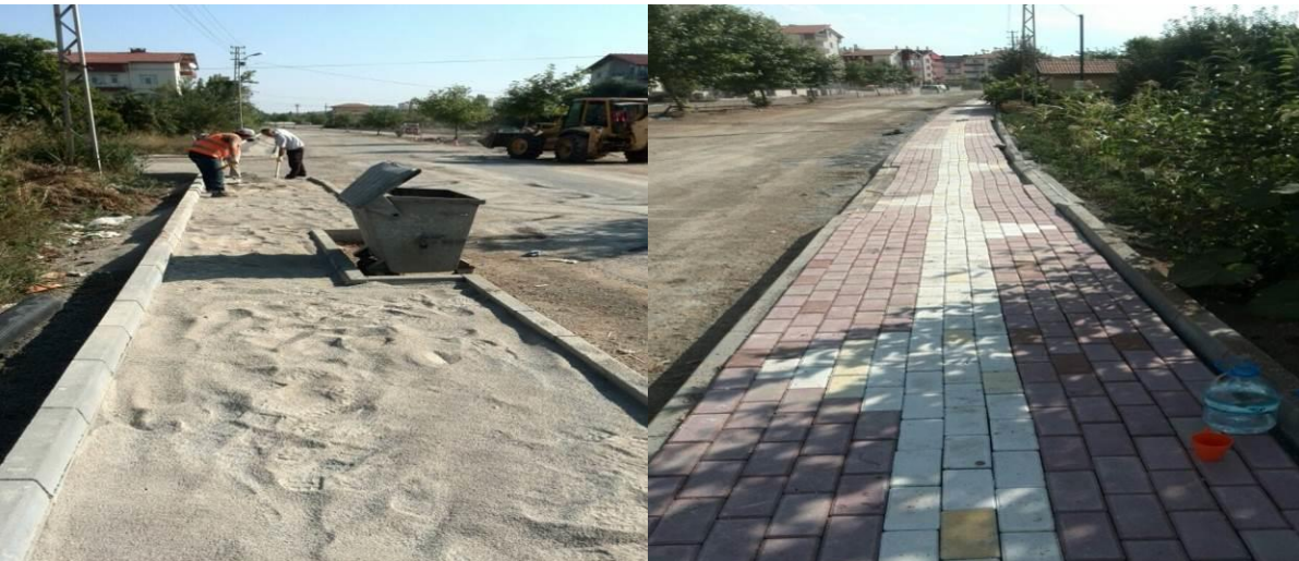
Müftü Mahallesi Parke ve Kaldırım alışmaları
