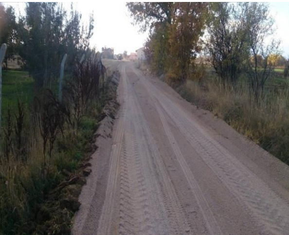
REGLAJ VE MALZEME SERİMİ YAPILAN YOLLAR Kuşluca MahallesiAvdancık Mahallesi
