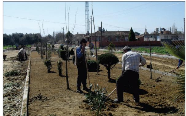
Türkmen Mahallesi Güllü Sokak park çalışması
