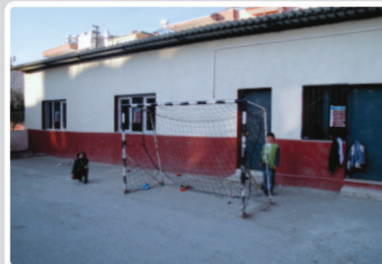
Özdemir Atasoy İ.Ö.O. Depo ve Kantin Yapımı
