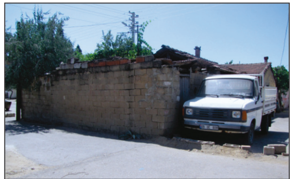
Türkmen Mah. 2.Bayındır Sok. Yol açma
