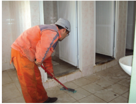
Umumi tuvalet çalışmaları
