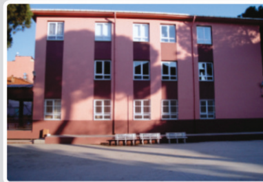
Atatürk İ.Ö.O. eski binası dış cephe boyaması
