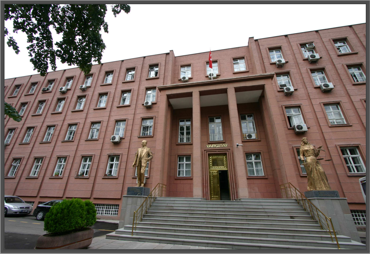
Yargıtay Binası–2010 (Ankara)
