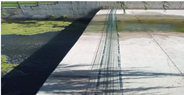
Avlu Çay Deresi Pislik Toplayıcı Montajı
