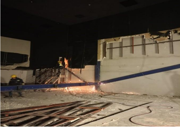
Yaylada Asma Tavan Sökümü ve Restoran Duvar Yıkımı
