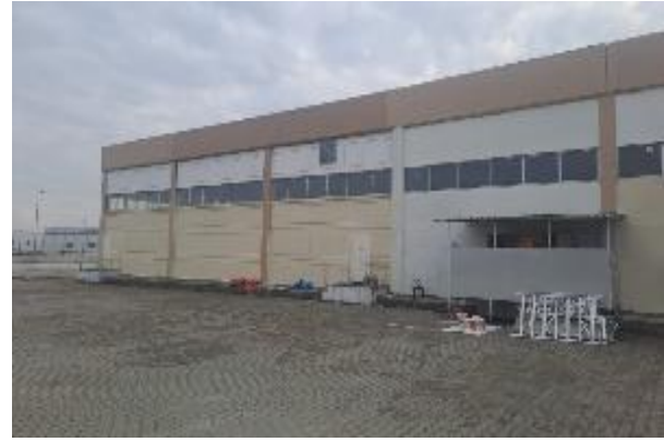
FİRINTAŞ FABRİKA DIŞ CEPHE YENİLENMESİ
