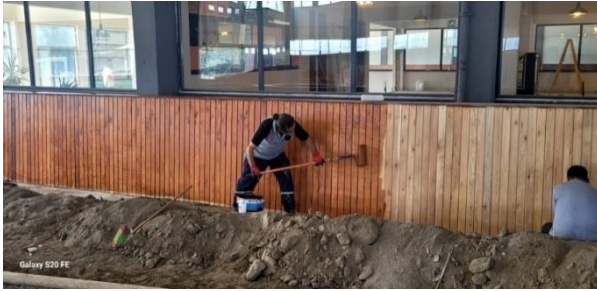
Bandırma Binicilik Eğitim, Spor ve Rehabilitasyon Merkezi Muhtelif İşler
