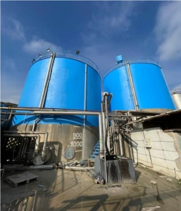
Karamanköy Asfalt Tesisleri Bunker Boya İşi
