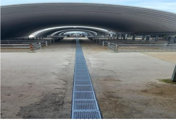
Hayvan Pazarı 700 Metre Mazgal Yapım İşi
