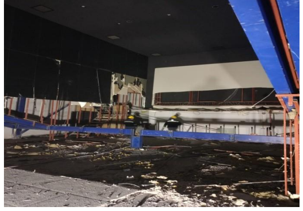
Yaylada Asma Tavan Sökümü ve Restoran Duvar Yıkımı
