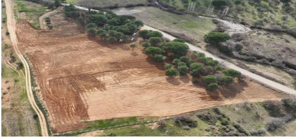
Tahtacı Mezarlığı Yapım İşi
