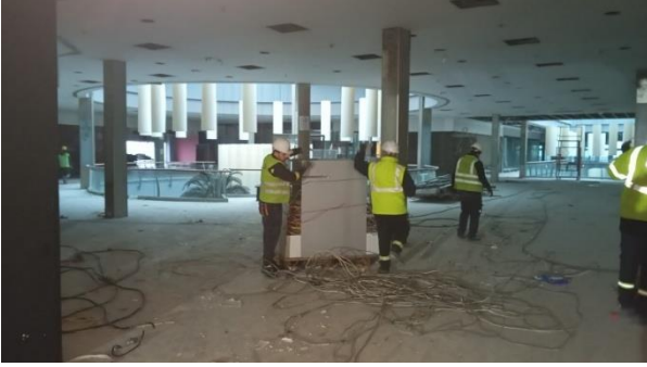
Yaylada Binası İç Tesizat ve Aydınlatma Demontajları
