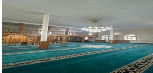
Dursunbey İlçesi Vakıf Camii İç Cephe Boya İşi
