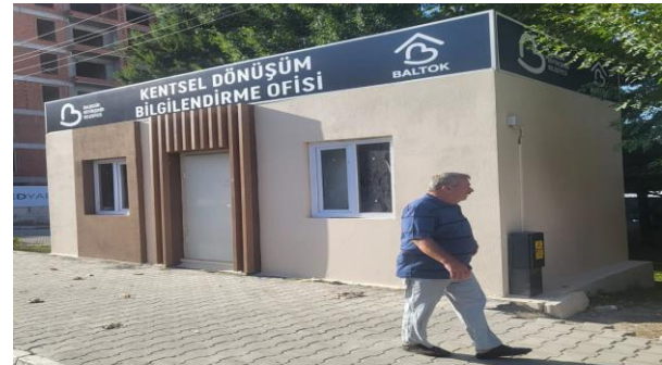
KENTSEL DÖNÜŞÜM OFİSİ KURULUMU VE UZLAŞMA GÖRÜŞMELERİ
