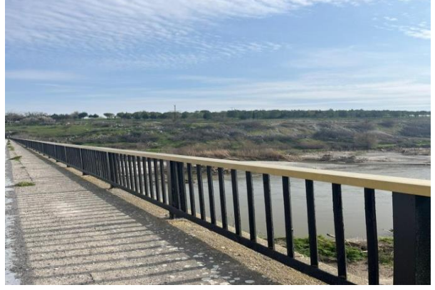
Kepsut İlçesi Hotaşlar Mahallesi Köprü Korkuluk Boya İşi
