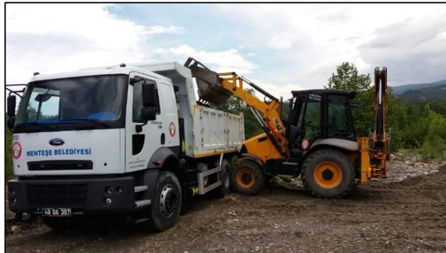
• İş Makinesi İle Yol Tesviye Çalışması Yapılmıştır.
