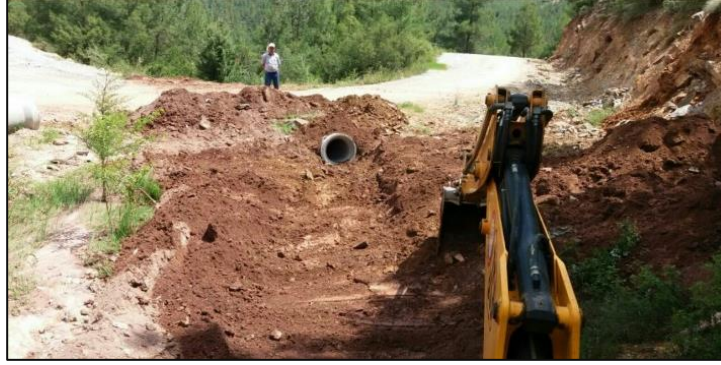
• Büz Yerleştirme Çalışmaları Yapılmıştır.
