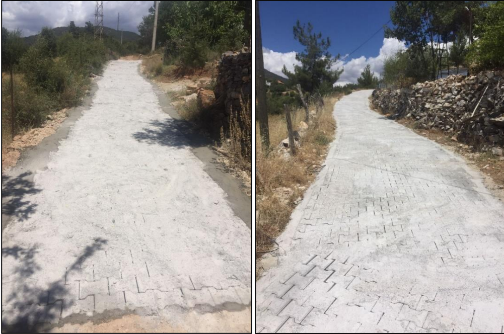
• Mahalle İçi Yolarda Kilit Beton Parke Kaplama Çalışmaları Yapılmıştır.
