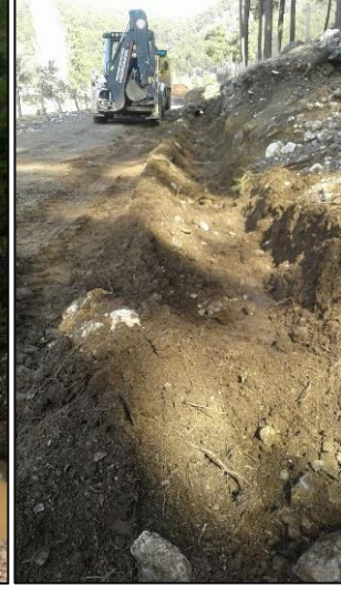
• Çavdar Sokakta İş Makinesi İle Yol Tesviye, Çakıllama ve Şarampollerin Açılması İşleri Yapılmıştır.
