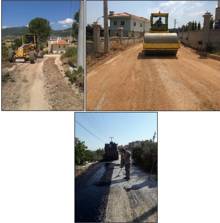
-Mahalle İçinde Bazı Muhtelif Yollarda Asfalt Sathi Kaplama Çalışmaları Yapıldı.
