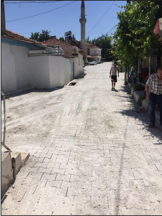
• Mahalle Meydanında Kilit Beton Parke İle Kaplama Çalışmaları Yapılmıştır.
