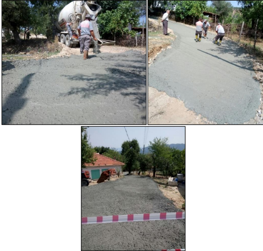
• Muhtelif Yollarda Beton Yol Üst Kaplama alıřmaları Yapılmıřtır.
