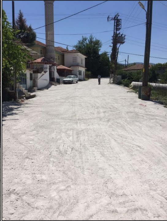
• Mahalle Meydanında Kilit Beton Parke İle Kaplama Çalışmaları Yapılmıştır.
