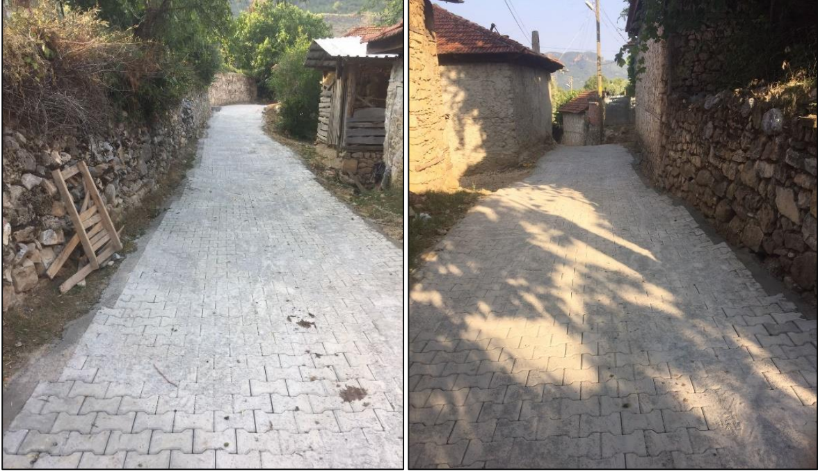
• Mahalle İi Yollarda Beton Kilit Parke Taşı İle, Yol Üst Kaplama alıřmaları Yapılmıřtır.
