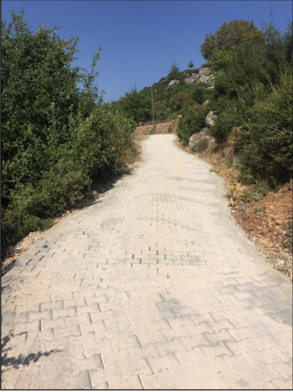
• Mahalle İi Yollarda Beton Kilit Parke Yol Üst Kaplama alıřmaları Yapılmıřtır.
