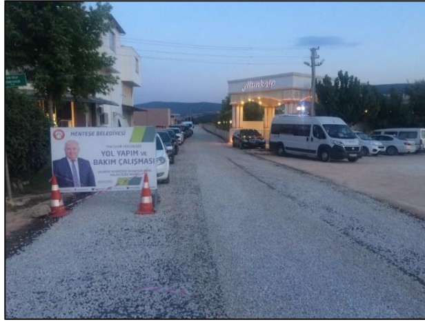
25.Sokak Avm Arkası, Asfalt Sathi Kaplama Çalışmaları Yapılmıştır.
