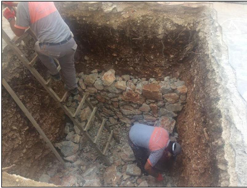
Muhtelif Yollarda İş Makinesi İle Yol Açım Çalışması Yapıldı
