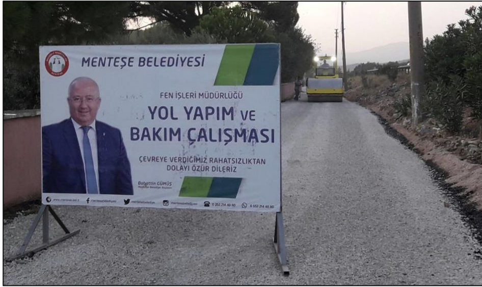
-Okul Önü Muhtelif Yollarda Sathi Kaplama Çalışması Yapıldı.
