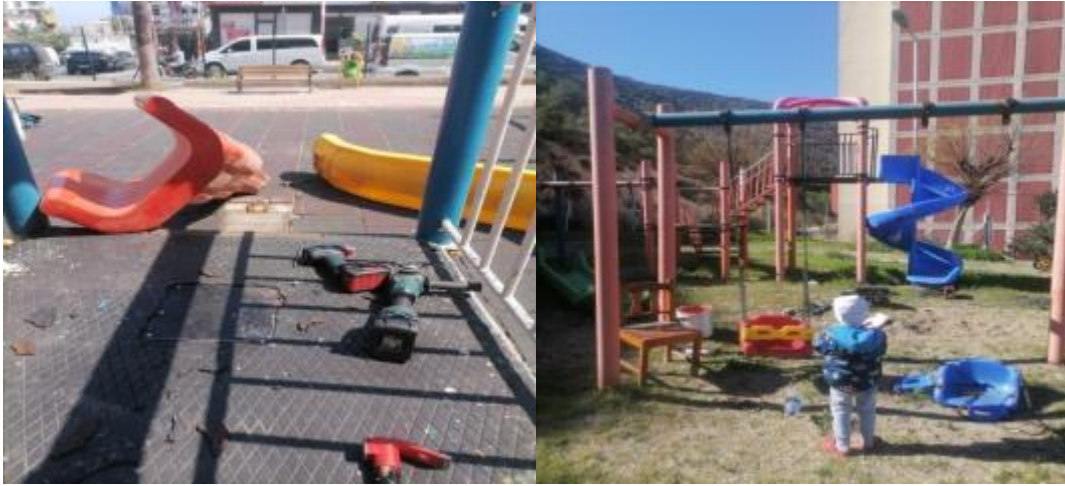
5.12.7. Esentepe Mahallesi Merkez Camii üstü parkta yenileme çalışması yapıldı.
