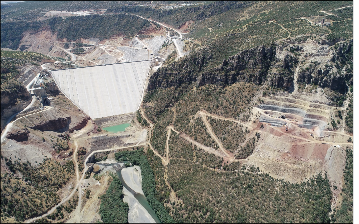
Diyarbakir Silvan Barajı (Memba)
