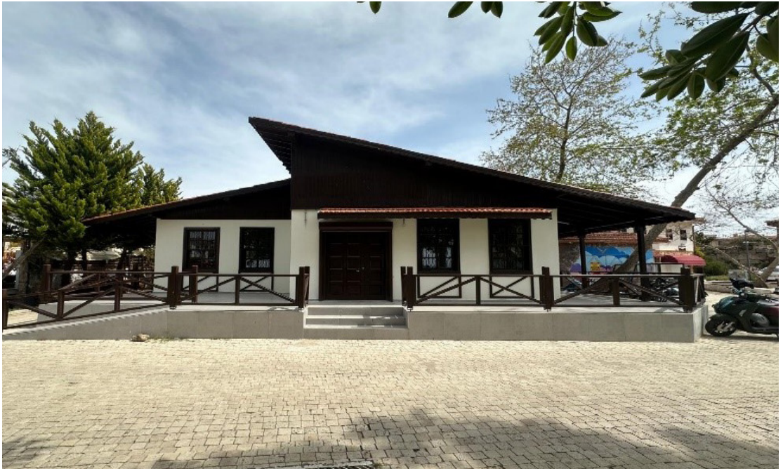
S.G. Side Kolluk Destek Tim Binası Tadilatı
