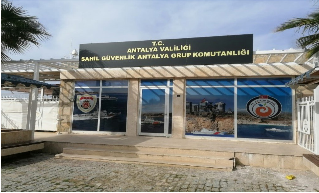
S.G. Kaleiçi Kolluk Destek Tim Binası Tadilatı
