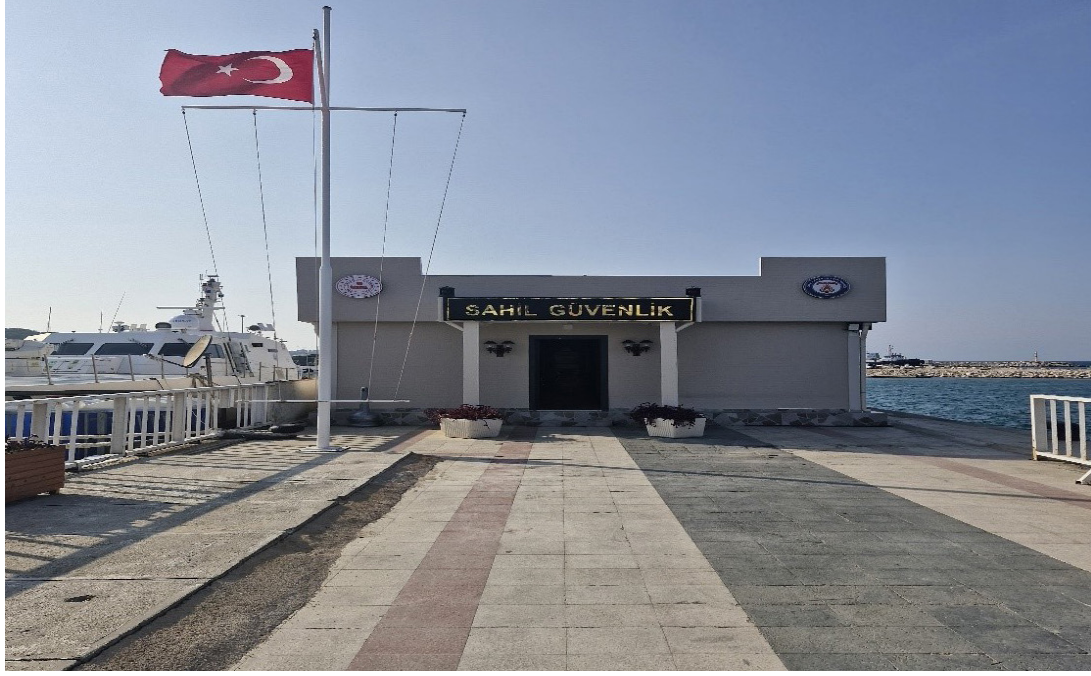
S.G. Çeşme Kolluk Destek Tim Binası İnşaatı
