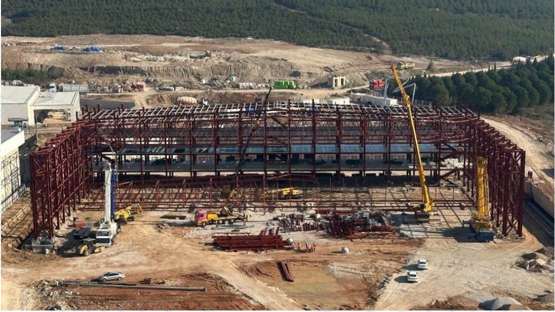
S.G. Hava Komutanlığı Uçak Hangarı İnşaatı
