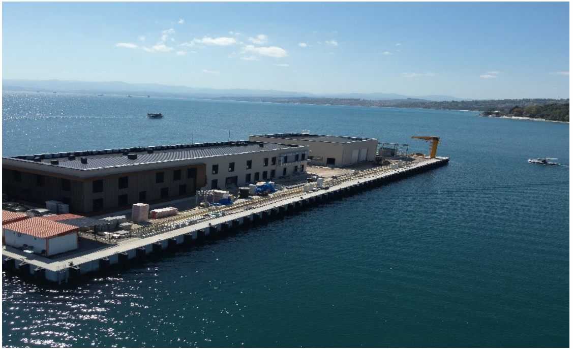
S.G. Sinop Rihtim ve Karakol Komutanlığı İnşaatı
