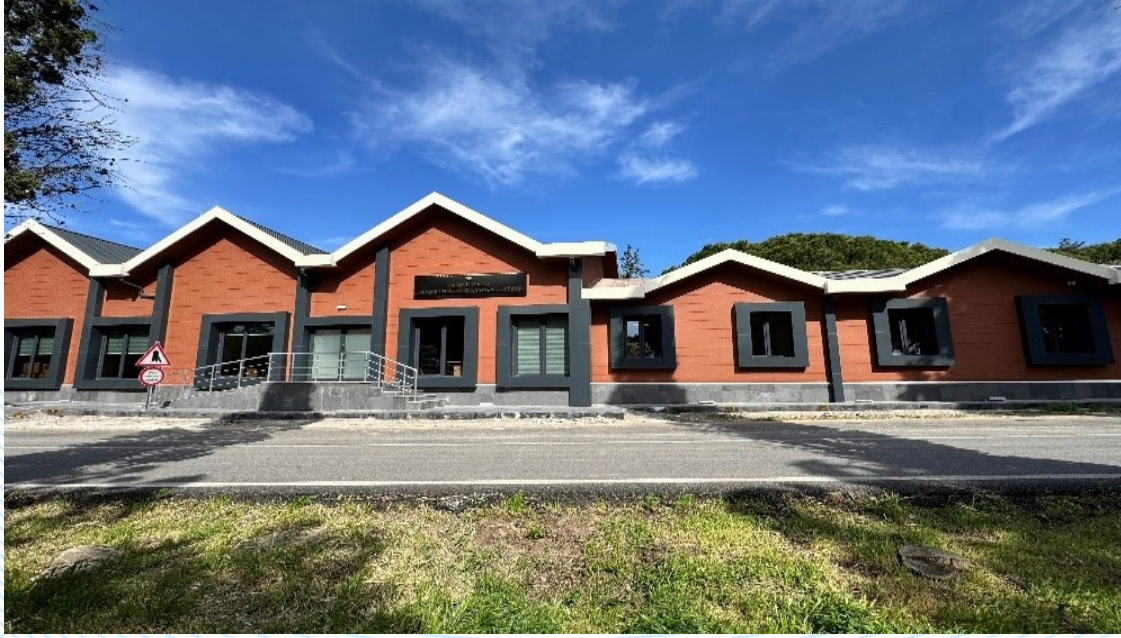
Nara S.G. Karakol Komutanlığı İnşaatı
