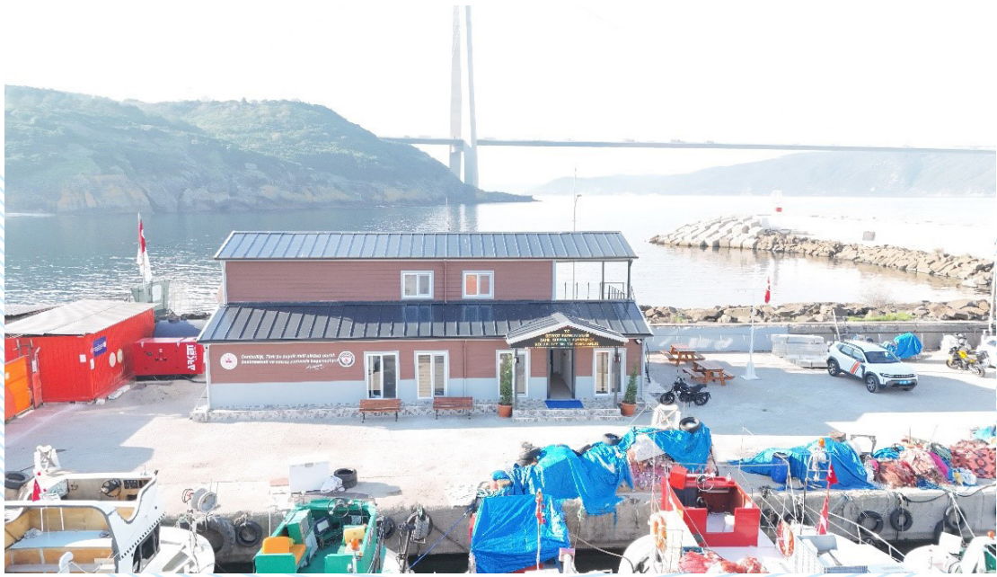
S.G. Poyrazköy Kolluk Destek Tesisi İnşaati
