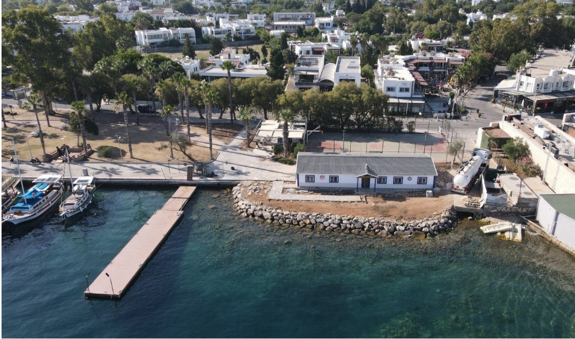
S.G. Yalıkavak Kolluk Destek Tim Binası İnşaatı
