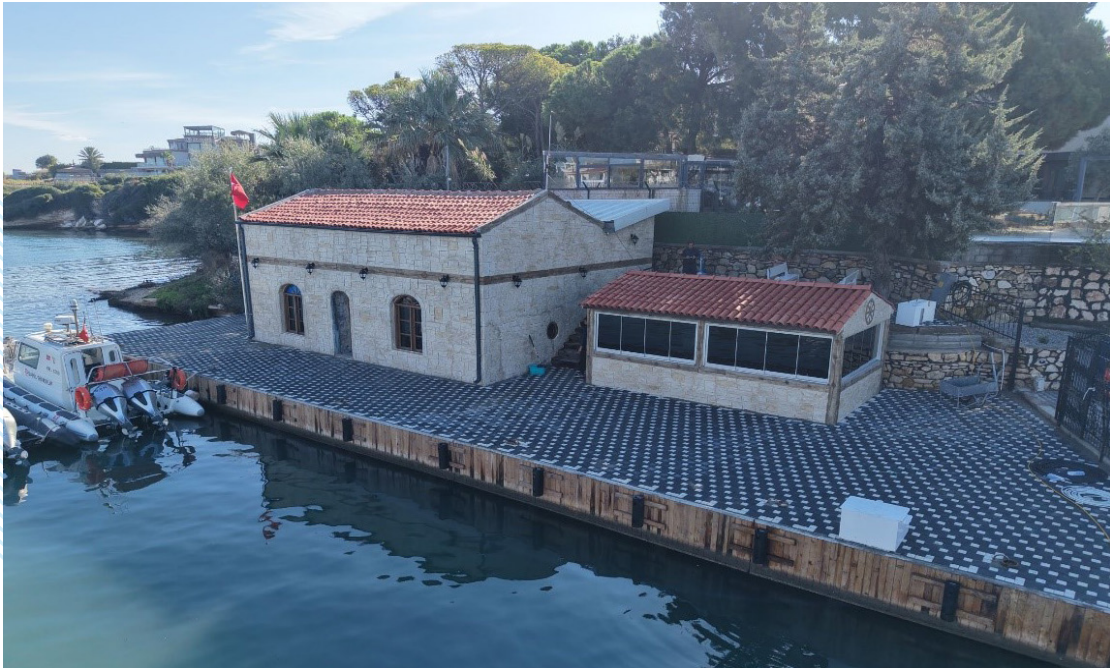
S.G. Dalyan Kolluk Destek Tim Rıhtım ve Bina Onarımı
