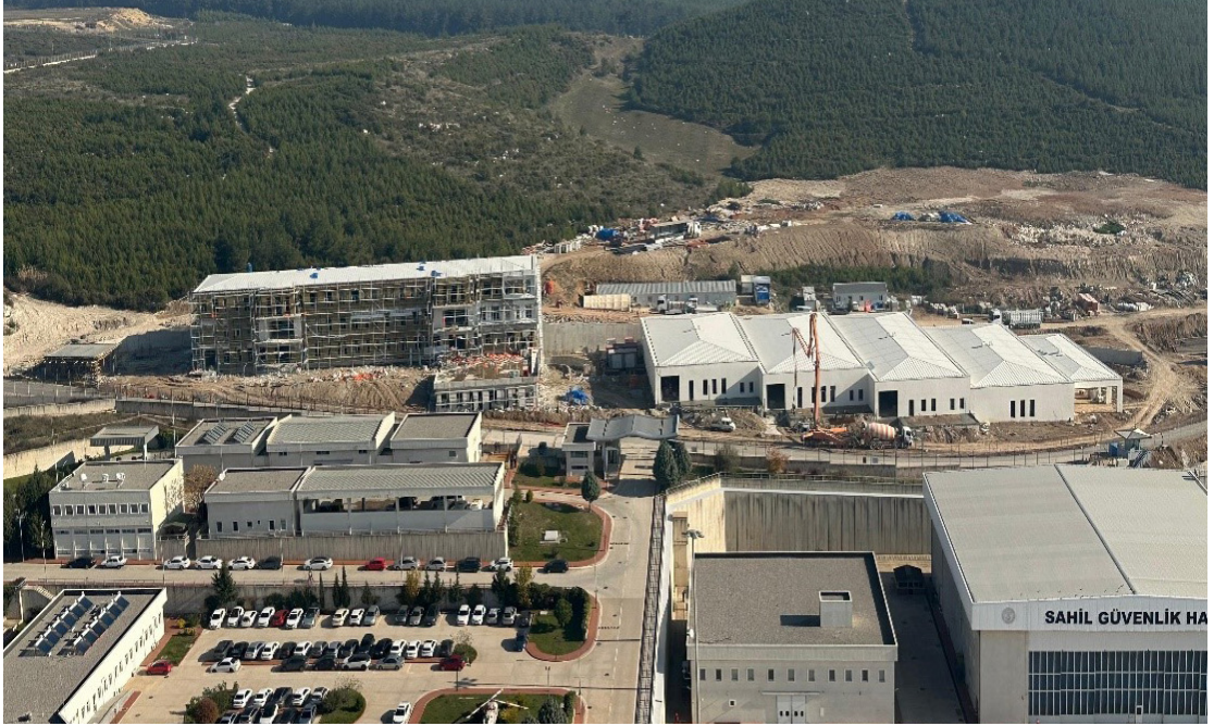
S.G. İkmal Destek Komutanlığı ve Envanter Kontrol Merkezi Komutanlığı İnşaatı
