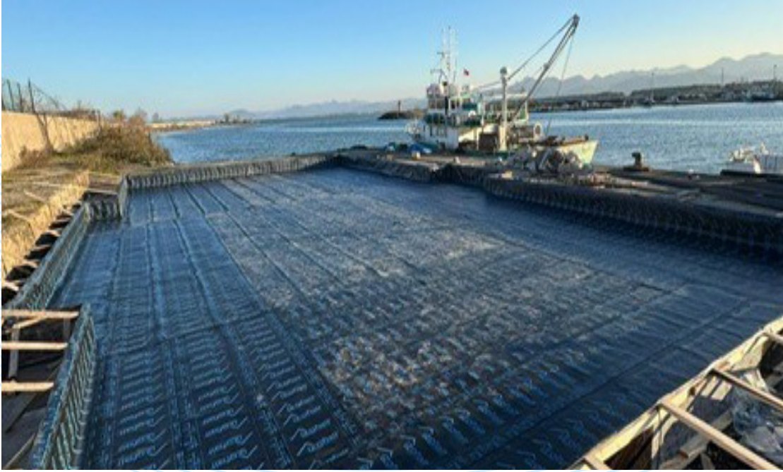
Terme S.G. Karakol Komutanlığı İnşaatı
