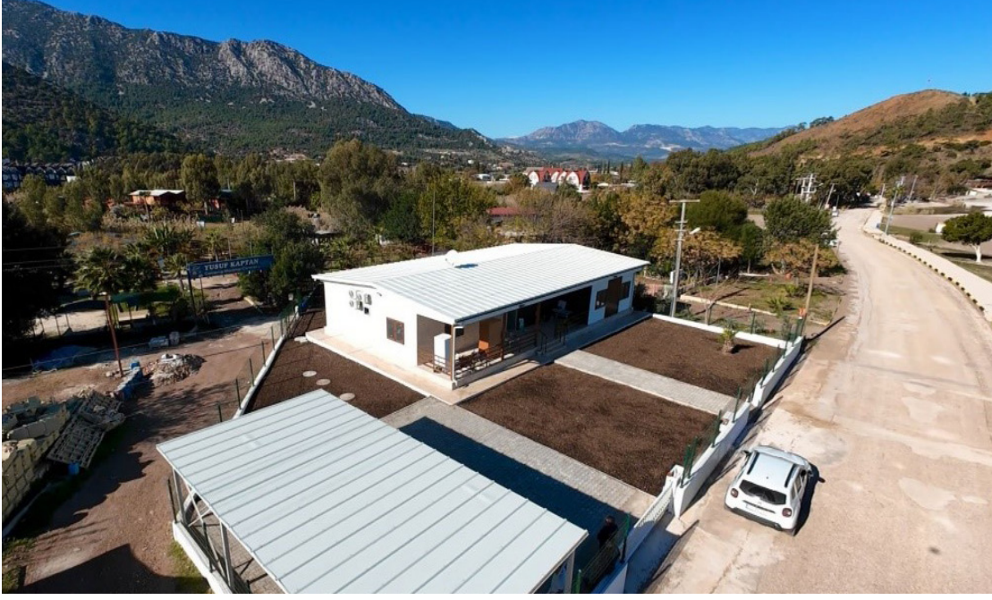
S.G. Adrasan Kolluk Destek Tim Binası İnşaatı
