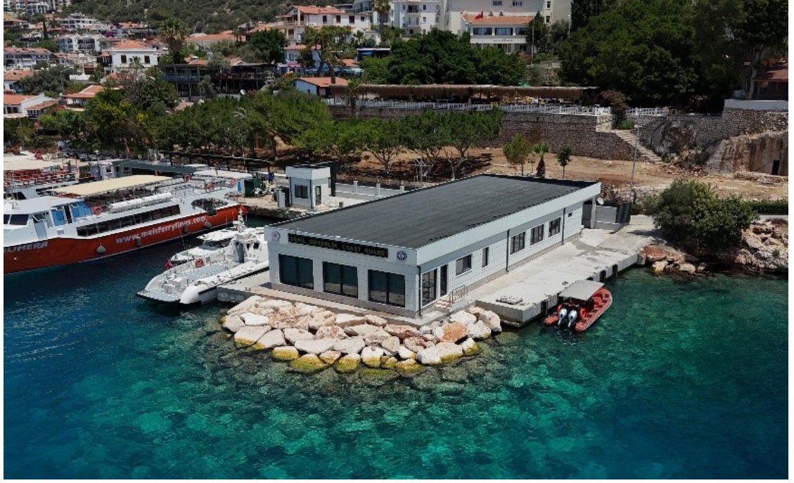
S.G. Kaş Kolluk Destek Tim Binası İnşaatı
