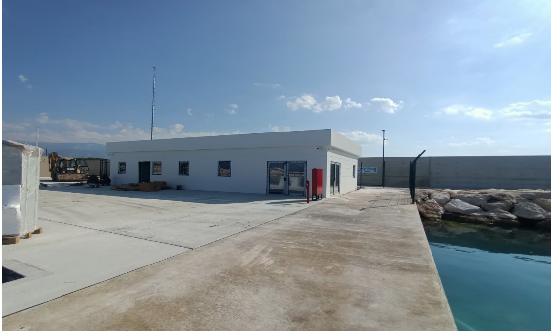
S.G. Demre Kolluk Destek Tim Binası İnşaatı
