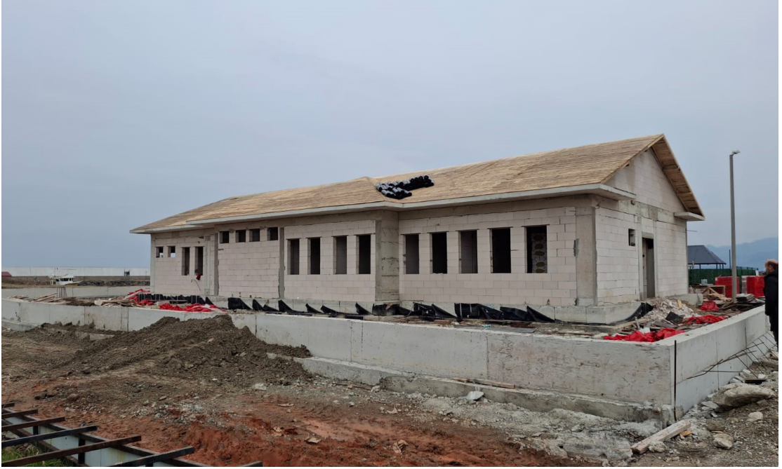
Tirebolu S.G. Karakol Komutanlığı İnşaatı
