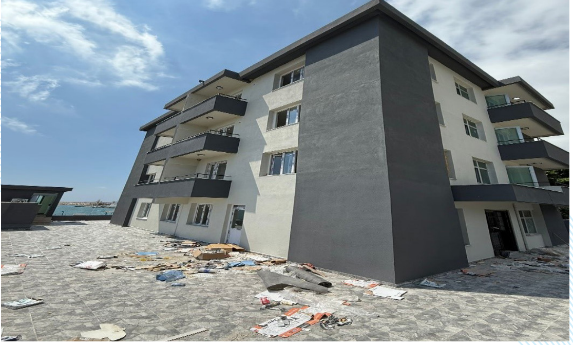
Çevlik Lojman Güçlendirme İşi
