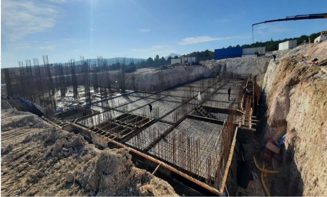
S.G. Foça SÖH Komutanlığı İnşaatı
