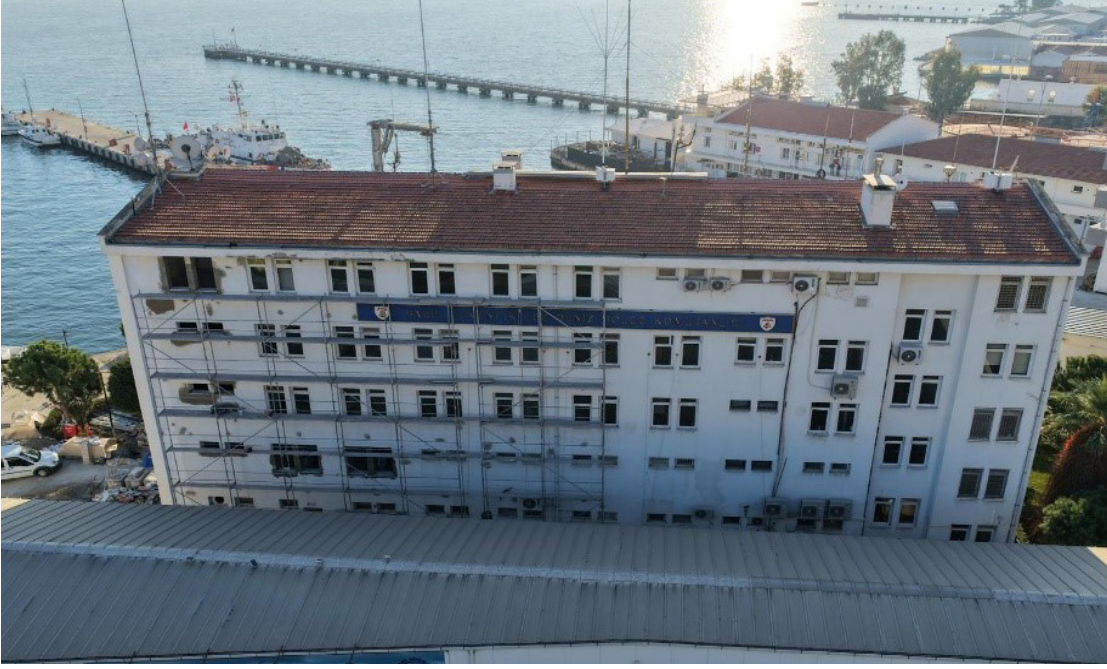
S.G. Ege Deniz Bölge Komutanlığı Güçlendirme işi
