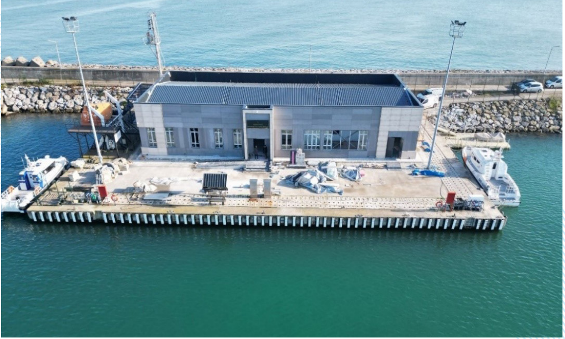
Sakarya (Karasu) S.G. Karakol Komutanlığı İnşaatı
