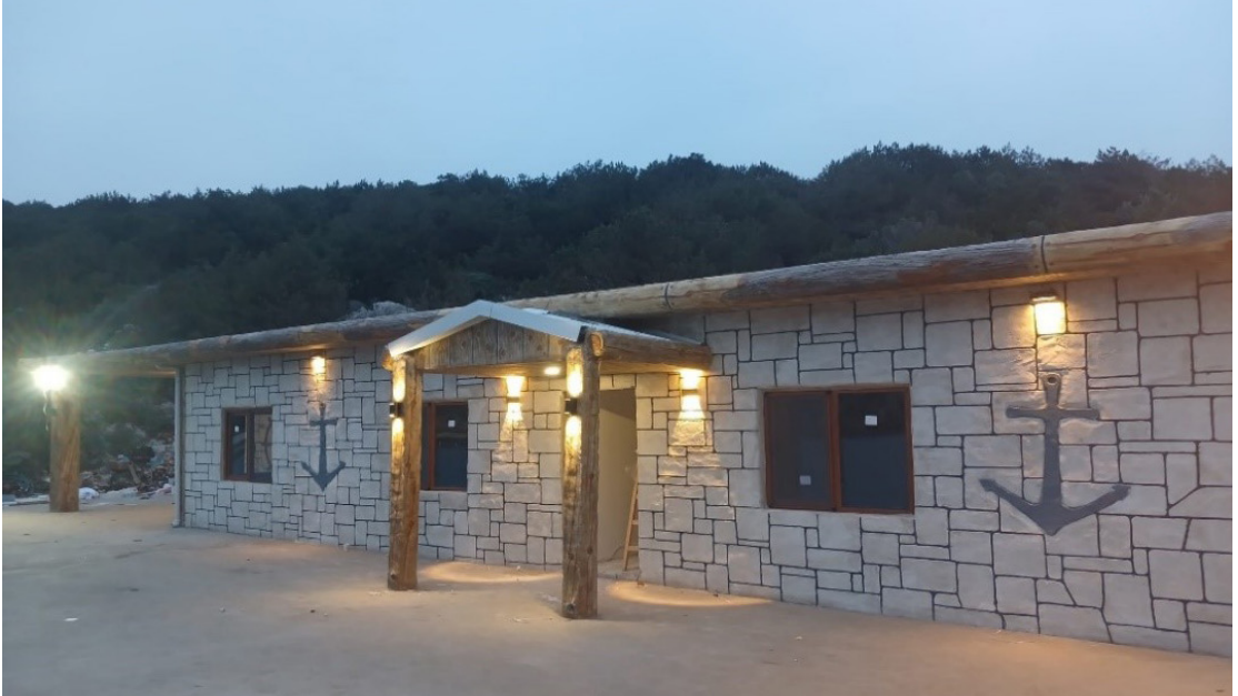
S.G. Urla (Zeytinler/Kokar) Kolluk Destek Tim Binası ve Yüzer İskele İnşaatı
