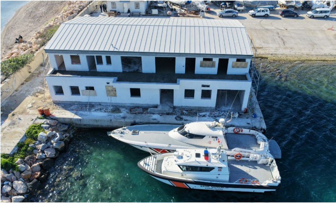
Mordoğan (Karaburun) S.G. Karakol Komutanlığı İnşaatı
