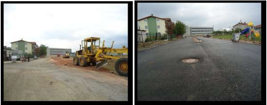
Köseköy Taşkın Sokak Asfalt Yol Yapım Çalışması
