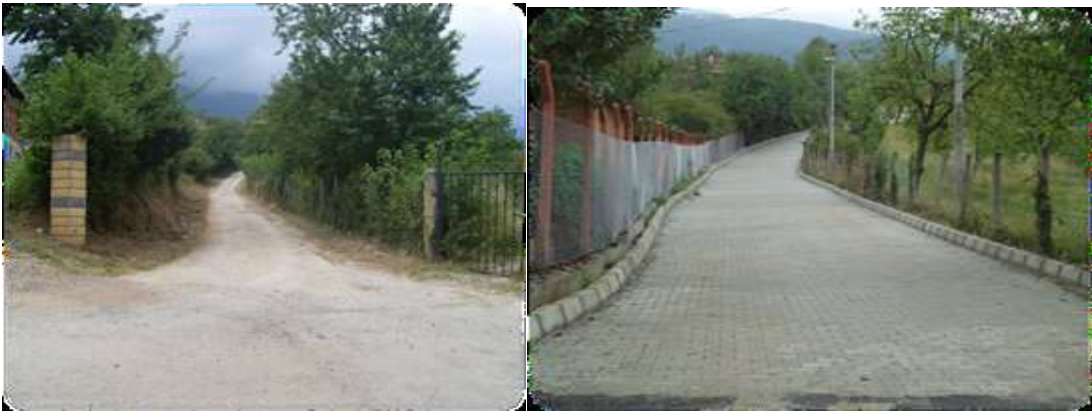
Derbent Hikmetiye Mahallesi Beste Sokakta 480 m. Bordür 1680 m2 parke Döşendi
