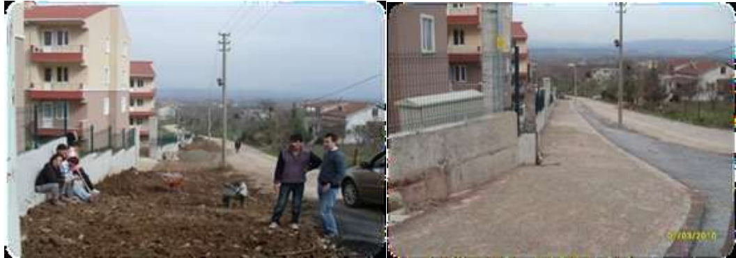
Suadiye Orta mahalle Harmanlık sokakta parke ve bordür çalışmaları
