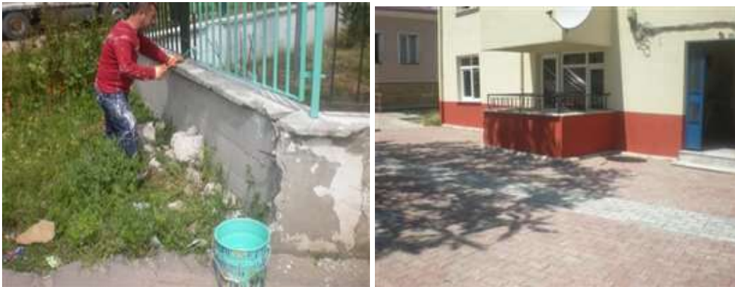
Sağlık ocaklarının çevre düzenleme ve demir korkulukların boyanması yapılmıştır.
