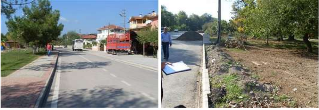
Eşme sahil kaldırım kıyı düzenleme çalışmalarının yapılması.
