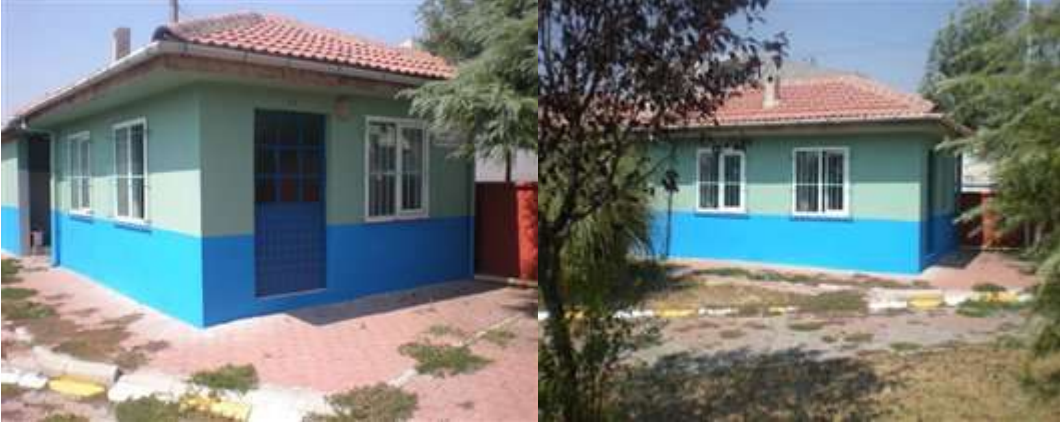
Dumlupınar mahallesi muhtarlık binası küçük onarımlı tadilatları yapılmıştır.
