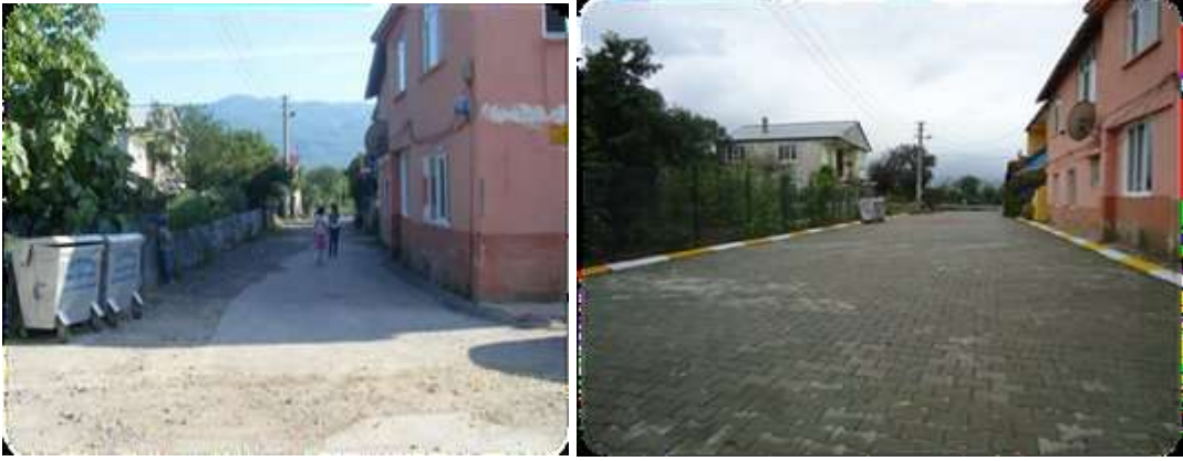
Uzuntarla İbrikdere Mahallesi 34. Sokakta 320 m. Bordür 1120 m2 Parke Döşendi
