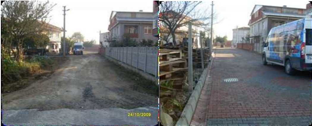
Uzunçiftlik Ece Sokak 120 m. Bordür 420 m2 parke Döşendi
