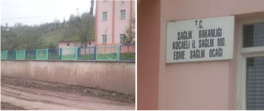
Eşme sağlık ocağı çevre düzenlemesi ve küçük ölçekli onarımları yapılmıştır.
