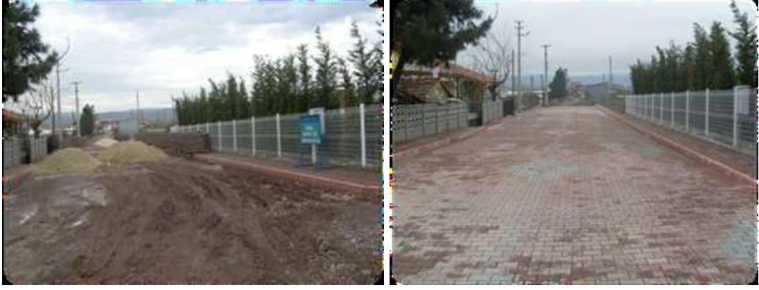
Uzunçiftlik Emekevler Mahallesi Çelebi Sokakta 120 m.Bordür 480 m2 Parke Döşendi
