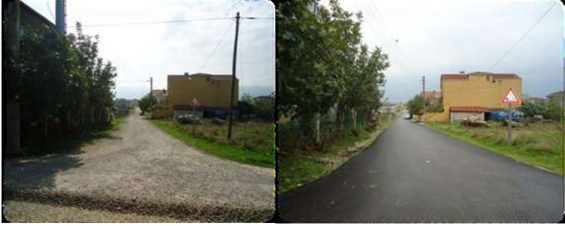
Köseköy Koza Sokak Asfalt Yol Yapım Çalışması
