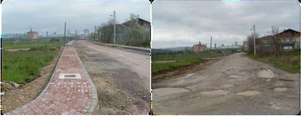
Uzunciftlik Hürriyet mahallesi Oguz sokak da 650 mt.bordür 1625 m2 parke döşeme çalışmaları
