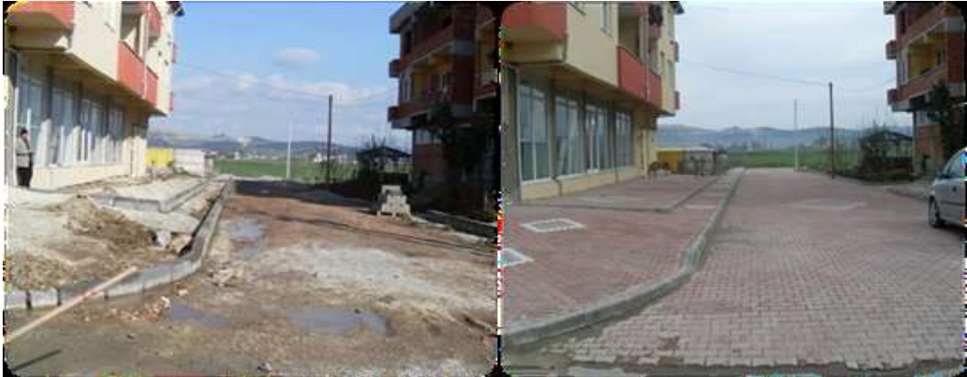
Köseköy Ulus Mahallesi Yalı Sokakta 165 m. Bordür 480 m2 parke Döşendi
