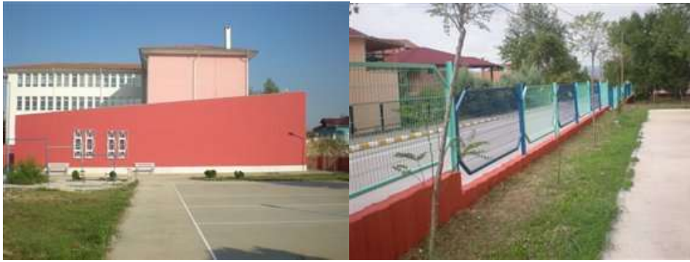
Drdane zdilek ilğretim okulu korkuluk boya ve evre dzenlemeleri yapılmıřtır.
