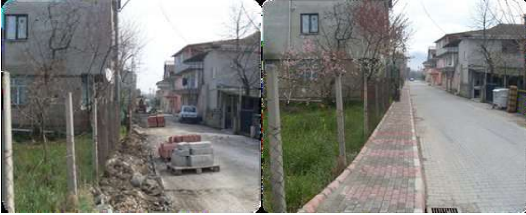
Köseköy Hacıhalim Mahallesi Sezen Sokakta 320 m. Bordür 520 m2 Parke Döşendi
