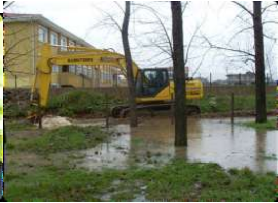
Köseköy Hacı Mustafa Mahallesinde Kanallar Temizliklenerek Su Baskınlarının Önüne Geçildi.
