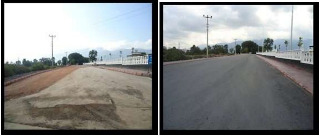
Sarımeşe İnönü Caddesi Asfalt Yol Yapım Çalışması
