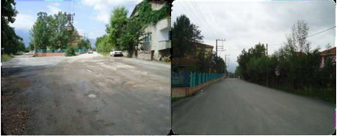
Uzuntarla İzmit Caddesi Asfalt Yol Yapım Çalışması
