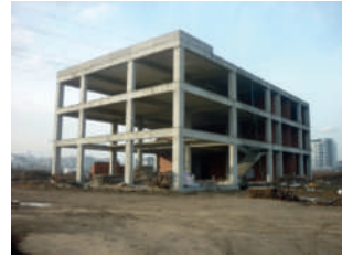
Ertuğrul Mahallesi Aile Sağlığı Merkezi
