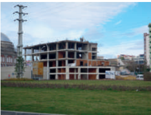
Yüzüncüyıl Hizmet Binası
