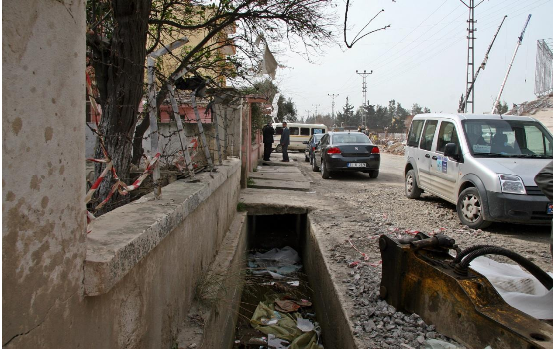
Numune Mahallesi Dr. Sadık Ahmet Caddesi yağmur suyu kanalı eski hali
