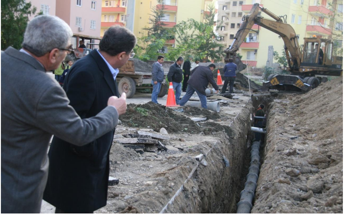
Mustafa Kemal Mahallesi altyapı çalışmaları
