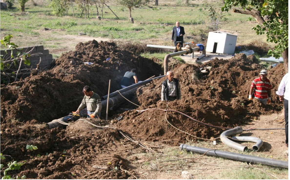
Numune su kuyuları ve terfi hattı boru montajı
