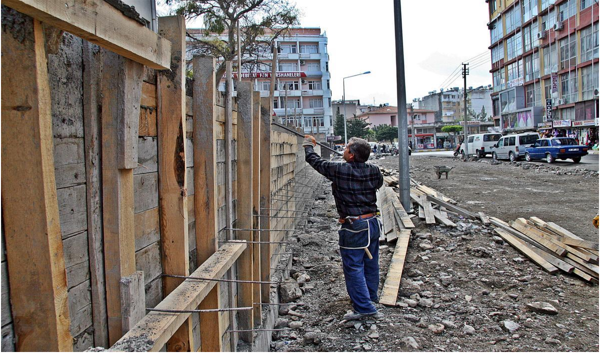
İskenderun Lisesi ihata duvarı yapımı
