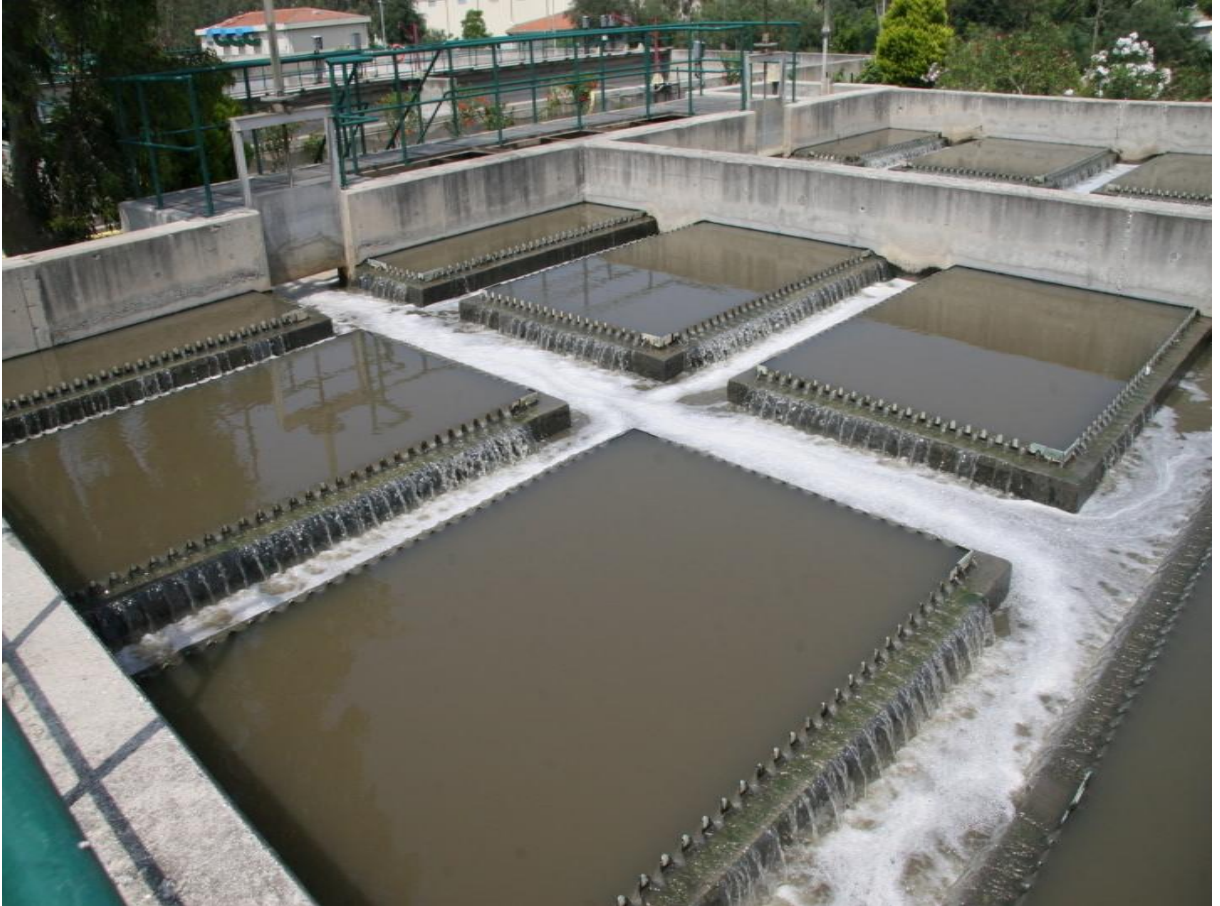
Atıksu arıtma tesisi
