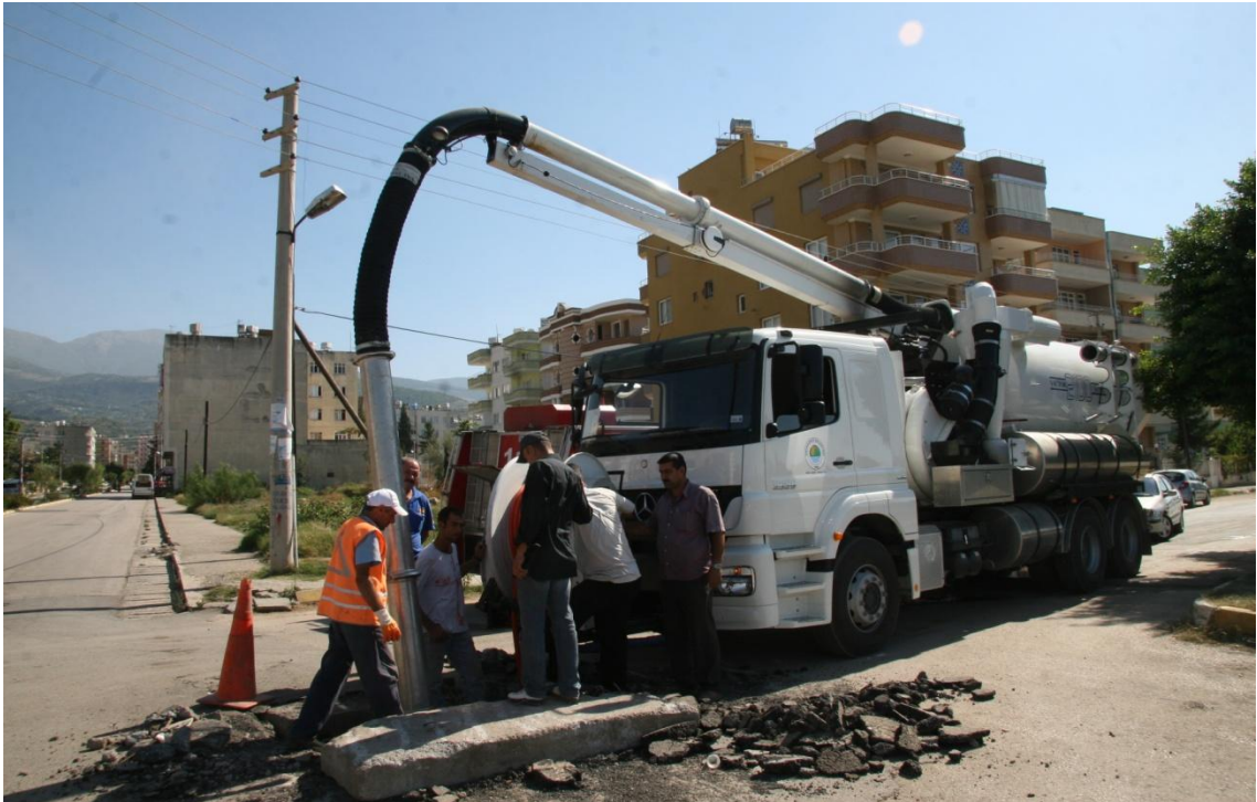
Kılavuz aracımızla yapılan hat ve baca temizliği
