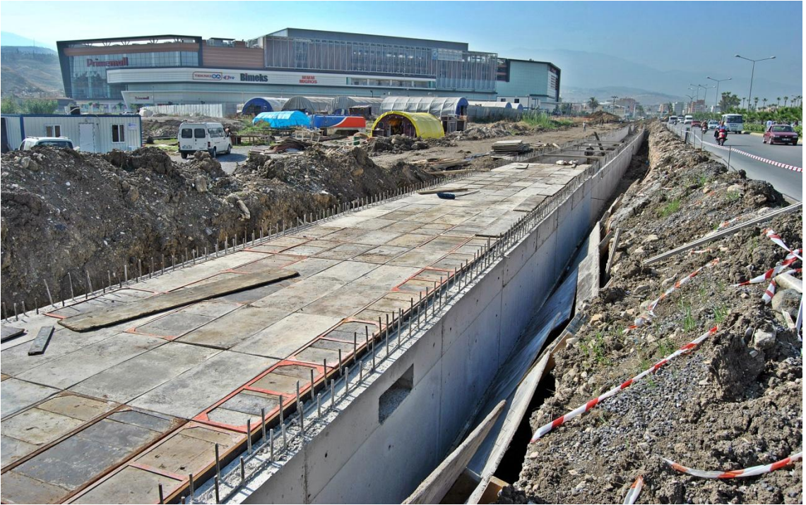
E91 Karayolu yağmur suyu menfez çalışmaları
