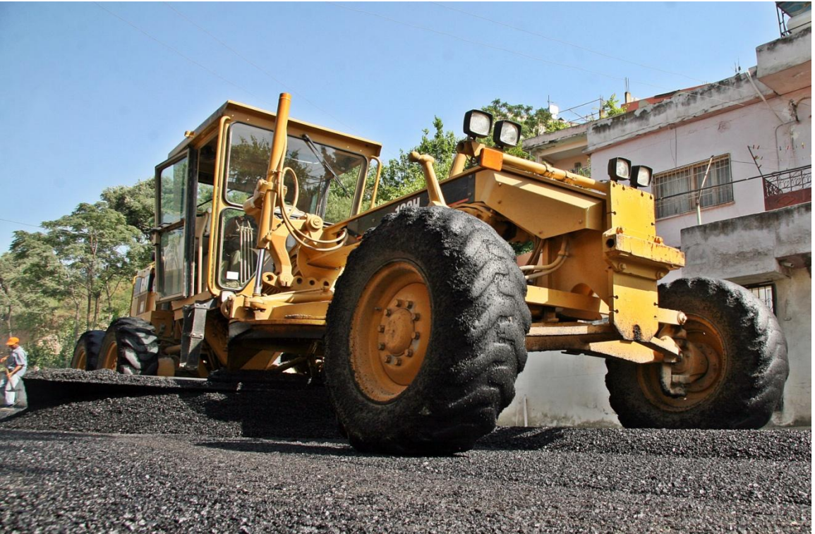
Tepe mahallelerinde yapılan asfaltlama çalışmaları
