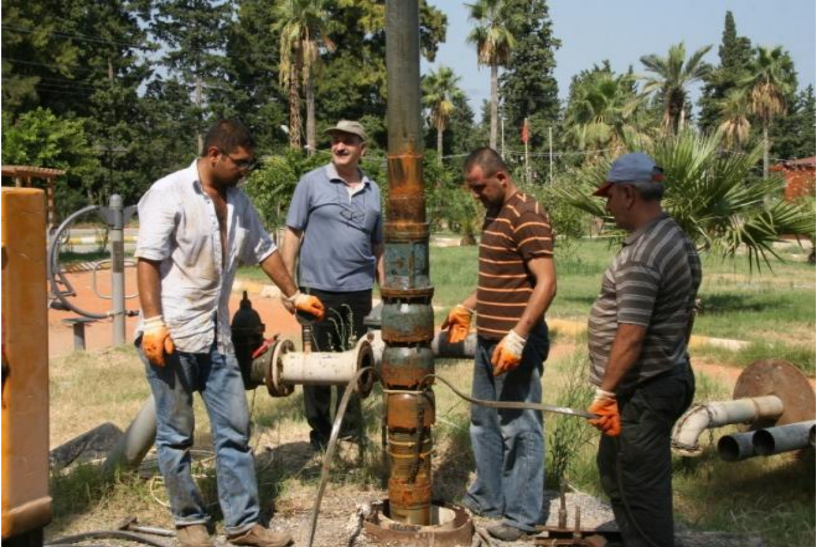
Akbağlar su kuyusu pompa montajı
