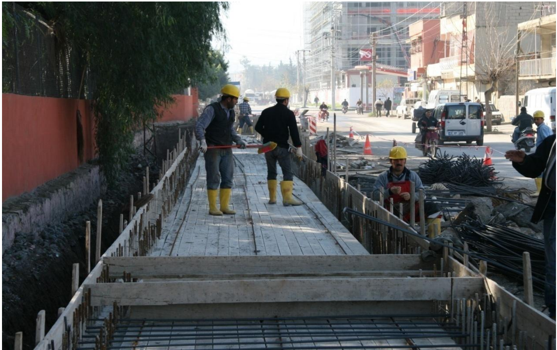
Numune Mahallesi Dr. Sadık Ahmet Caddesi yağmur suyu menfez inşaatı
