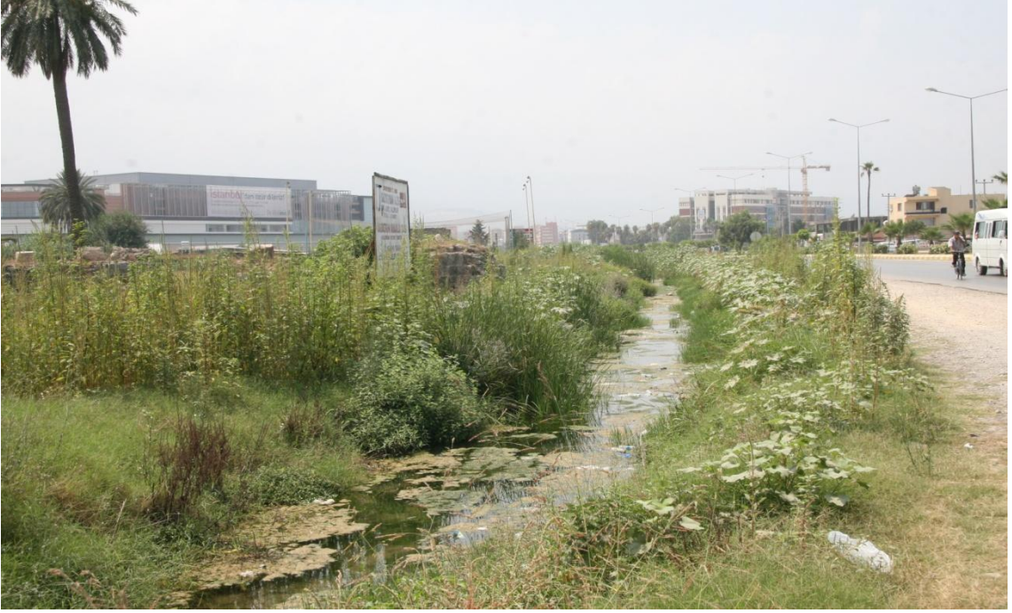
E91 Karayolu yağmur suyu kanalı yapım öncesi
