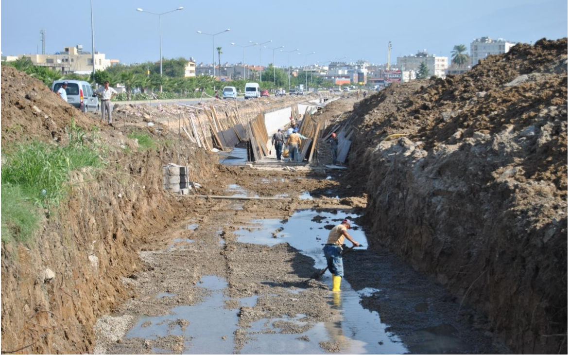
Arsuz yolu (AVM önü) kavşağı yağmur suyu menfez hattı çalışmaları
