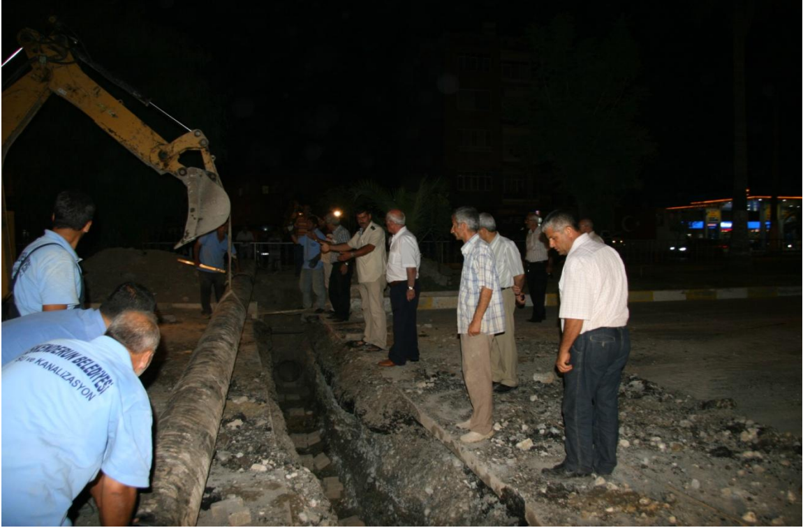
E91 yolu, yağmur suyu drenaj çalışması (gece)
