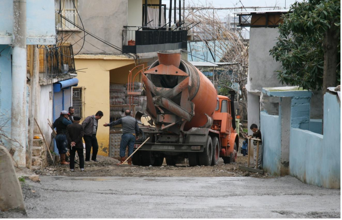
Tepe mahallelerinde yapılan beton yol çalışmaları
