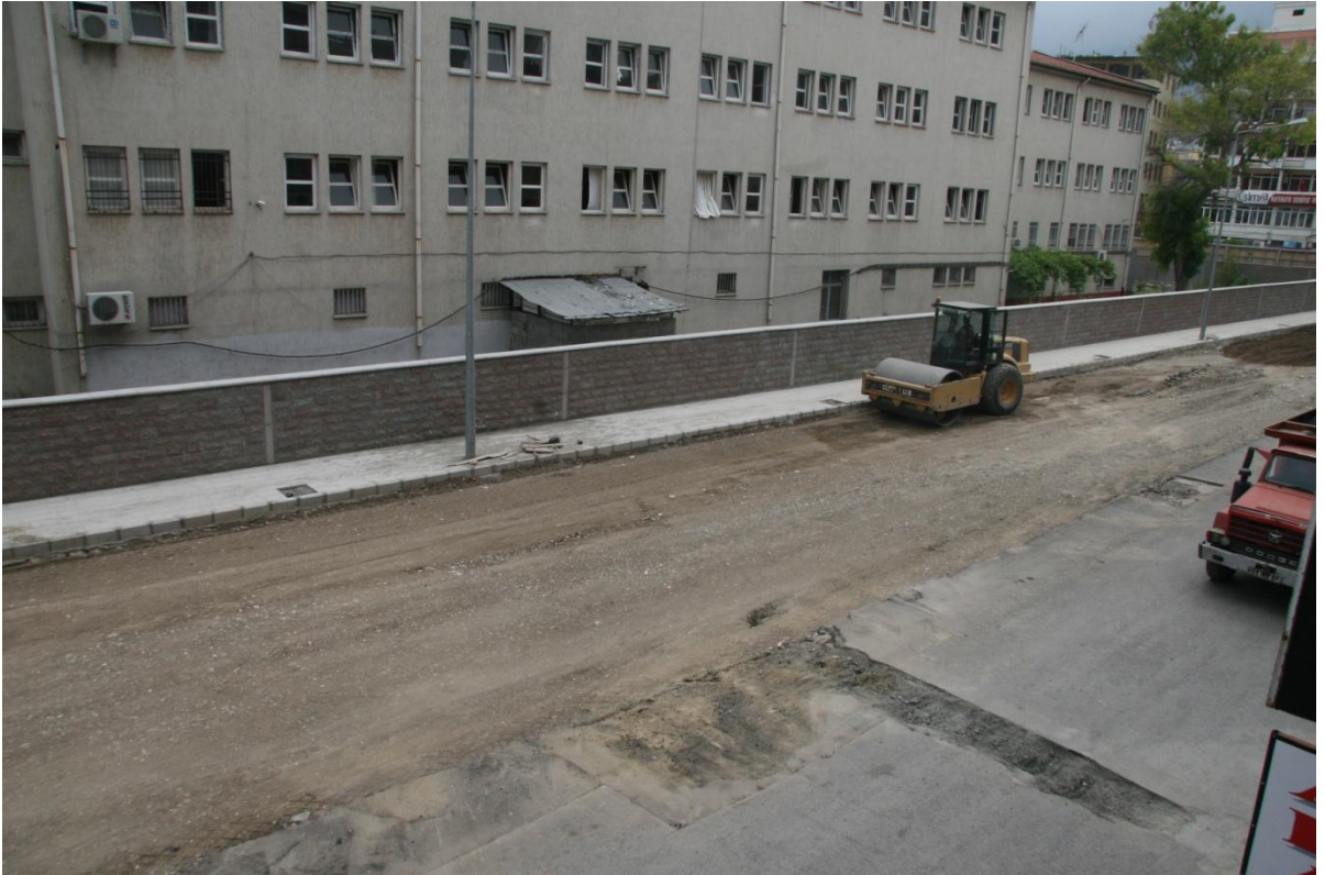
İskenderun Lisesi arkası asfalt çalışmaları
