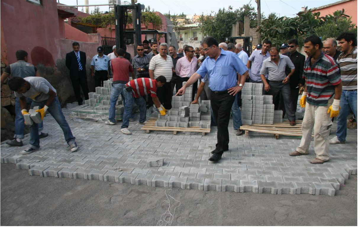
• Tepe Mahalleleri Parke yol çalışmaları
