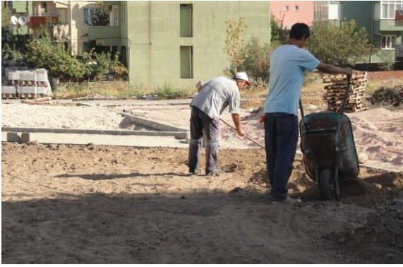
Şekil 12. ve 13. Akay sokak park alanı toprak serimi ile kent mobilyaları montaj çalışmaları
