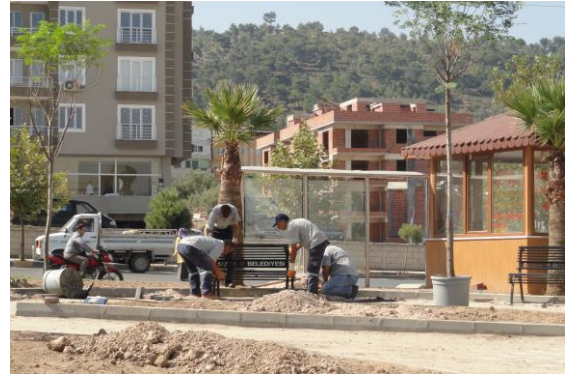
Şekil 12. ve 13. Akay sokak park alanı toprak serimi ile kent mobilyaları montaj çalışmaları
