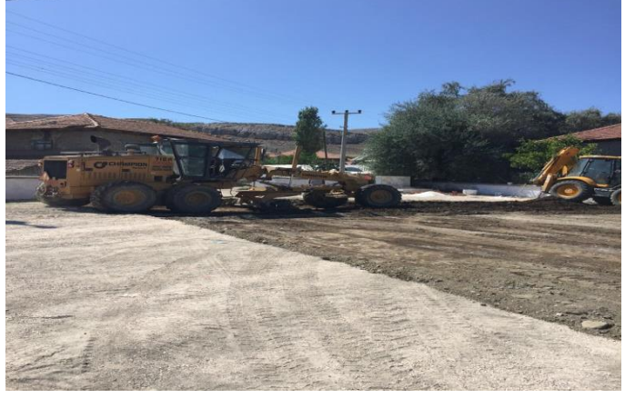
Yeşiloba Düğün Salonu Alt Zemin Tesviyesi:
