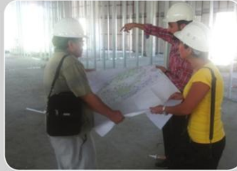
Bina iskan kontrol işlemleri
