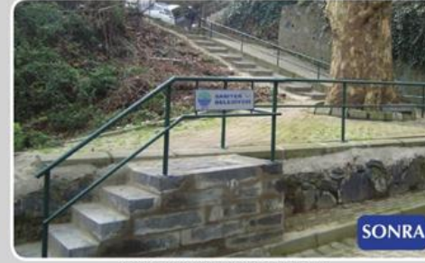
Kireçburnu Su Yolu Bekir Sokak Duvarı ve Merdiven Korkuluk Çalışması
