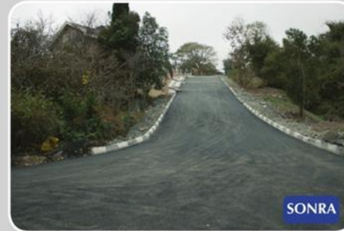
Zekeriyaköy, Ala Serçe Sokak - Asfalt Çalışması
