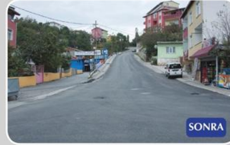
FSM, Bilgi Sokak - Asfalt Çalışması
