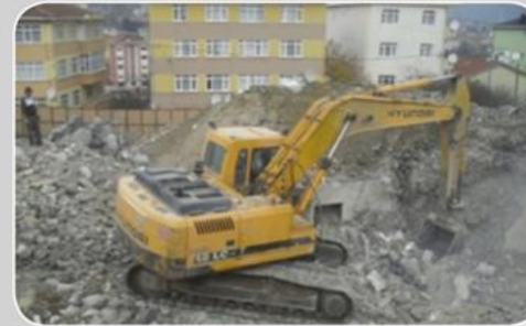
Riskli binanın tespiti ve yıkım işlemi
