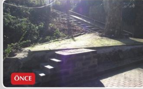
Kireçburnu Su Yolu Bekir Sokak Duvarı ve Merdiven Korkuluk Çalışması
