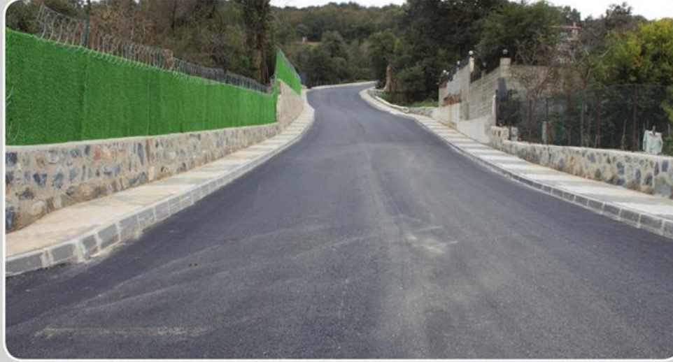
Zekeriyaköy, Ayazma Sokak Mevki - İmarlı Yol Çalışması
