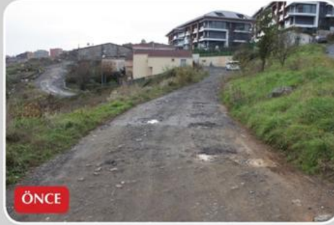
Poligon, Sağlam Sokak - Asfalt Çalışması
