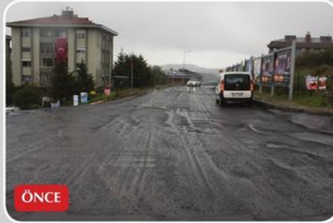
Zekeriyaköy, Tatar Sokak - Asfalt Çalışması
