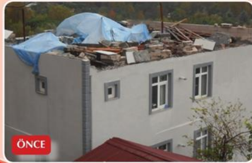
İzin Verilen Çatı Tamir Çalışmaları
