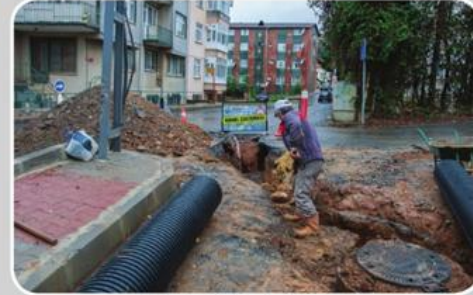
Maden, Selvi Sokak - Kanal Çalışması
