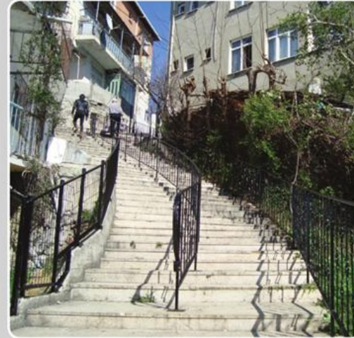
Reşitpaşa Ahmet Celalettin Sokak Korkuluk Çalışması
