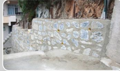
Büyükdere Ocak Çıkma - Duvar Çalışması
