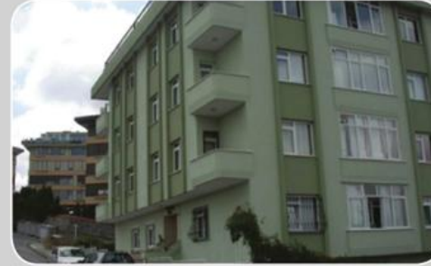
Riskli binanın tespiti
