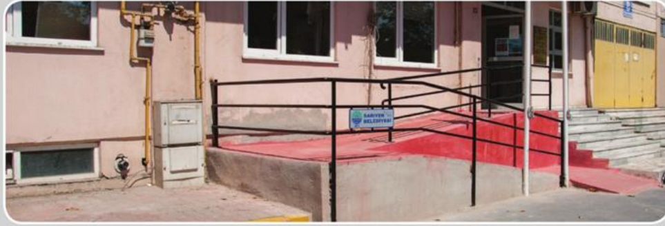
Çayırbaşı Ek Hizmet Binası - Engelli Erişim Çalışması
