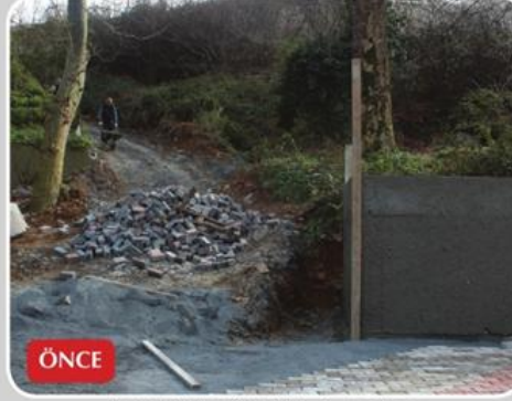
Kocataş Mahallesi, Zerrin Sokak - Çeşme Çalışması
