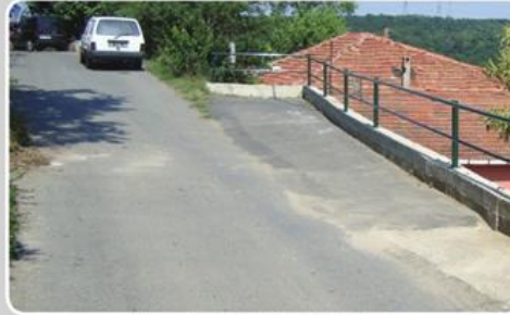
Kocataş Nergis Sokak Korkuluk Çalışması
