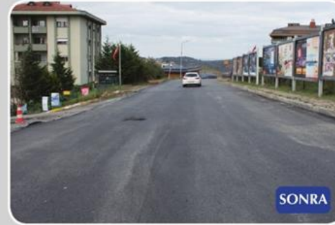
Zekeriyaköy, Tatar Sokak - Asfalt Çalışması
