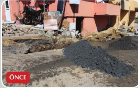
Kilyos, Pruva Sokak - Kanal Çalışması
