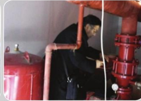
Bina iskan kontrol işlemleri
