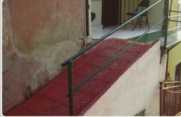
İstinye Mehmet Şükrü Sokak Engelli Rampa ve Korkuluk Çalışması
