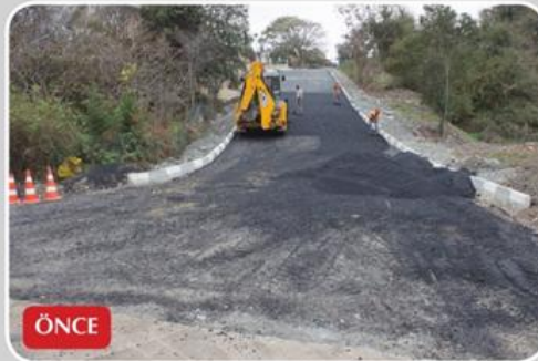
Zekeriyaköy, Ala Serçe Sokak - Asfalt Çalışması
