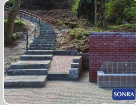
Kocataş Mahallesi, Zerrin Sokak - Çeşme Çalışması
