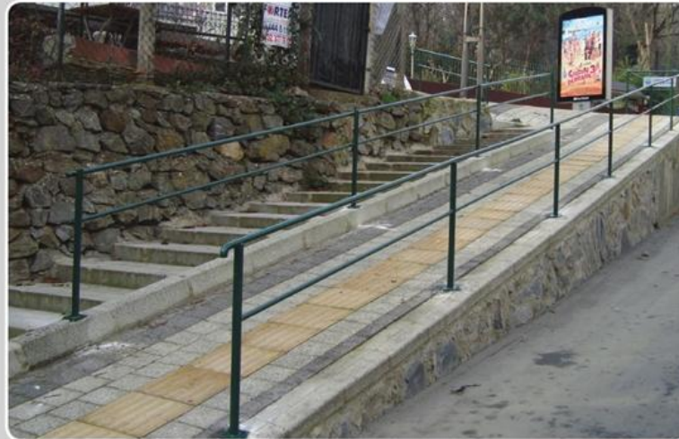
Emirgan Mektebi Sokak Engelli Yolu ve Korkuluk Çalışması
