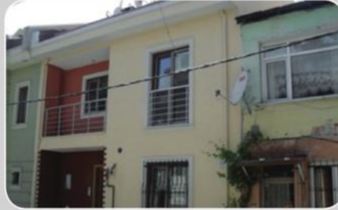
Riskli binanın tespiti
