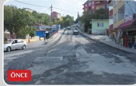
FSM, Bilgi Sokak - Asfalt Çalışması
