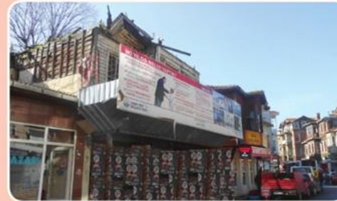
Belediyemizce Tedbir Alınan Metruk Yapılar
