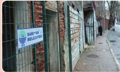
Belediyemizce Tedbir Alınan Metruk Yapılar
