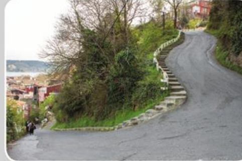
Sarıdağ Yemin Sokak - Yol Geniştirme Çalışması
