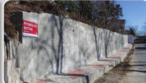
Tarabya, Aydınevler Bostan Sokak - Duvar Çalışması
