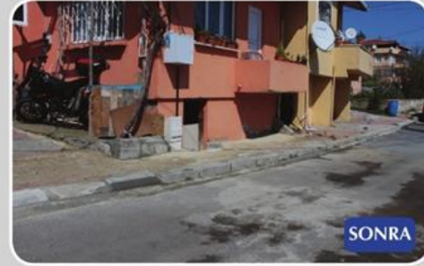
Kilyos, Pruva Sokak - Kanal Çalışması
