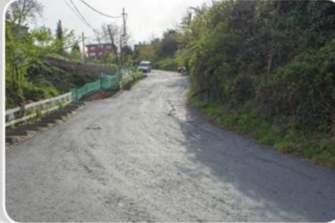
Sarıdağ Yemin Sokak - Yol Geniştirme Çalışması
