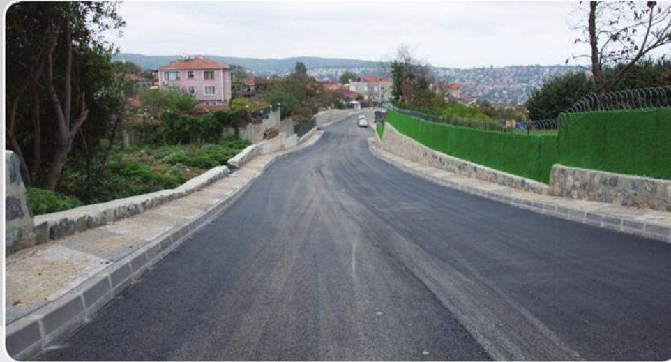
Zekeriyaköy, Ayazma Sokak Mevki - İmarlı Yol Çalışması
