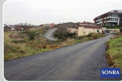
Poligon, Sağlam Sokak - Asfalt Çalışması
