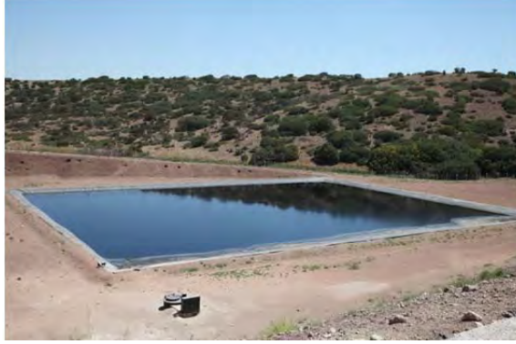
Sızıntı Suyu Havuzu
