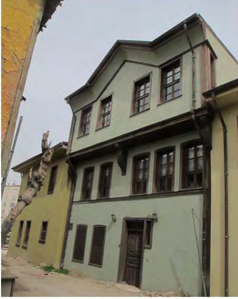
148 Ada B Blok Ön Cephe
