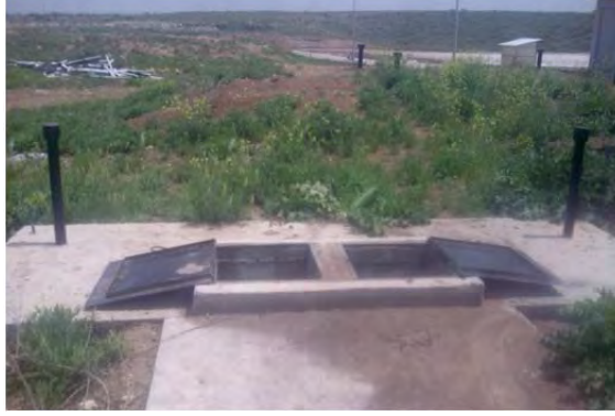
Atık Pil Geçici Depolama Ünitesi
