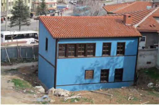
Ahşap Rekonstrüksiyon Bina
