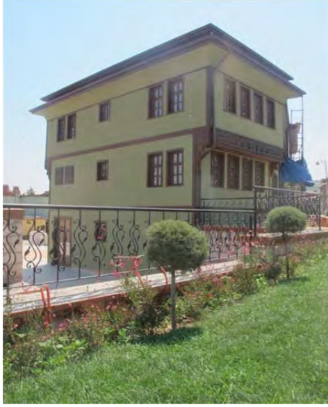
147 Ada,14 Parsel Yan Cephe
