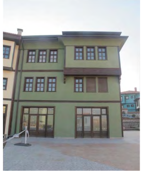
147 Ada,14 Parsel Arka Cephe
