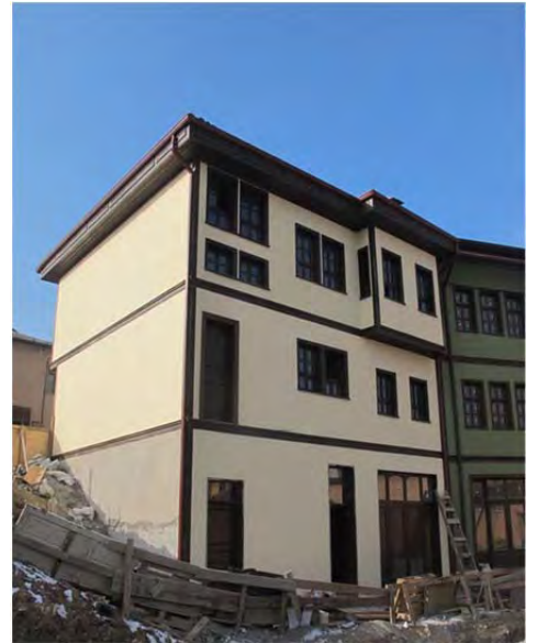
147 Ada, 13 Parsel Arka Cephe
