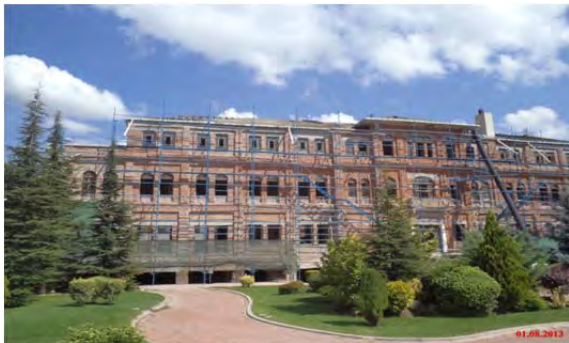
Belediye Eski Binası & Otel Restorasyonu
