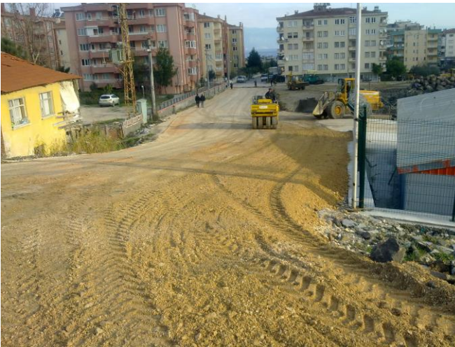
➤ Güzelyalı 22. Sokağın asfaltlanması
