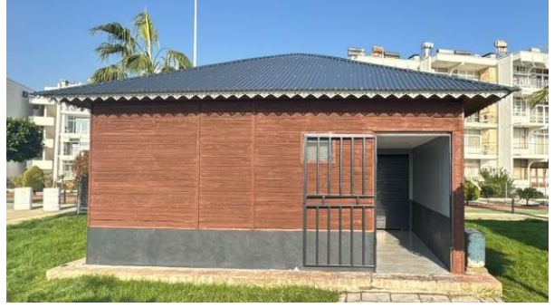
ERDEMLİ 33 YAZISI KUZEYİ WC ÇATI
