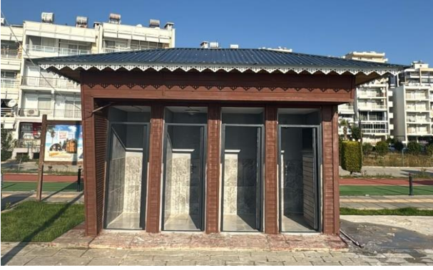
ERDEMLİ 33 YAZISI KUZEYİ DUŞ-KABİN ÇATI
