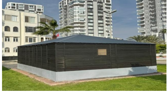
ALATAPARK SİTESİ ÖNÜ WC ÇATI
