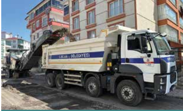
Trimer Yol Kazısı ve Asfalt Çalışması
