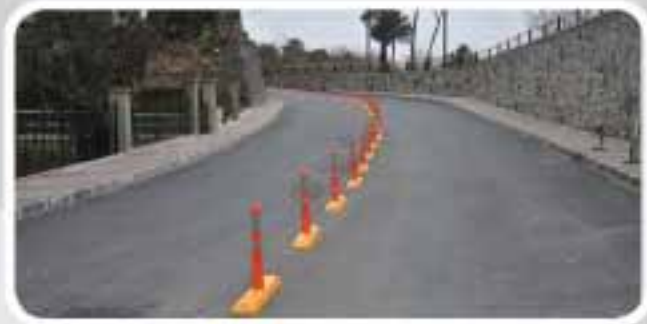
Kilyos Yol Ayırma Çalışması
