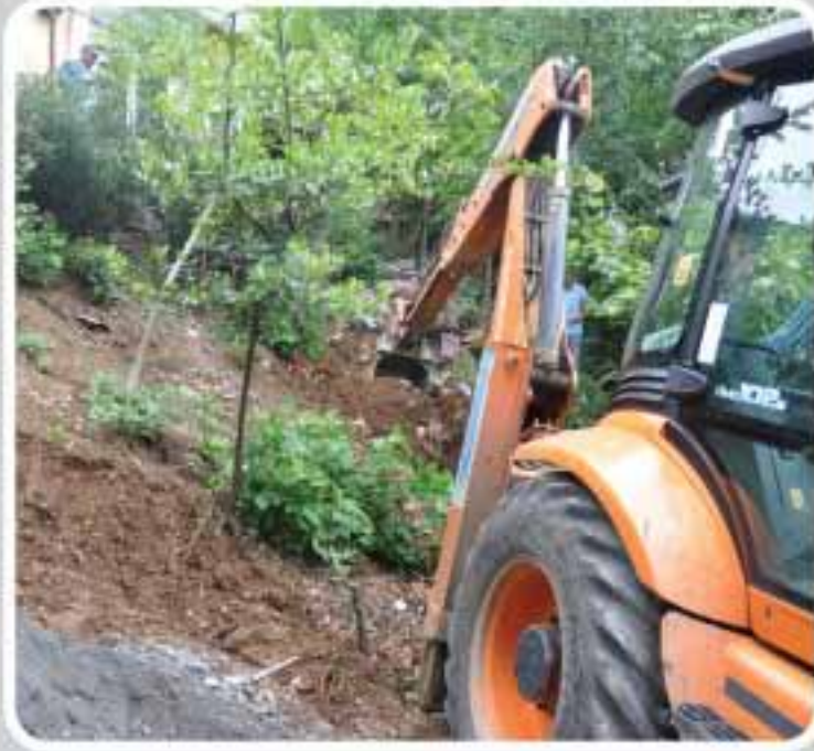
Baltalımanı Toprak Sk. Engelli Rampası - Çalışma Sırasında
