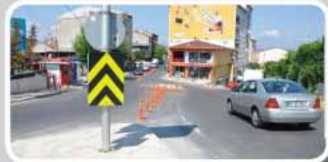
Pınar Mahallesi Yol Ayırma Çalışması
