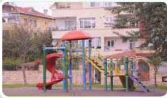
Kilyos Mavi Su Parkı Yenileme Çalışması
