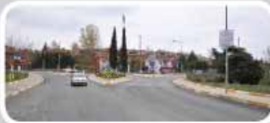
Zekeriyaköy 2.Cad. Asfalt Kaplama Çalışması
