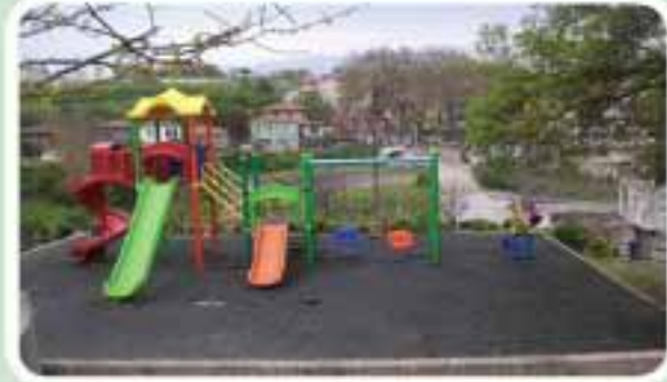
Rumeli Feneri Kale Yolu Parkı Oyun Grubu Yenileme Çalışması
