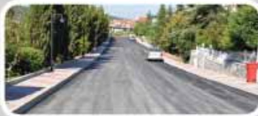
Uskumruköy Güller Vadisi Asfalt Çalışması
