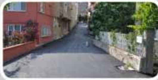
Maden Mah. Ara Sok. Asfalt Çalışması
