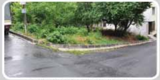
Kireçburnu Deniz Sokak Bordür Çalışması
