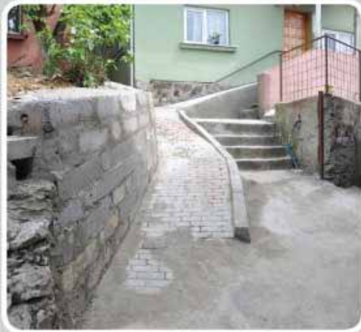
Çayırbaşı Çesme Sk. Engelli Rampası
