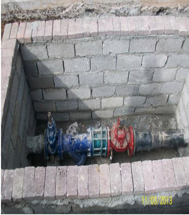
Valilik önüne basınç kırıcı montajı yapıldı
