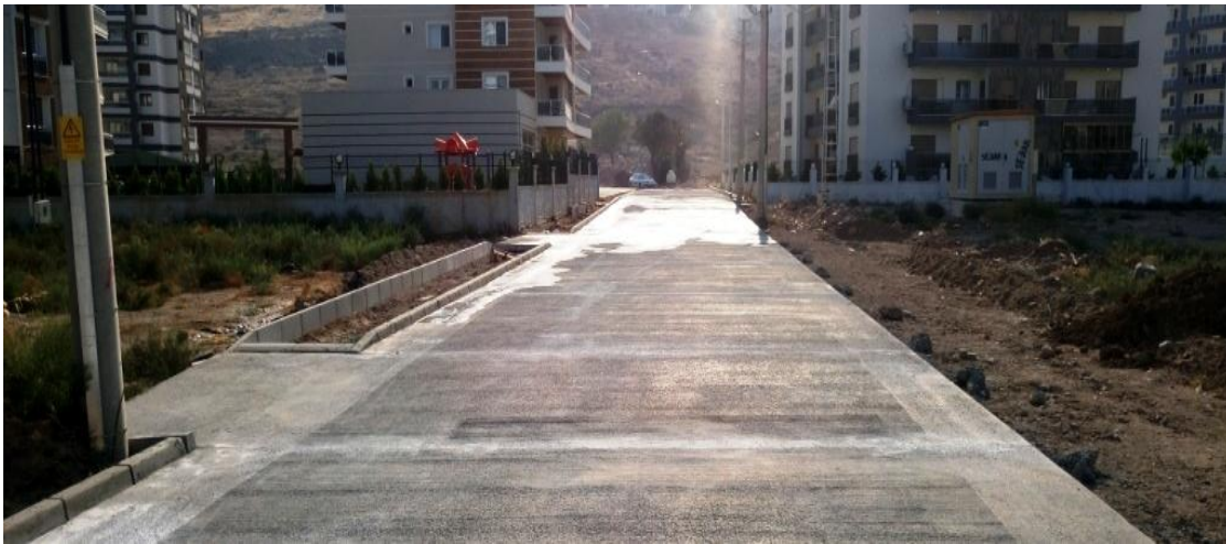
Balatçık Mahallesi 8795/5 Sokakta Tretuvar ve Yol Çalışması
