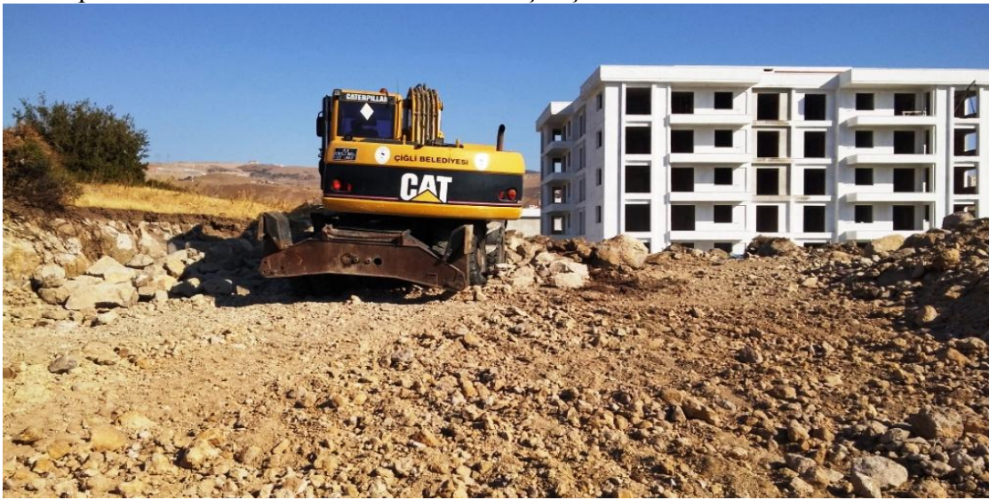
İnönü Mahallesi 9502/7 Sokak Yol Çalışması
