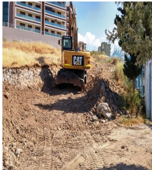
Atatürk Mahallesi 8838/13 Sokak Yol Çalışması
