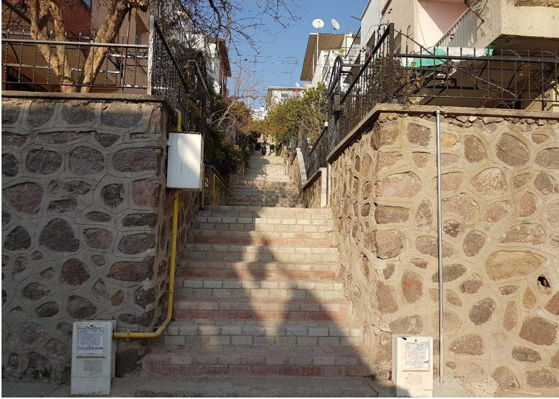
Ahmet Taner Kışlalı Mahallesi 6834 Sokakta Yapılan Merdiven Çalışması
