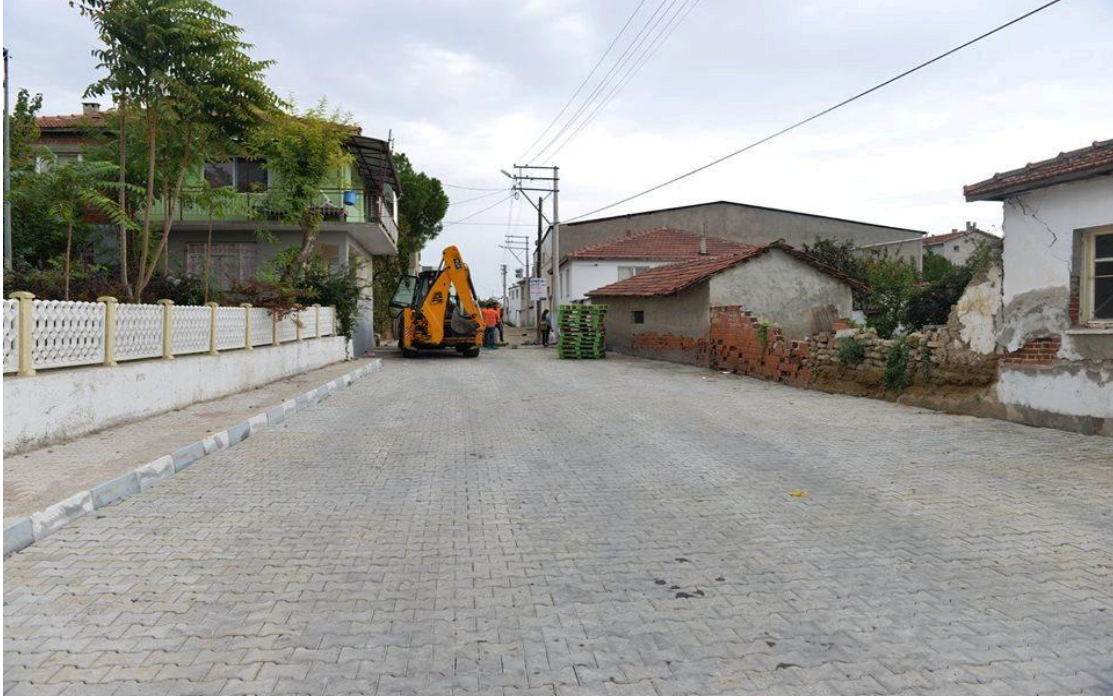
Çiğli Mahallesi Genelinde Parke Yol Çalışması
