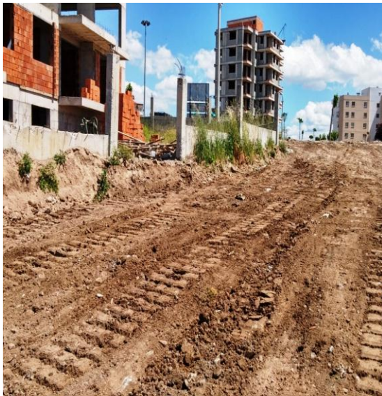
Atatürk Mahallesi 8838/39 Sokak Yol çalışması
