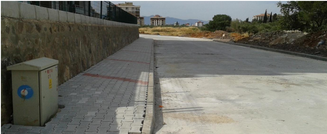
Cumhuriyet Mahallesi 9607/1 Sokakta Tretuvar ve Yol Çalışması
