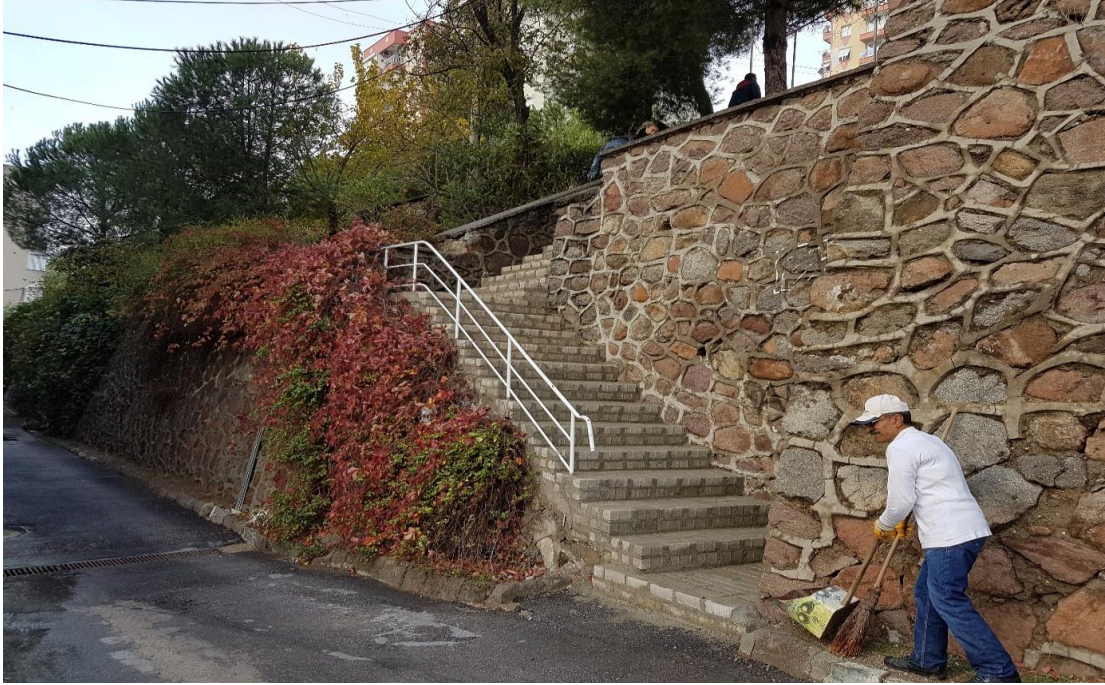
Çağdaş Mahallesi 8050 Sokakta Yapılan Merdiven Çalışması
