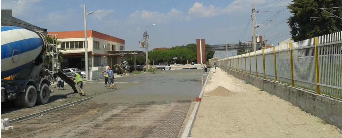
Balatçık Mahallesi 1671/1 Sokakta (Ege Sanayi Sitesi çevresi) Tretuvar ve Yol Çalışması
