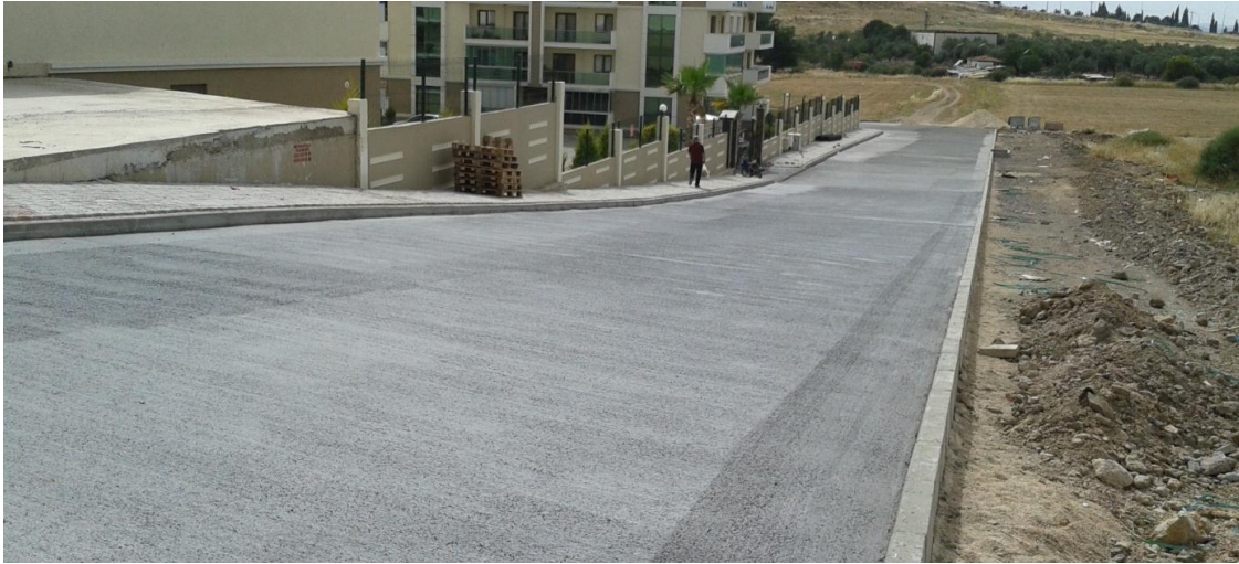
Cumhuriyet Mahallesi 9607/6 Sokakta Tretuvar ve Beton Yol Çalışması
