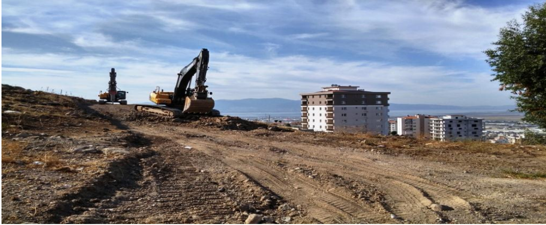
Atatürk Mahallesi 8809/24 Sokak Devamı Yol Çalışması
