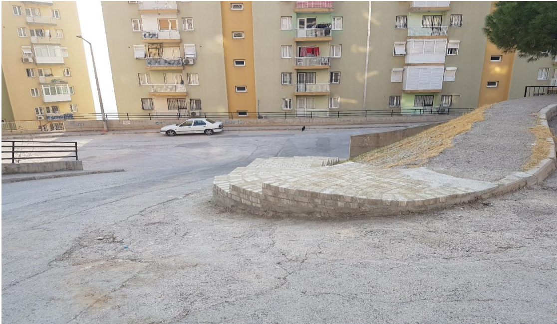
Yakakent Mahallesi 8087/9 Sokakta Yapılan Merdiven Çalışması
