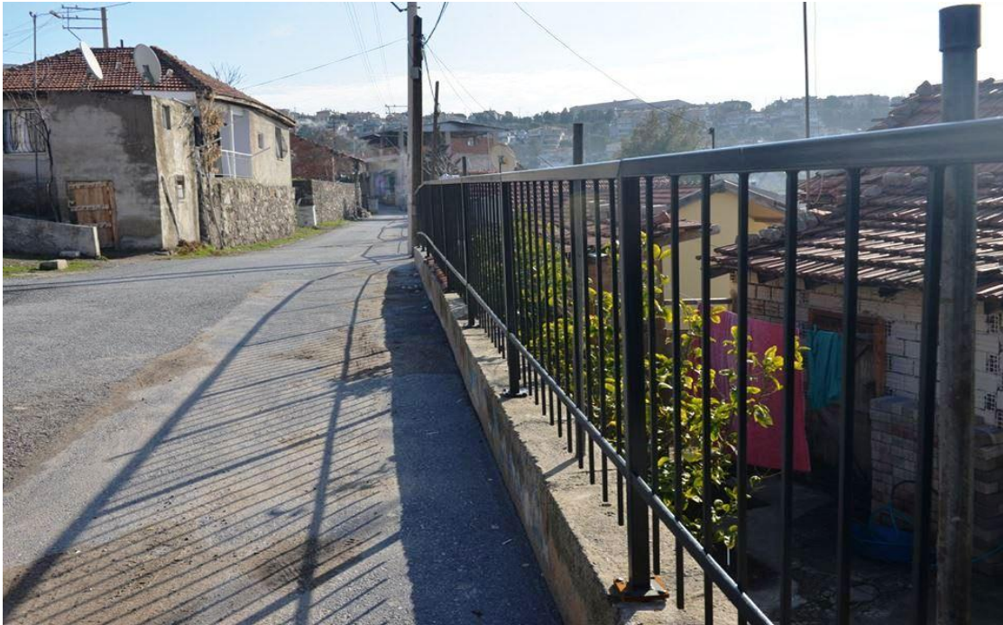
Güzeltepe Mahallesi 8424/3 Sokakta yapılan korkuluk çalışması
