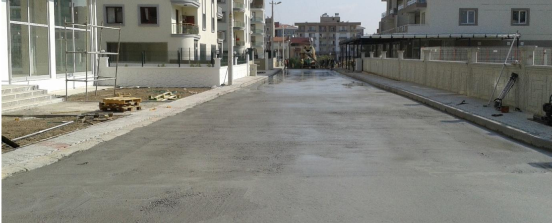
İnönü Mahallesi 8981/4 Sokakta Tretuvar ve Yol Çalışması
