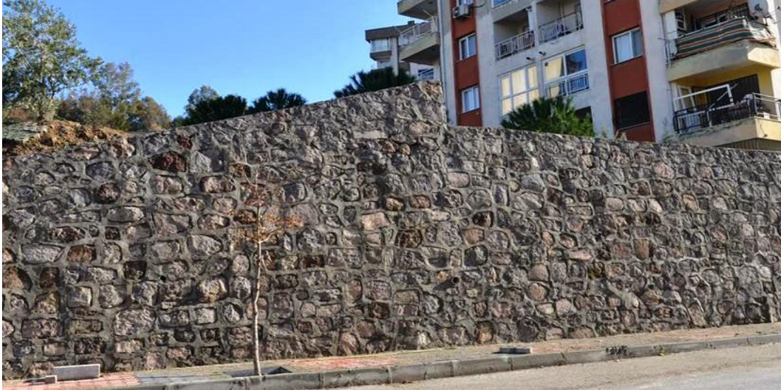
Yakakent Mahallesi 8087/11 Sokakta Taş İstinat Duvar Çalışması
