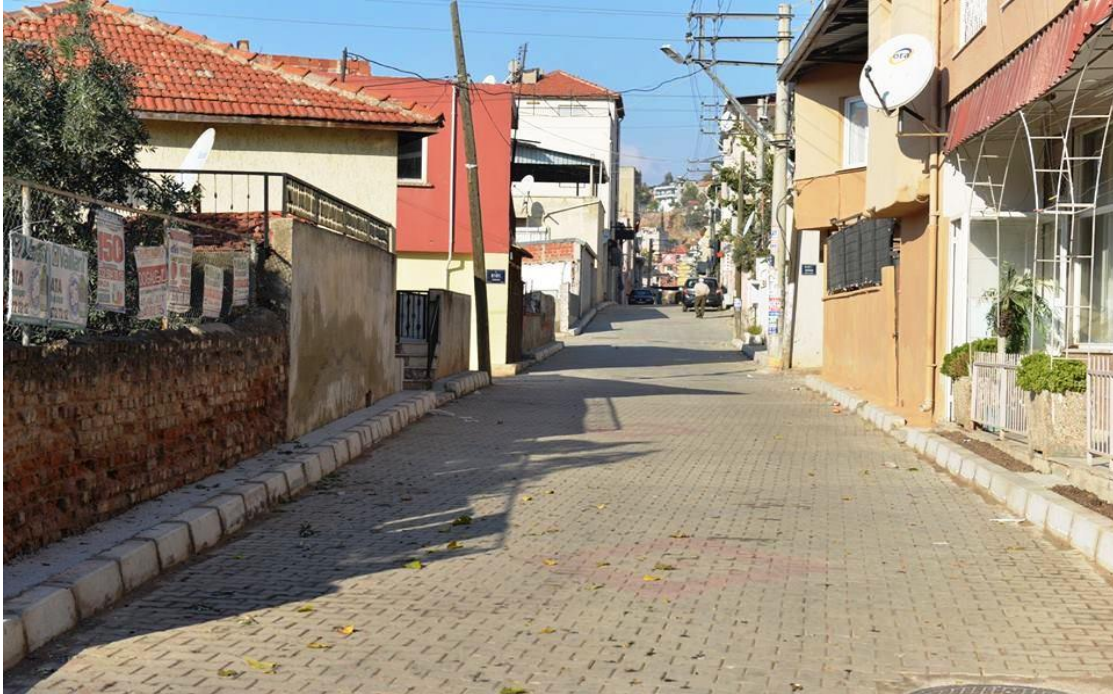
Maltepe Mahallesi 8090 Sokak Parke Yol Çalışması
