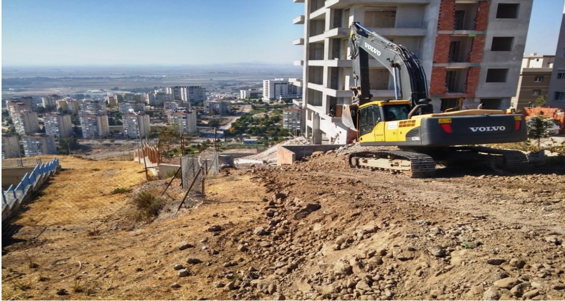
Esentepe Mahallesi 8809/39 Sokak Yanı Yol Çalışması
