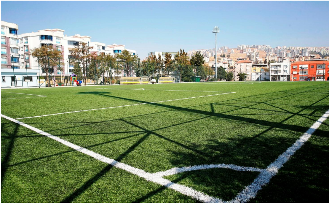
Balatçık Mahallesi Futbol Sahası ve Spor Binası Yapım Çalışması
