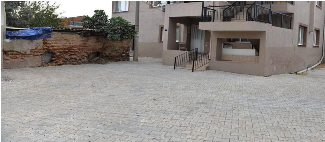
Kaklıç Mahallesi Geneline Parke Yol Çalışması
