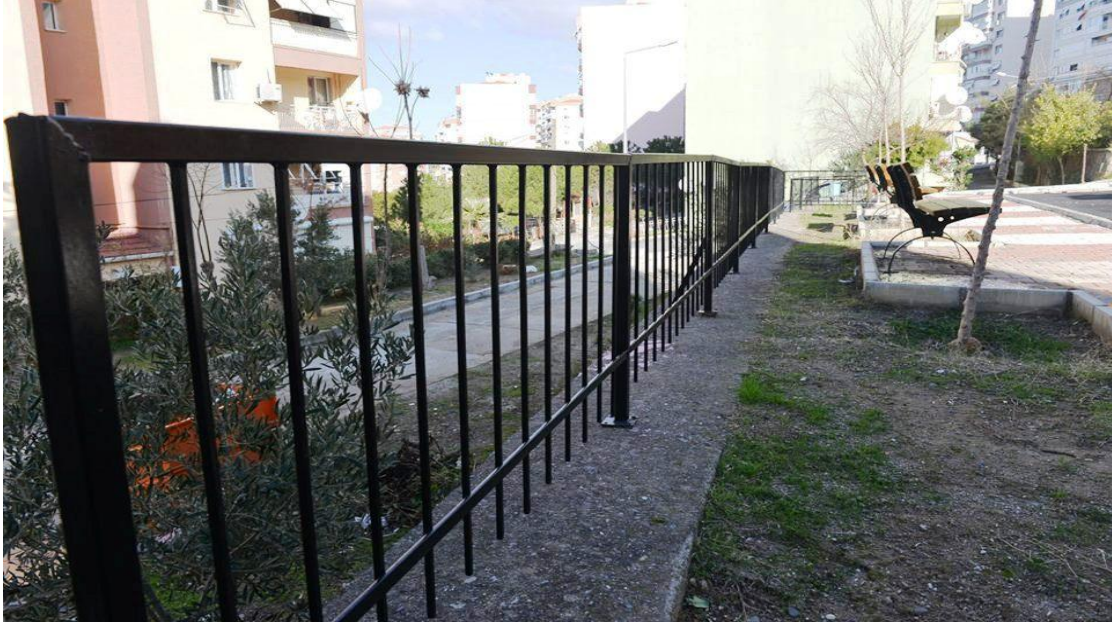
Aydınlıkevler Mahallesi 6795 Sokakta yapılan korkuluk çalışması
