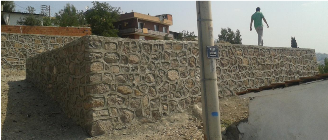
Şirintepe Mahallesi 8131 Sokakta Taş İstinat Duvar Çalışması
