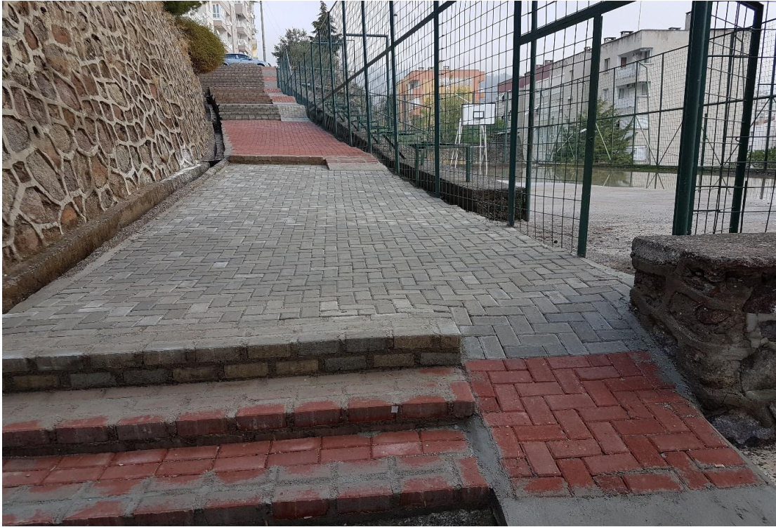
Çağdaş Mahallesi 8050 Sokakta Yapılan Merdiven Çalışması
