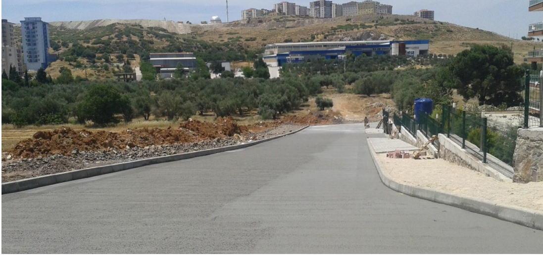
Cumhuriyet Mahallesi 9607/7 Sokakta Tretuvar ve Beton Yol Çalışması
