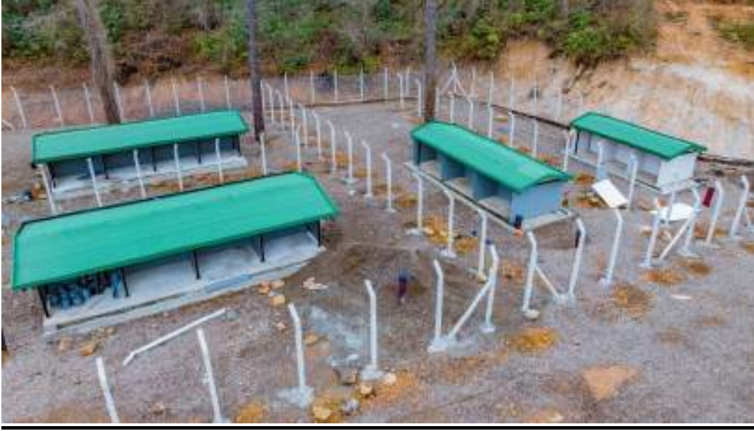
Fevzi Çakmak Mahallesi Basketbol Sahası
