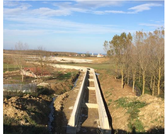
Kampüs Alanı Dere Islahı Yapımı
