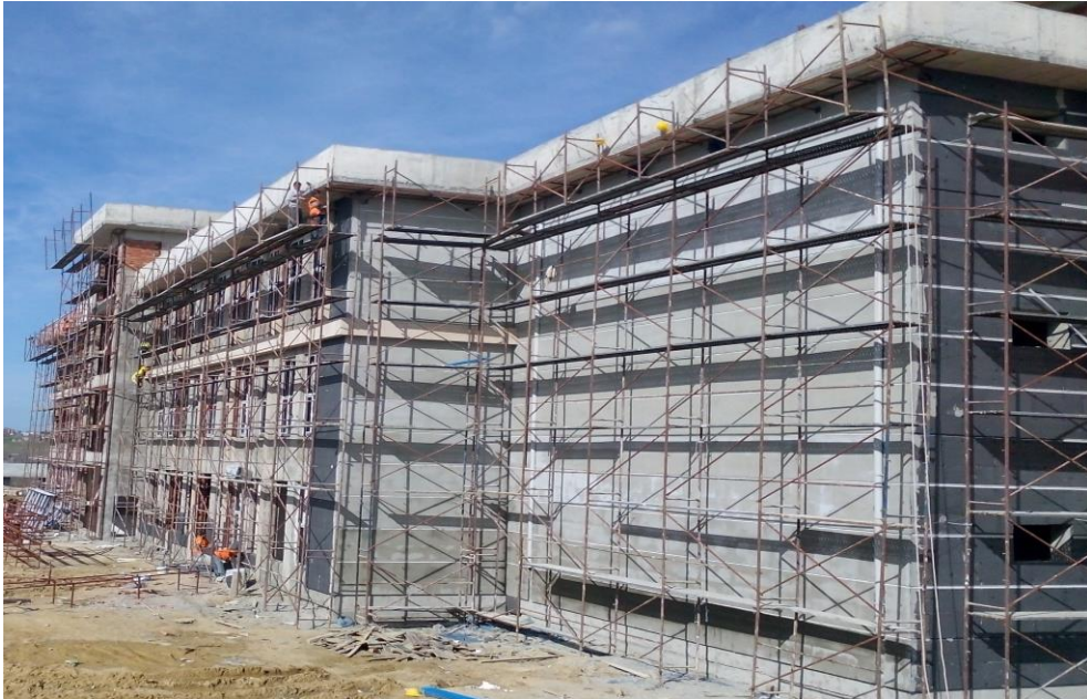
İlahiyat Fakültesi Binası Yapımı
