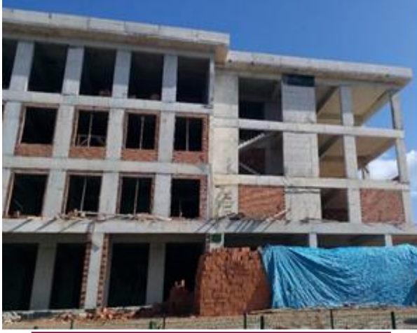
Sinop Meslek Yüksekokulu Binası Yapımı
