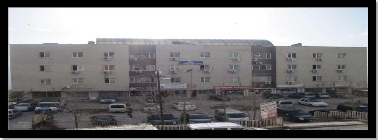
Şırnak İl Özel İdaresi Hizmet Binası
