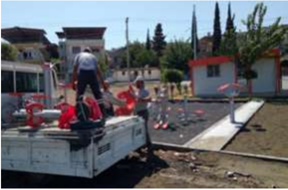
Yıldırım Tepe Muhtarlık Binası Yanı
