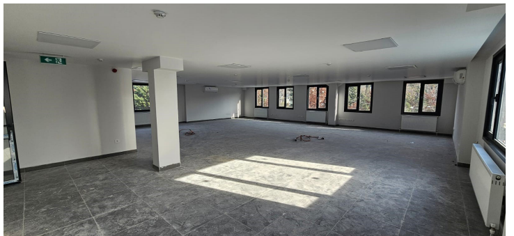
Ek Hizmet Binası İç Görünüm
