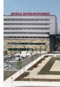
Bursa Şehir Hastanesi
