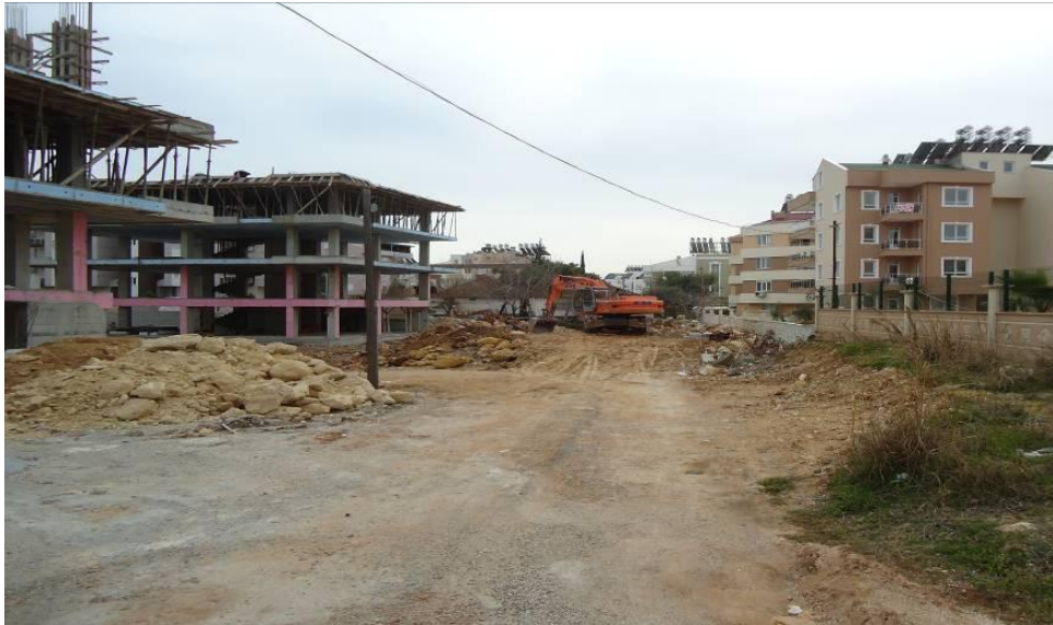
Muhtesat kamulaştırması yapıldıktan sonra sokağın durumu
