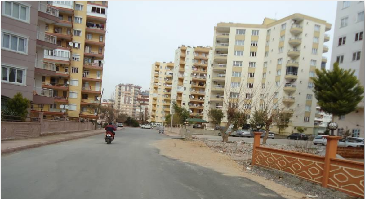
Muhtesat kamulaştırması yapıldıktan sonra sokağın durumu
