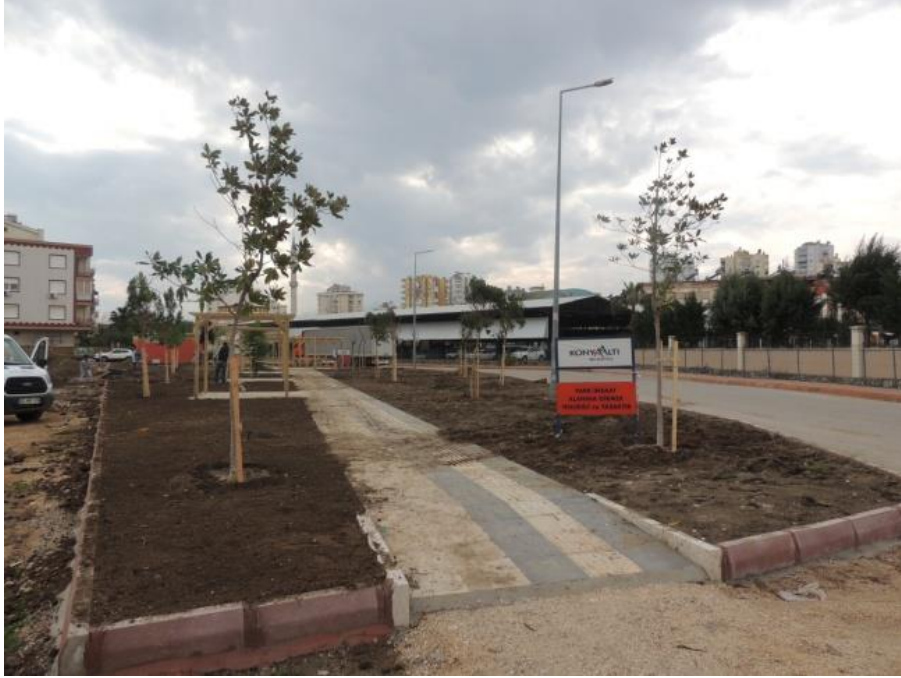
Park yapım çalışmaları
