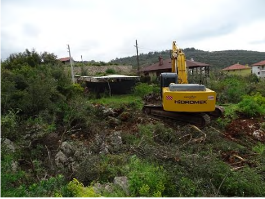
Park yapım çalışması
