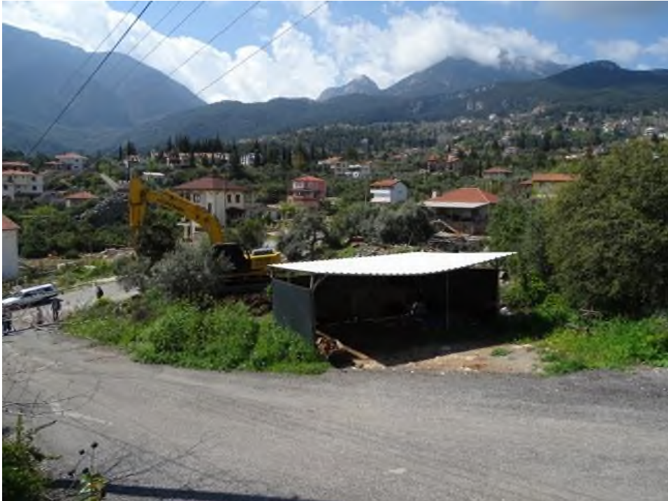
Park yapım çalışması
