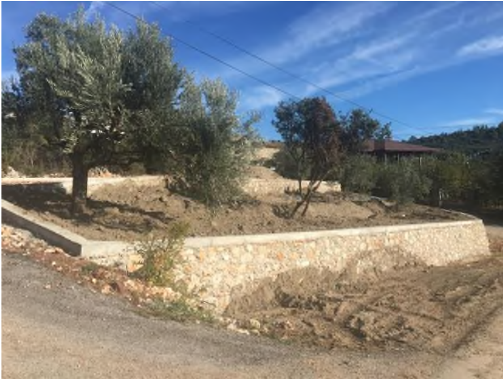
İstinat duvarı uygulaması
