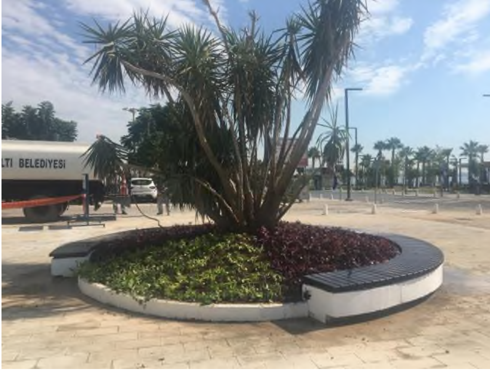
Park yapım çalışmaları
