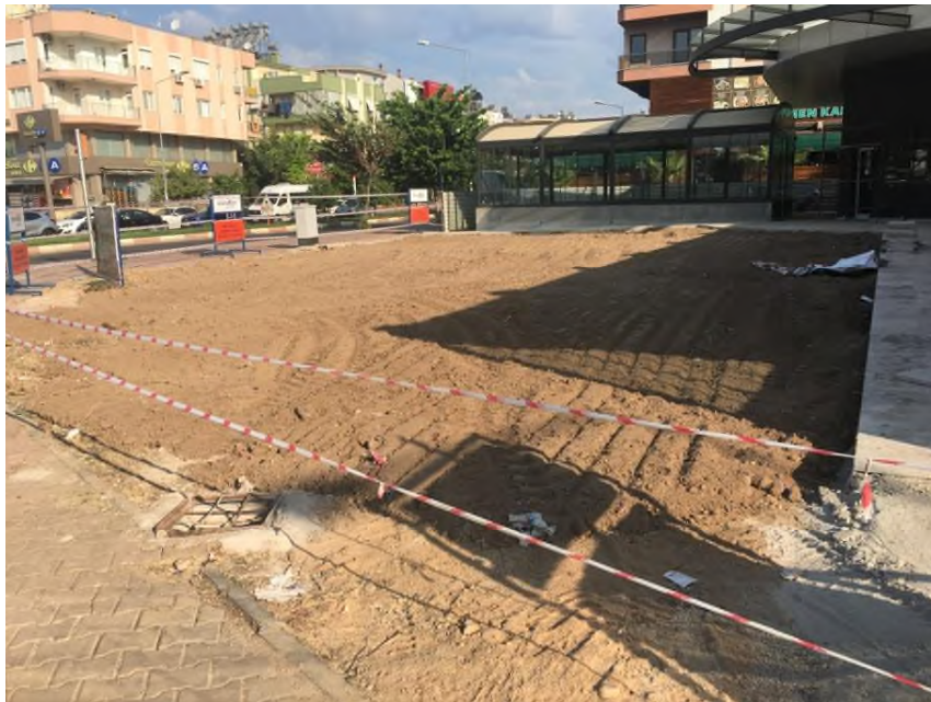
Gençlik Lokali peyzaj yapım çalışmaları
