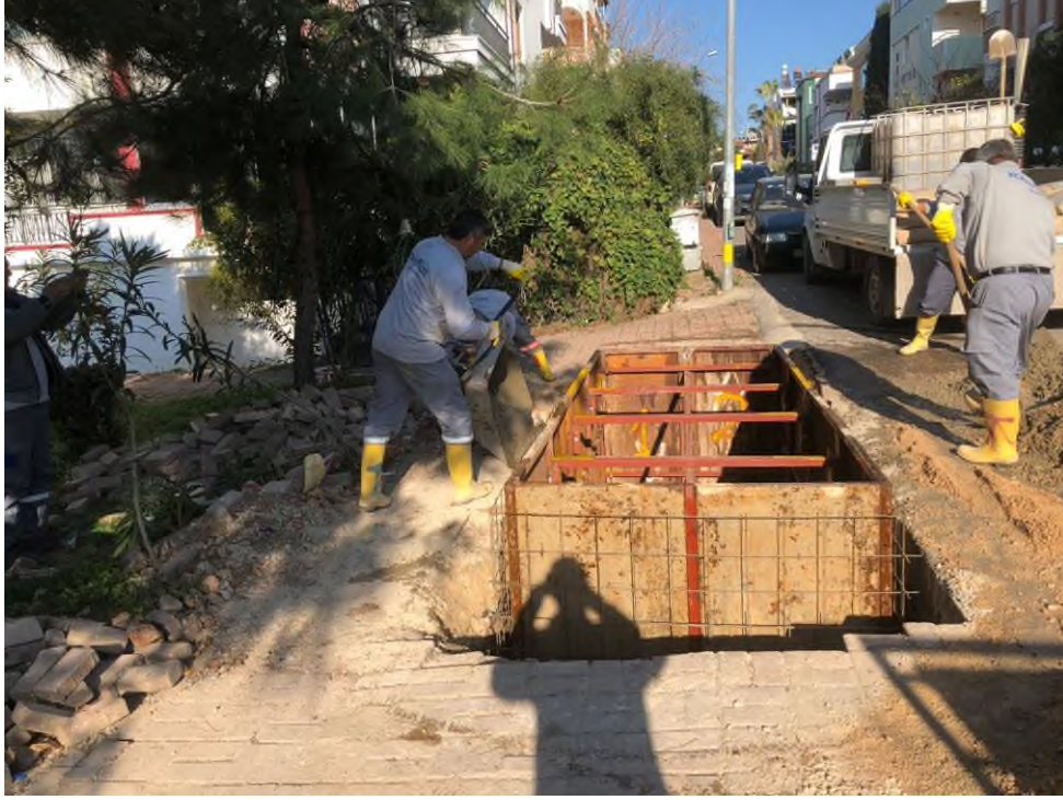
Yeraltı konteyner sistemi montaj hazırlığı
