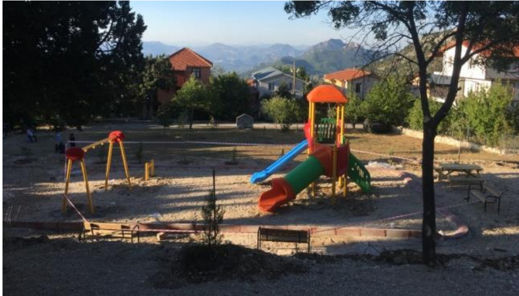
Park yapım çalışmaları
