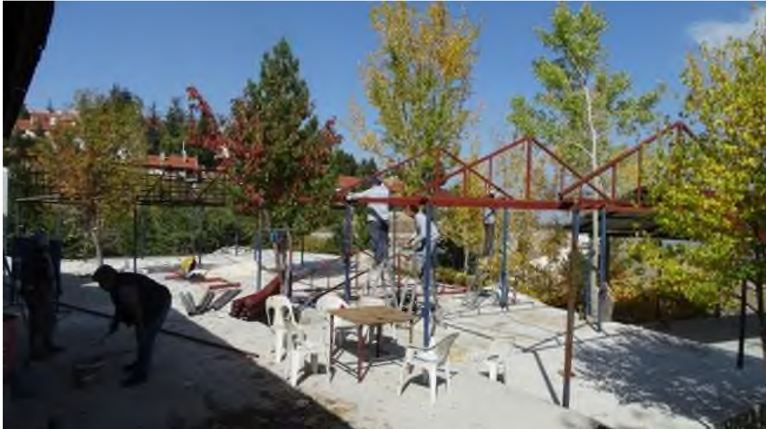
Park yapım çalışmaları
