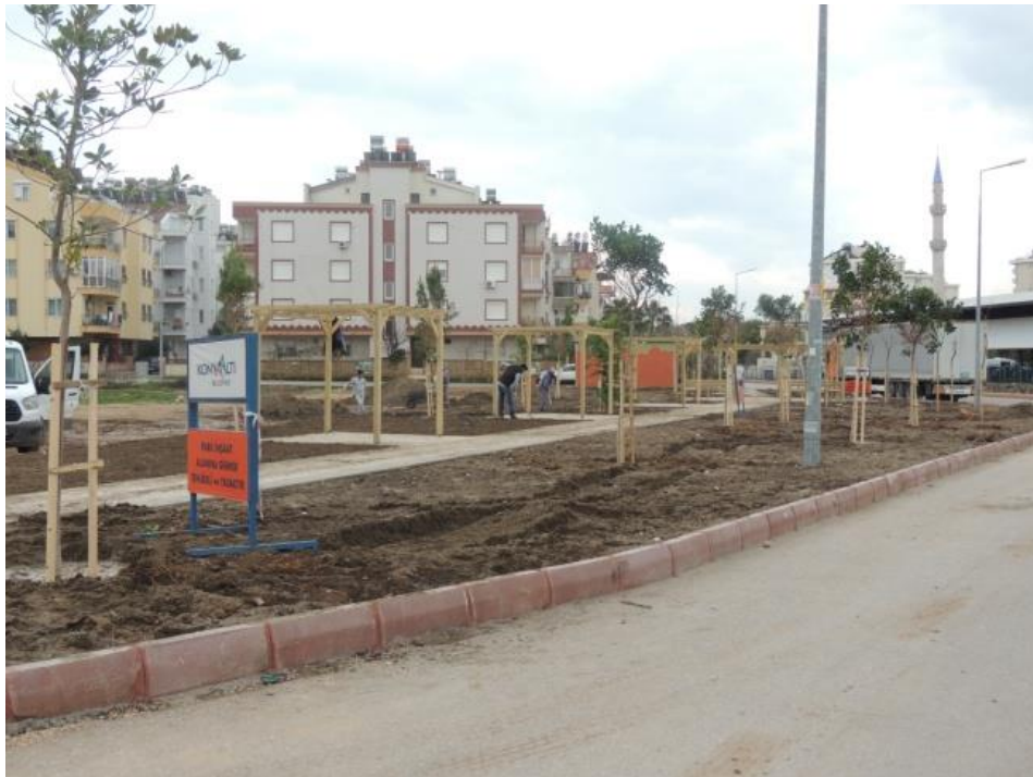
Park yapım çalışmaları
