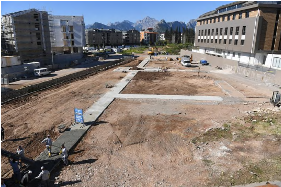
Park yapım çalışmaları
