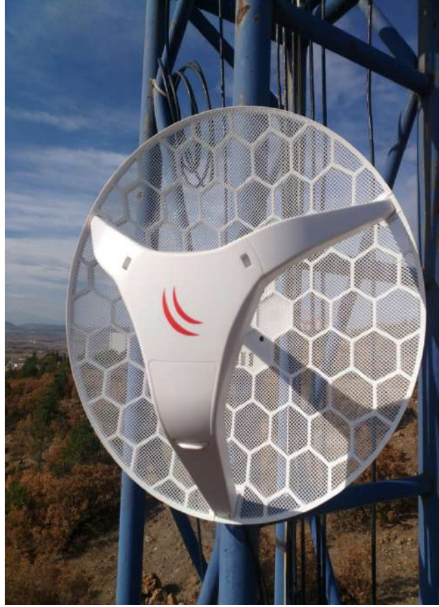
33- YAŞLI BAKIM MERKEZİ HEMŞİRE ÇAĞRI SİSTEMİ, TELEFON SANTRALİ VE İNTERNET BAĞLANTISI KURULUMU YAPILDI
