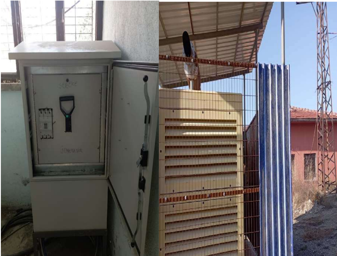
8- GÖBEL BUNGALOV EVLERİ ENERJİ YER ALTI VE HAVAİ HAT ÇEKİMİ YAPILDI
