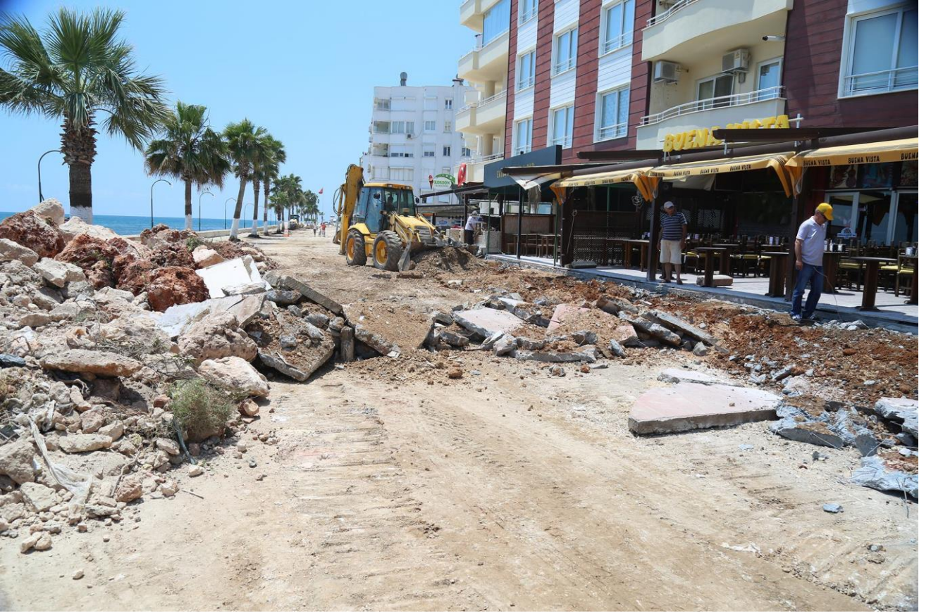
* Viranşehir sahil yolu yenileme çalışmamız
