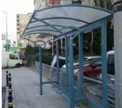
Durak İmalatı Ve Montajı
