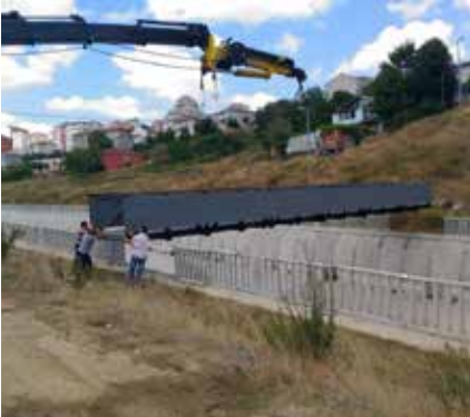
Mevlana Mahallesi Köprü İmalatı ve Montajı
