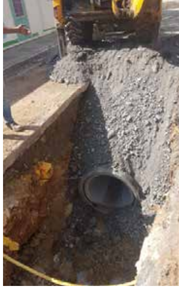
Suadiye Mahallesi Suadiye Cami Sokak
