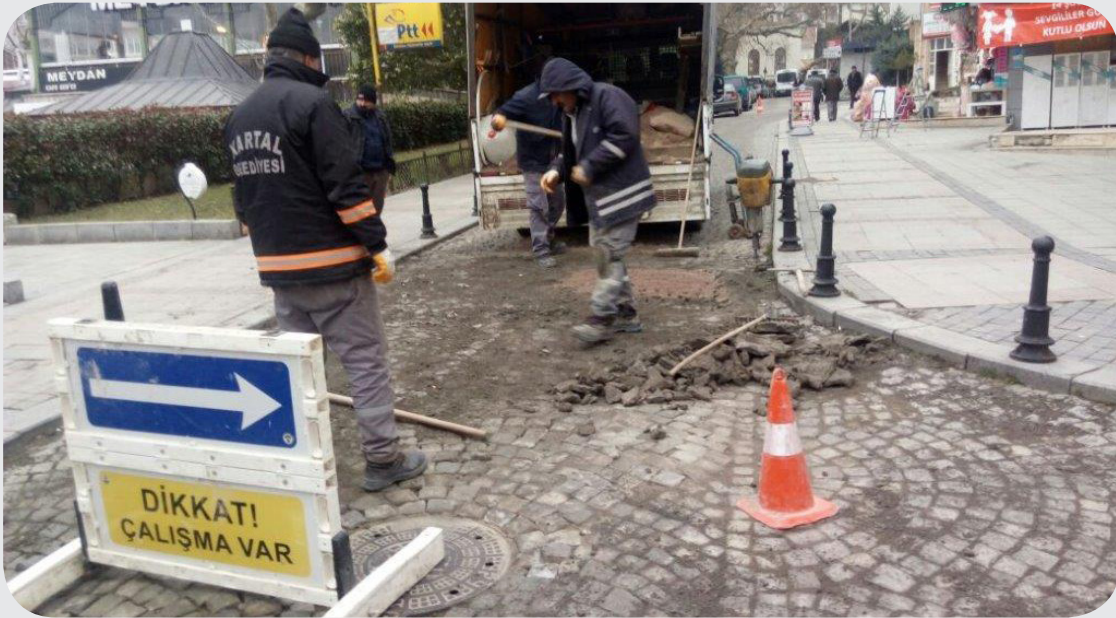
Yakacık Kültür Merkezi Kilittaşı Yapım Çalışması
