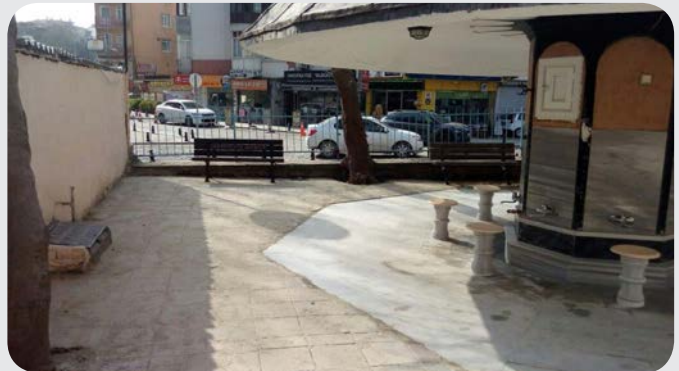
Şehir Er Serhat Şanlı Ortaokulu Engelli Rampası Yapımı
