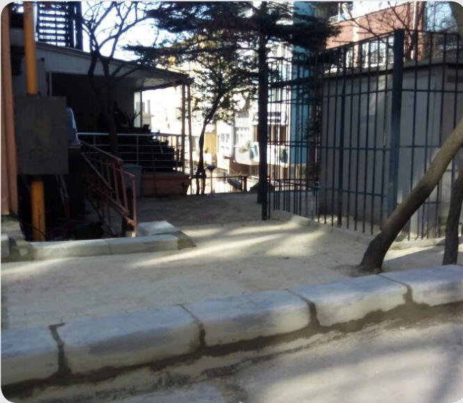
Yavuz Selim Devlet Hastanesi Kilitaşı ve Bordür Yapım Çalışması
