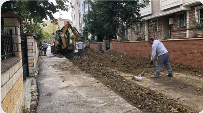
Esentepeler Mahallesi Karasu Sokak Yağmur Suyu Kanal Çalışması
