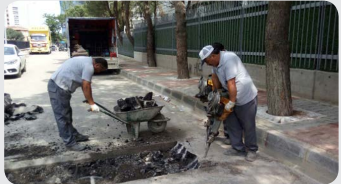
Orhantepe Mahallesi Çini Sokak Yağmur Suyu Kanal Çalışması
