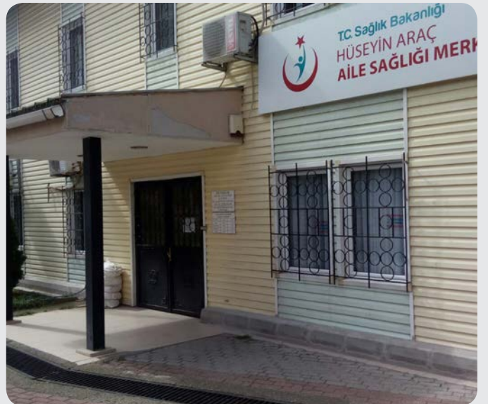
Hüseyin Araç Aile Sağlık Merkezi Bordür Yapım Çalışması
