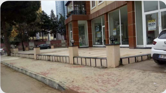
Orhantepe Mahallesi Çini Sokak Bordür Çalışması
