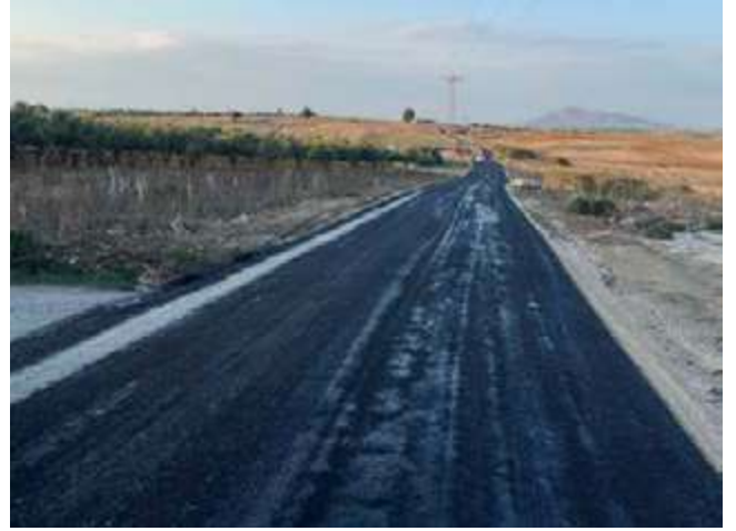
Ceyhan, Yumurtalık, Yüreğir Mahalle Bağlantı Yollarına Sathi kaplama
