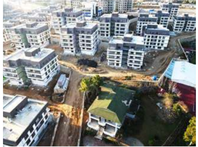
Göl Mahallesi GÖB & KDGA İnşaat Çalışmaları
