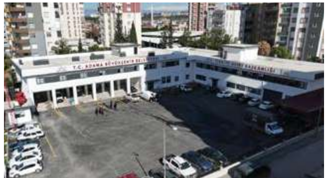
Yüreğir İlçesi, Mustafa Kemal Paşa Bulvarı, İtfaiye Hizmet Binası
