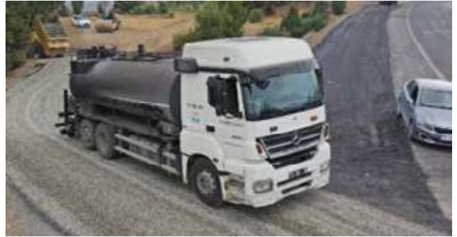
Pozantı İlçesi Sathi Kaplama Çalışmaları
