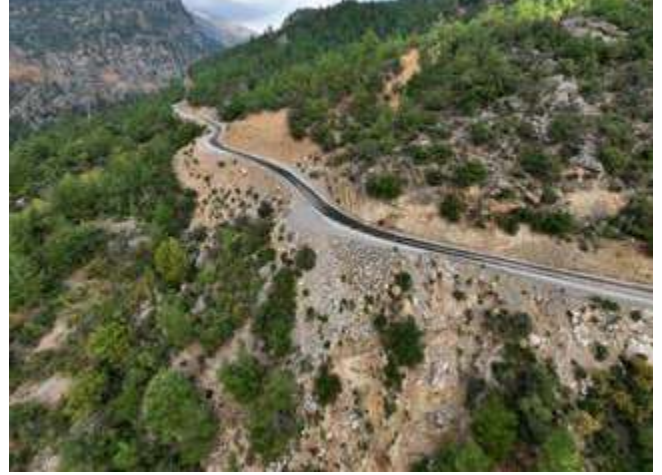
Küp Şelalesi Yolu Sathi Kaplama
