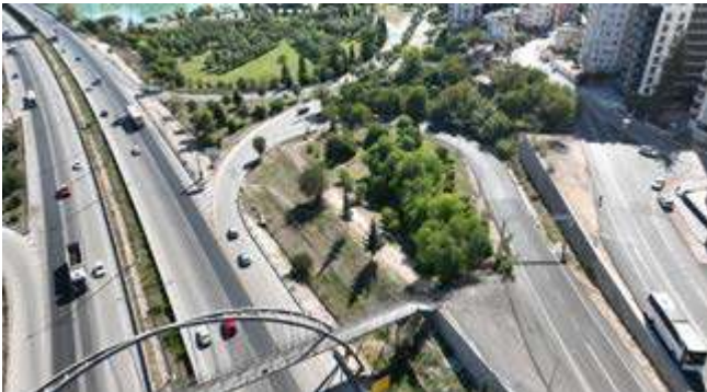
Hastaneler Kavşağı Asfalt Çalışması
