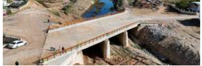
Kozan Şevkiye Mahalle Köprüsü
