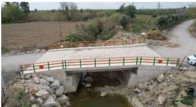
Kozan İlçesi İdem Mahallesi Köprüsü
