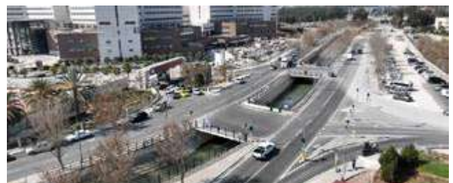
Şehir Hastanesi- Yeşil Bulvar Üzeri Köprü
