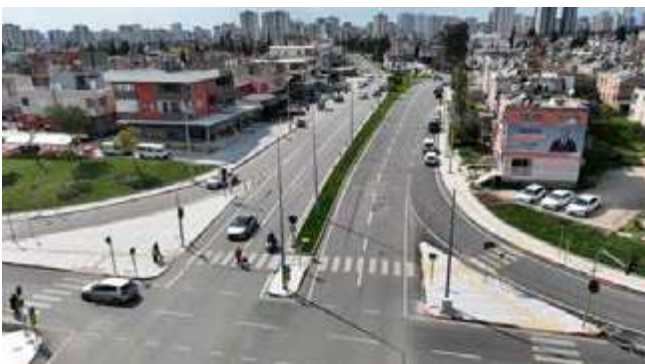
Hilmi Kürklü Bulvarı Asfalt Çalışması
