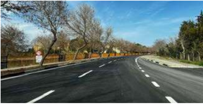
Yeşil Bulvar Yol ve Engelsiz Hayata Uygun Şekilde Yürüyüş Yolu
