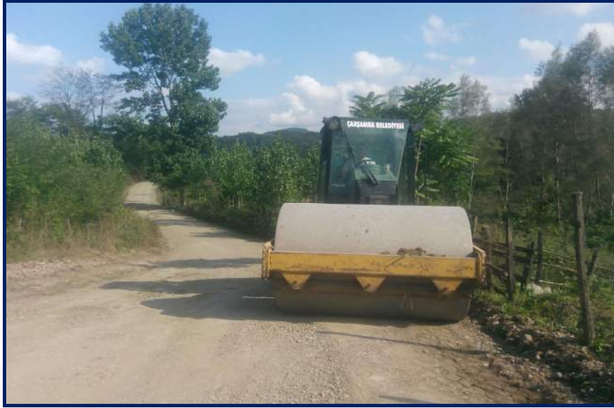
( Kemer Mahallesi Yol Çalışmaları )
