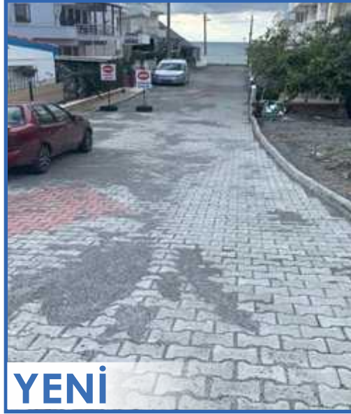
3608 SOKAK PARKE KAPLAMA
