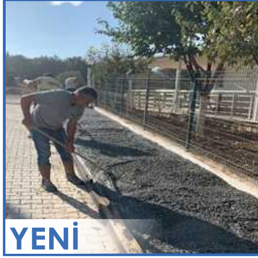
2457 SOKAK KALDIRIM ÇALIŞMASI
