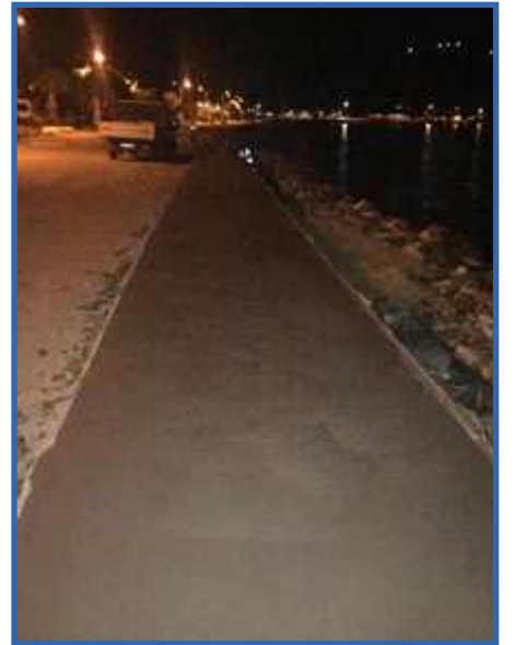
AKBÜK SAHİL KALDIRIM ÇALIŞMASI
