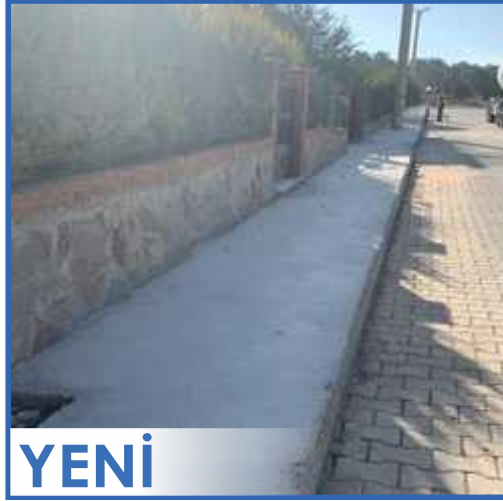
2464 SOKAK KALDIRIM ÇALIŞMASI
