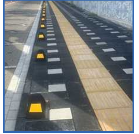
DOLUNAY CADDESİ KALDIRIM ÇALIŞMASI
