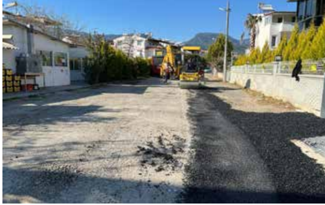
Cumhuriyet Mah SSK Cad Rothmix Yamalama
