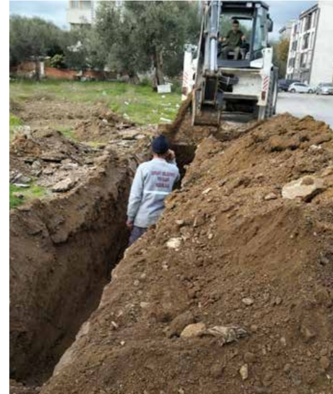
Eroğlan 57 Alay Cad Yağmur Hattı Çekimi
