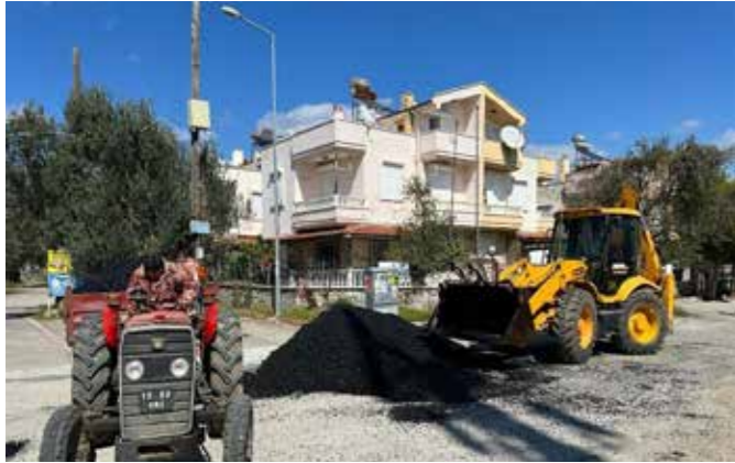
Cumhuriyet Mah SSK Cad Rothmix Yamalama
