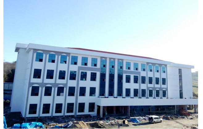
Meslek Yüksekokulu İnşaatı
