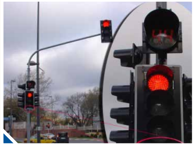
Sinyalizasyon Bakım Onarım Çalışması
