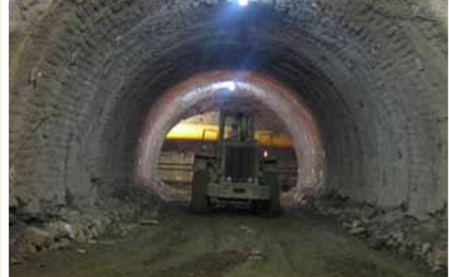
İstanbul'da Bir Metro İnşaatı
