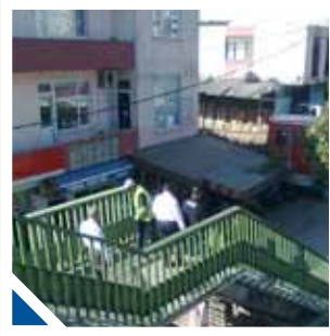
Üst Geçit ve Köprü Yapım Çalışmaları
