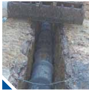
Yağmur Suyu Bakım, Onarım ve Yapım Çalışmaları
