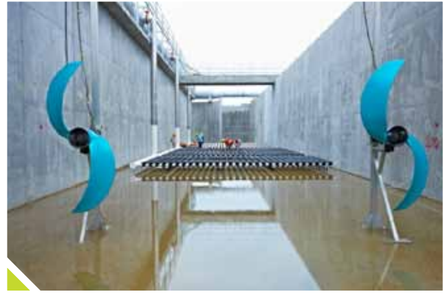
Ataköy Atıksu Arıtma Tesis İnşaatı
