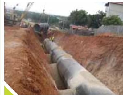
Asya Bölgesi Müteferrik İçmesuyu Şebeke ve Kat Ayrımı İnşaatı (6)
