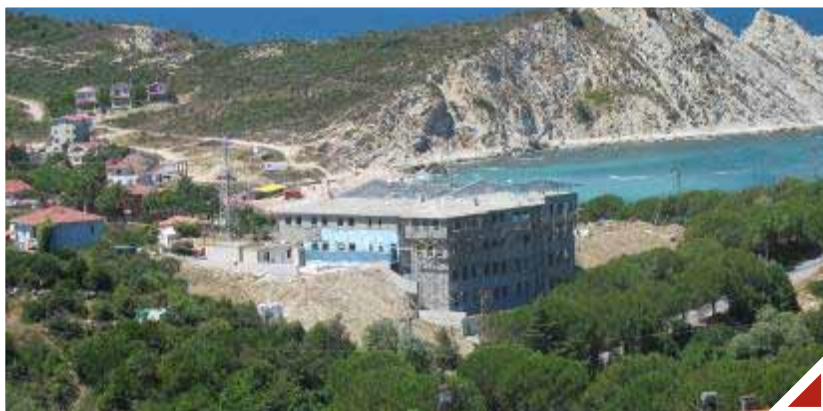
İnşaatı devam eden Şile Karacaköy İtfaiye Binası
