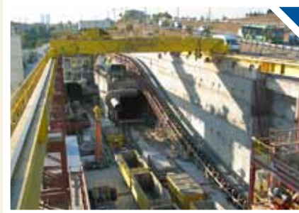
Otogar - Bağcılar (Kirazlı) Hafif Metro Hattı İnşaatı
