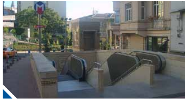
Şişhane Metro Durağı
