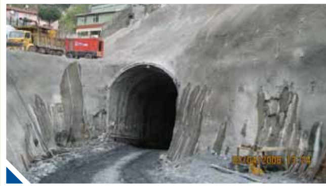
Sarıyer-Çayırbaşı Arası Karayolu Tüneli Yolu İnşaatı
