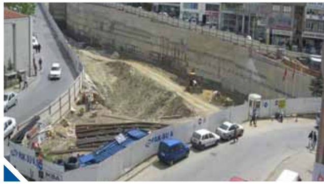
Güngören-Merter Mevkii Otopark İnşaatı
