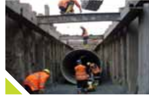
Avrupa Yakası 5.Kısım Atıksu Kanalı, Yağmursuyu Kanalı Ve Dere Islahı İnşaatı
