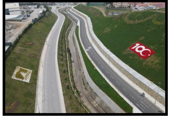
Ramazanoğlu-Güllübağlar-Kartal-Pendik-Tuzla Bağlantı Yolu Çevre Düzenlemesi
