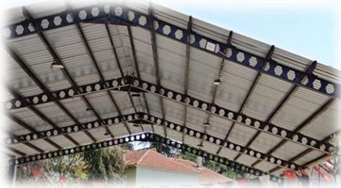
Çok Amaçlı Salonların Aydınlatma Sistemi Onarımları
