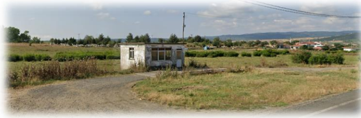
Balabancık Mahallesi Yüksek Çekerli Taşıt Kantarı
