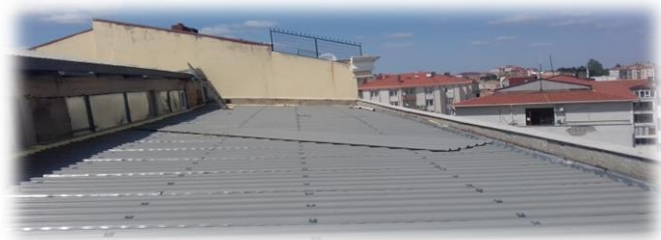
Belediye Ek Hizmet Binası Çatı Onarım Çalışması
