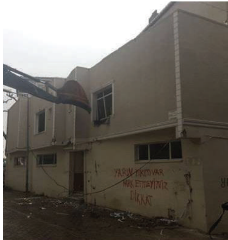
Celaliye Mahallesi Eski Belediye Hurdalık Yıkımı Binası Yıkımı
