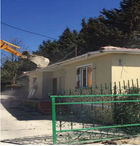
Karaağaç Mahallesi İşgali Bina Yıkımı
