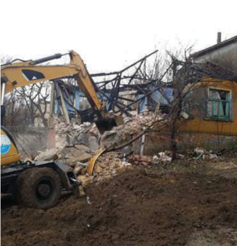
Ahmediye Mahallesi Yıkım Çalışması
