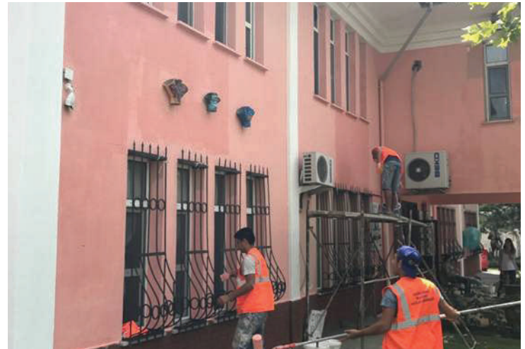
Barış Manço Kültür Merkezi Dış cephe boyama çalışması
