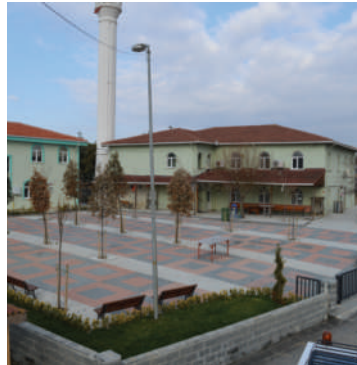
KARAAĞAÇ MAHALLESİ ESENTEPE CAMİİ BAHÇE DÜZENLEMESİ
