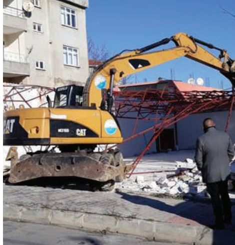
Türkoba Mahallesi Yıkım Çalışması
