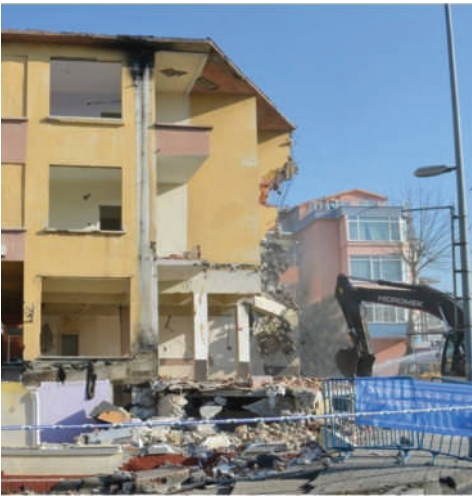
Dizdariye Mahallesi Kentsel Dönüşüm İçin Bina Yıkımı
