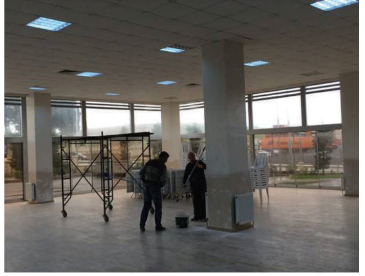
Celaliye Sosyal Tesisleri Yenileme Çalışmaları
