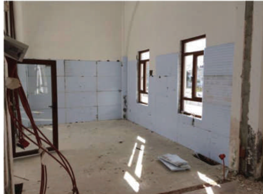
Kuba Camii Yalıtım ve Pencere tamirat çalışması
