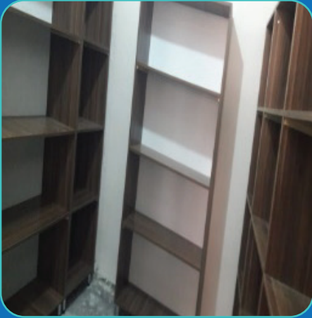
Şehitler Derneği Dolap Yapımı
