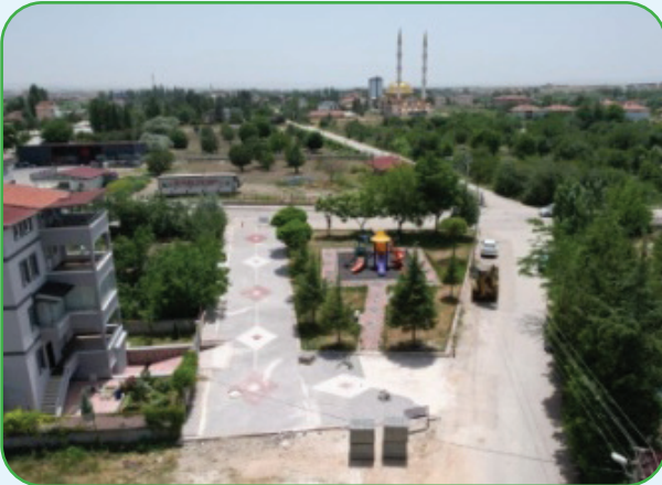
Cumhuriyet Mahallesi Vefa Sokak'ta 440 m 2 Kilit taşı, 45 m 2 Parke Taşı, 30 mt Bordür Döşeme çalışması yapılmıştır.
