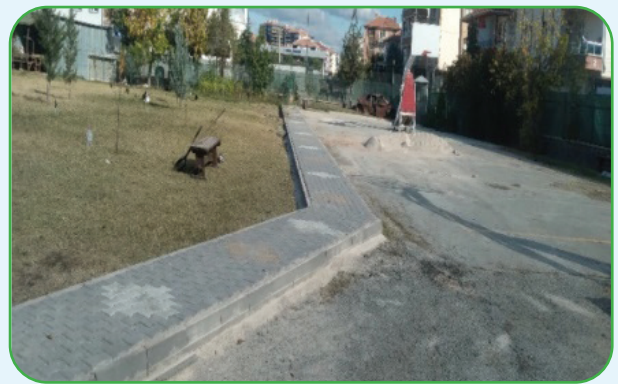
Jandarma İlçe Komutanlığında 85 m 2 Kilittaş Döşeme ve 130 m bordür döşeme çalışması yapılmıştır.
