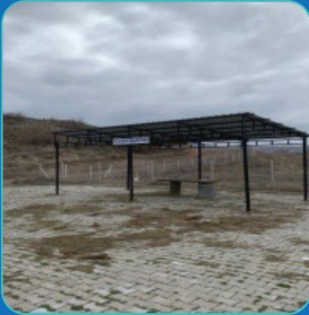
Kavaklı Mahallesi Sundurma Yapımı
