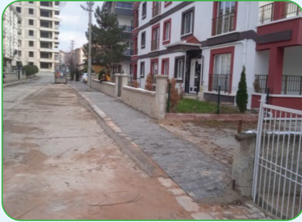
Yavuz Selim Mahallesi Zümrüt Sokak'ta 70 m 2 Kilittaş Döşeme çalışması yapılmıştır.
