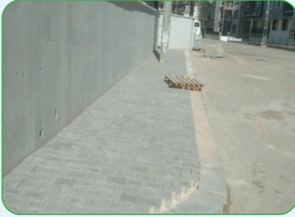
Cumhuriyet Mahallesi Zafer Sokak'ta 200 m 2 Kilittaş Döşeme çalışması yapılmıştır.
