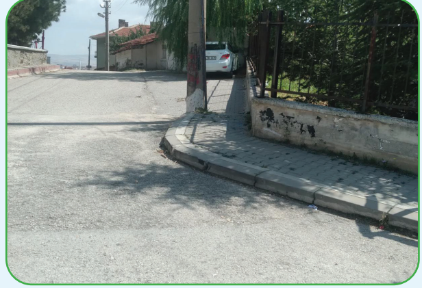
Barbaros Mahallesi Çalışkan Sokak'ta 70 m 2 Kilit taşı Döşeme çalışması yapılmıştır.
