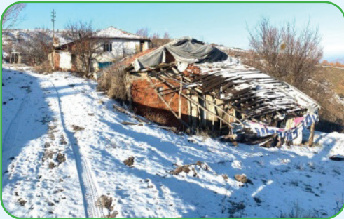
Atatürk, Barbaros, Dumlupınar, Gökçedere, Mutlu, Sığırlıhacı, Tuğla Mahallelerinde toplam 10 adet metruk binası yıkımı yapılmıştır.
