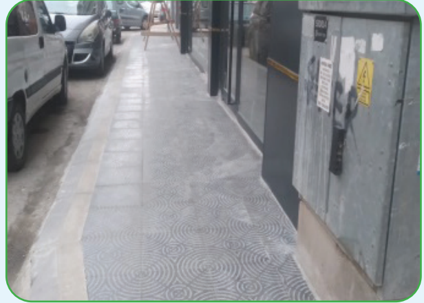
Cumhuriyet Mahallesi Arı Sokak'ta 50 m 2 Karo Döşeme çalışması yapılmıştır.
