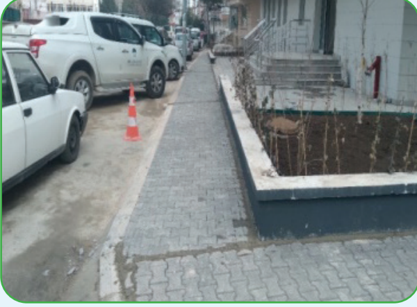
Yavuz Selim Mahallesi Tapu Binası önü 65 m 2 Kilit taşı Döşeme çalışması yapılmıştır.
