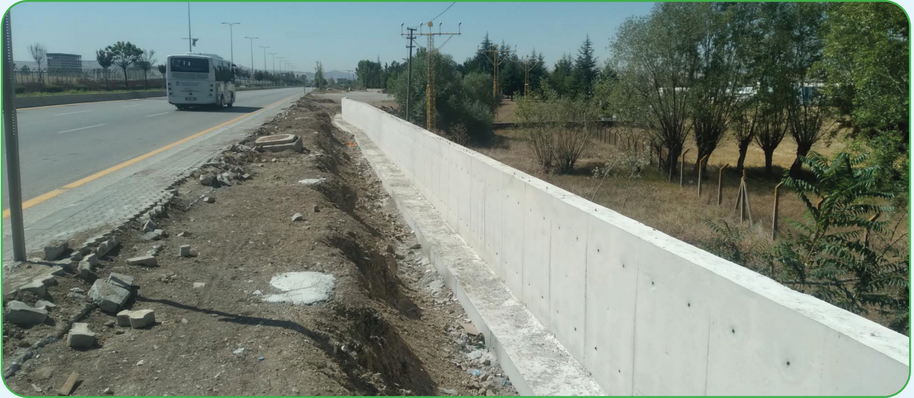
Yenice Mahallesi mezarlık yoluna istinat duvarı ve dolgu çalışması tamamlanmıştır.
