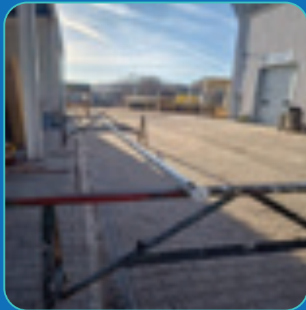
Karaçam Mahallesi Bayrak Direği Yapımı
