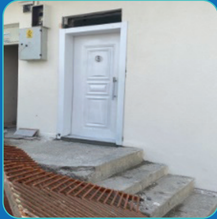
Akkuzulu Mahallesi Çelik kapı yapımı
