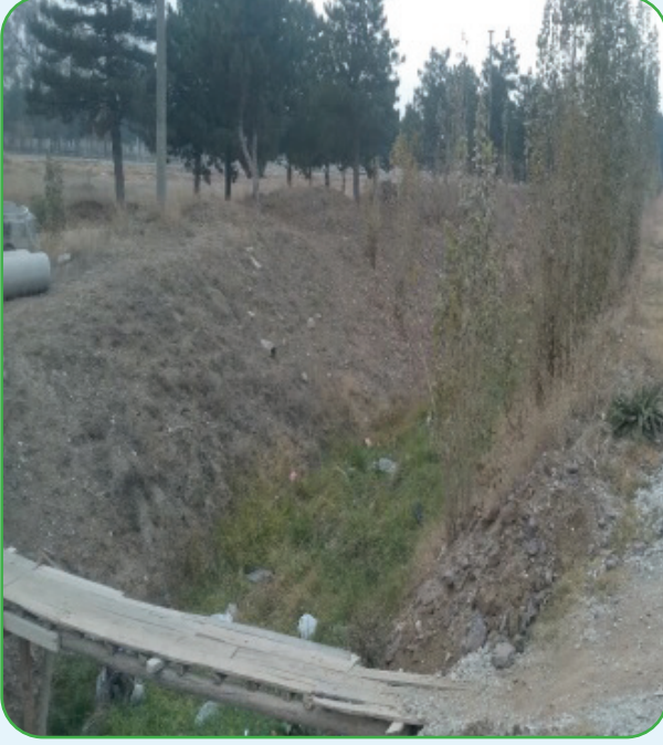
Yıldırım Beyazıt Mahallesi Söğütözü Deresi- Irmak- Irmak 1 Sokak yaya geçiş Köprüsü tamamlanmıştır.
