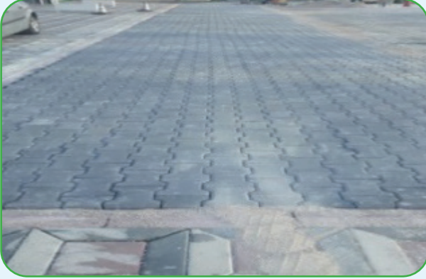
Cumhuriyet Mahallesi Endüstri Sokak'ta 190 m 2 Kilit taşı Döşeme çalışması yapılmıştır.
