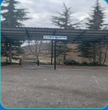
Sarısu Mahallesi Sundurma Yapımı
