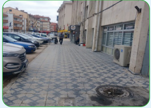
Yavuz Selim Mahallesi Duru Sokak'ta 70 m 2 Karo Döşeme çalışması yapılmıştır.
