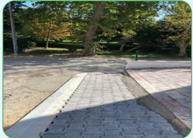
Barbaros Mahallesi Kordon 7 Sokak'ta 35 m 2 Parke ve 38 mt Bordür Döşeme çalışması yapılmıştır.
