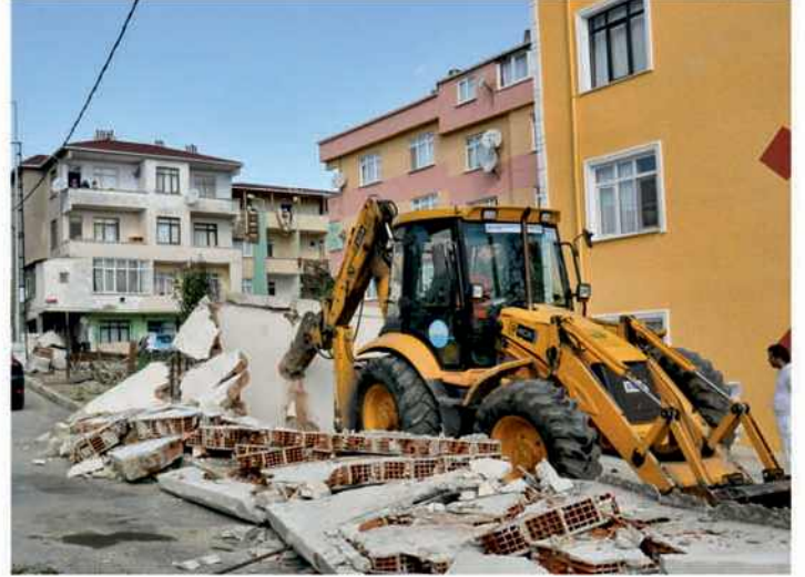
Tepecik cadde ve sokaklarında işgal ve kaçak yapı yıkım çalışmalarından görünüm
