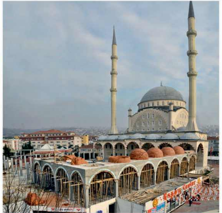
Kûba Camii Şadırvan ve Avlu Çalışmaları
