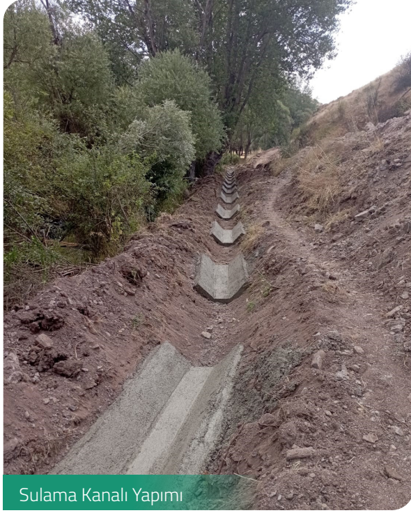
Sulama Kanalı Yapımı
