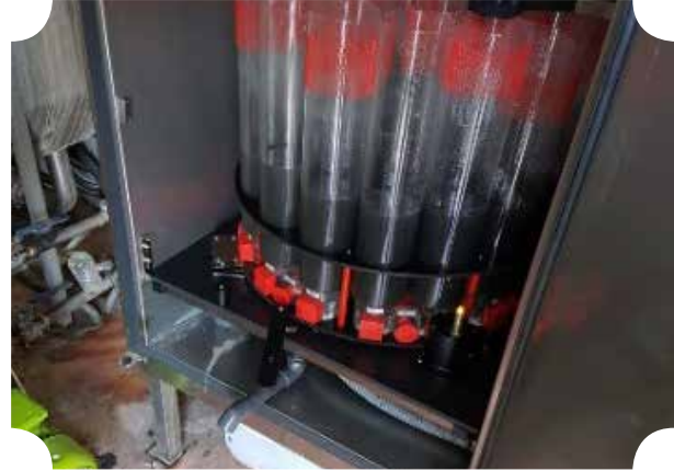
Uzaktan İzleme Sistemi (SCADA)
