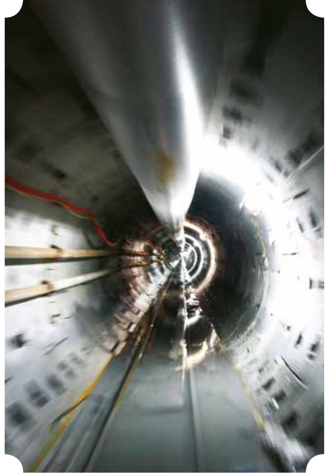
İSKİ Atık Su Tünel Çalışmaları
