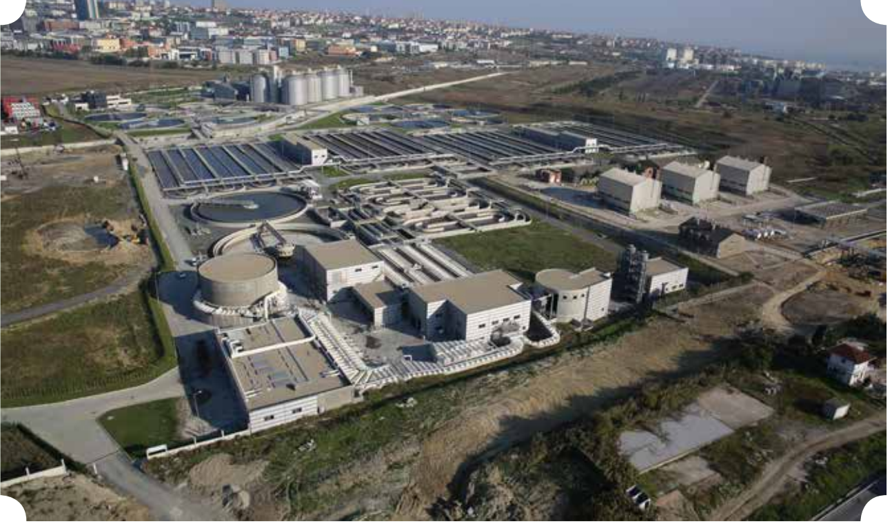
Ambarlı İleri Biyolojik Atık Su Arıtma Tesisi
