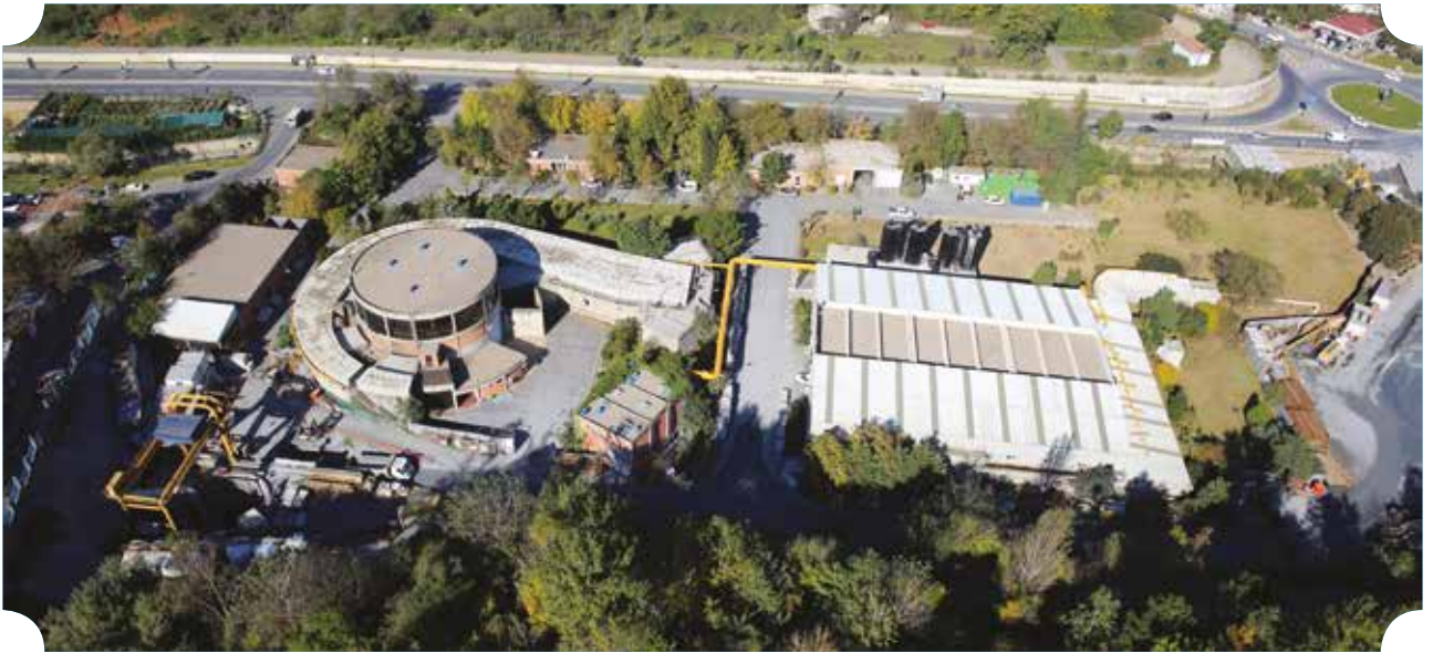
Baltalımanlı Atık Su Ön Arıtma Tesisi
