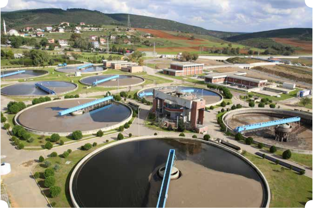
Paşaköy İleri Biyolojik Atık Su Arıtma Tesisi
