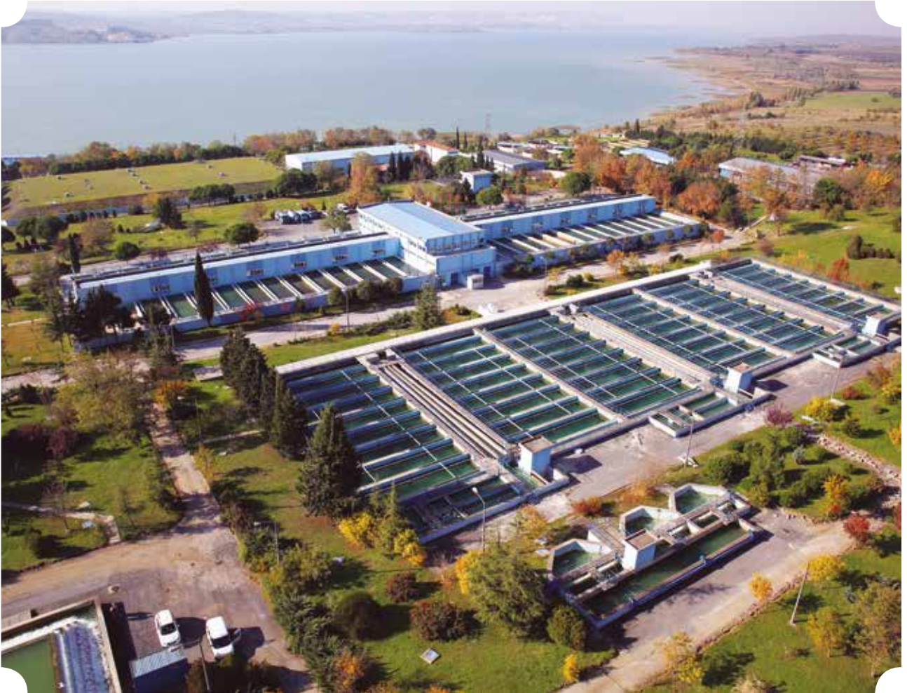
Büyükçekmece İçme Suyu Arıtma Tesisi
