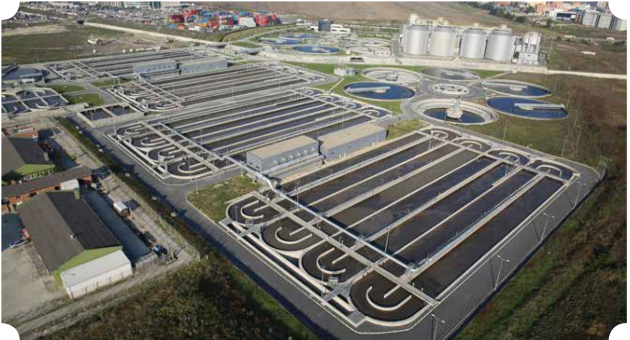
Ambarlı İleri Biyolojik Atık Su Arıtma Tesisi
