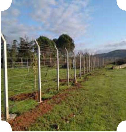
Havza Alanlarındaki Tel Çit Çevreleme Çalışmaları
