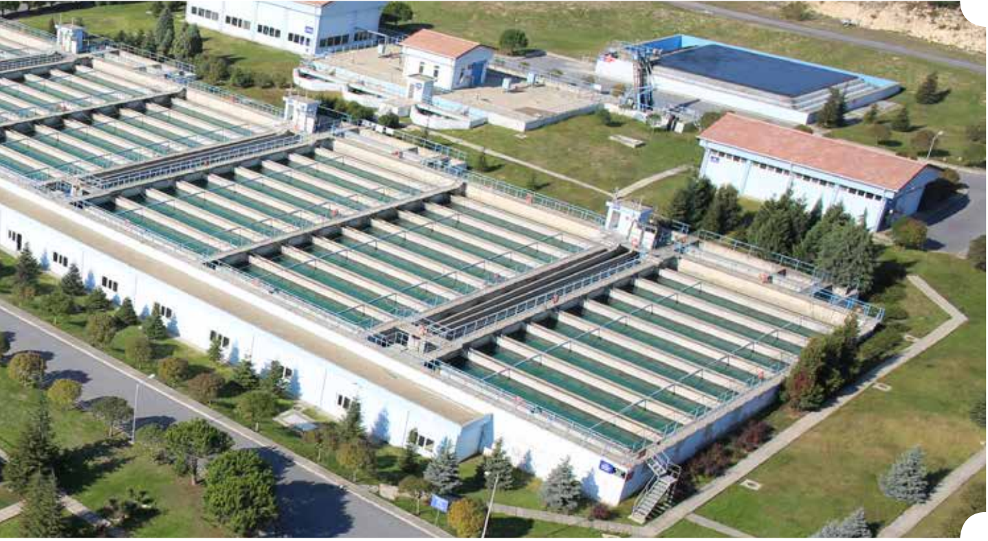
İkitelli Çıme Suyu Arıtma Tesisi
