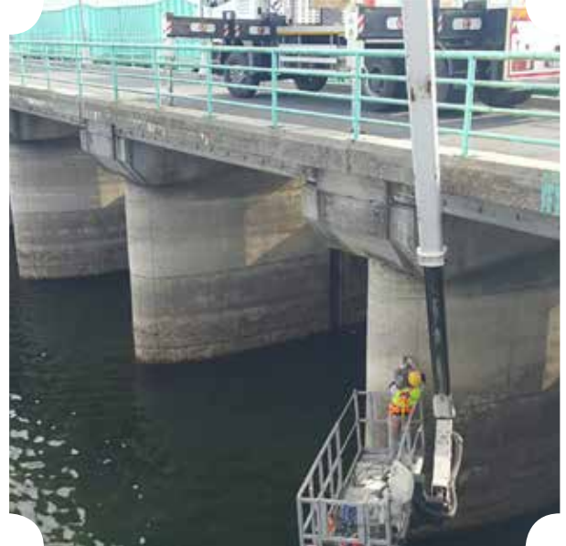
Büyükçekmece Barajı Karot Numunesi Alımı
