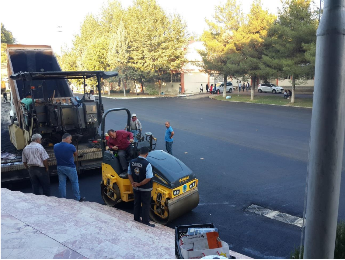
Merkez Kampüs Altyapı İşleri
