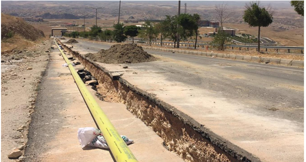
Doğal Gaz Ana Hat Yapım İşİ
